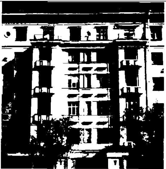
ризалиты фасада по Авиационной ул. на высоту 1-6-го этажей в три оси, в крайних осях лоджии на высоту 2-5-го этажей, карниз между 5 и 6 этажом, над осями лоджий замковые камни, ниша в средней оси полуциркульная в плане на высоту 2-5-го этажей; ограждение лоджий бетонное с балюсинами и лепными композициями в центральных тумбах балконы с бетонным ограждением с балюсинами, тумбами и лепными композициями в центральных тумбах, филенки в нижней части балконных плит;
