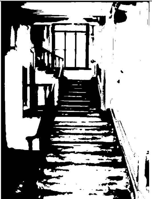
лестница корпуса по Столярному пер. (по 13 оси) – местоположение, габариты, конфигурация, тип (многомаршевая), конструкция (на косоурах), материал ступеней («путинская» плита), ограждение – материал (металл), техника исполнения (литъе), рисунок; поручень – материал (дерево), профиль.
