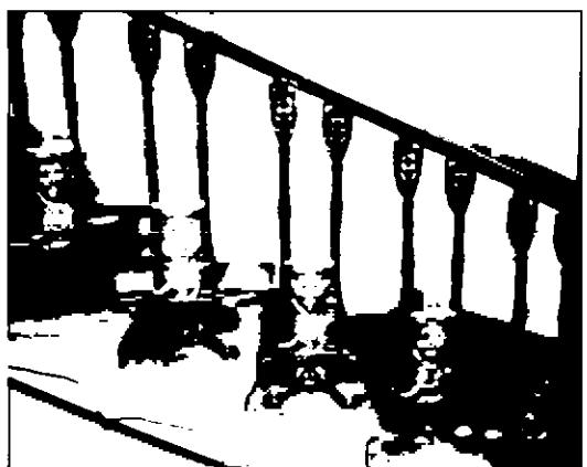
парадная лестница корпуса по наб. кан. Грибоедова (в осях 7-9) – местоположение, габариты, конфигурация, тип (распашная), конструкция (на косоурах). материал ступеней («путинская» плита), ограждение – материал (металл), техника исполнения (литъе), рисунок; поручень – материал (дерево), профиль;
