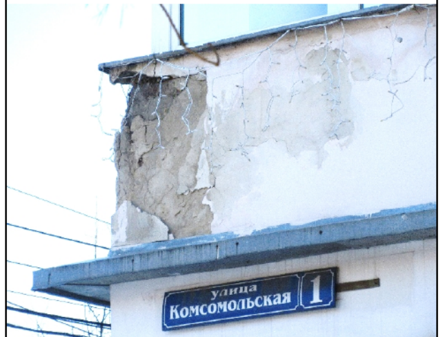
Фрагмент козырька над входом
