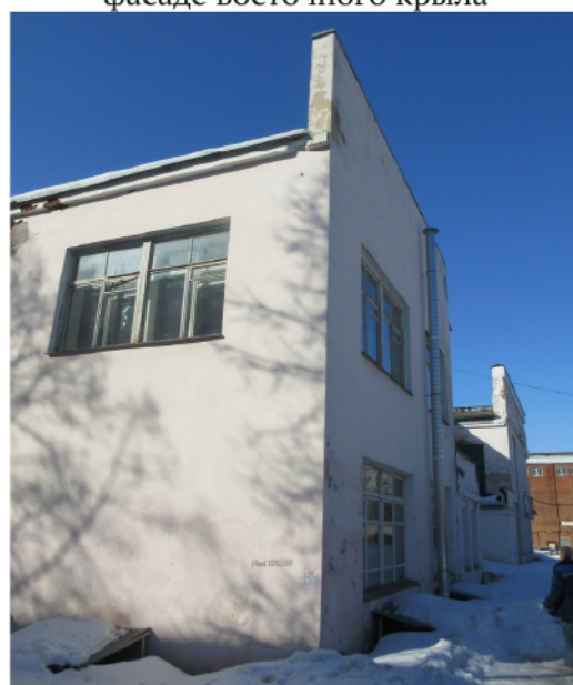
Парапетная стенка в восточной части северо-восточного фасада углового объема
