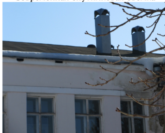
Фрагмент крыши на северо-западном фасаде восточного крыла
