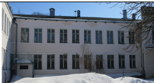
Фрагмент северной части северо-западного фасада восточного крыла
