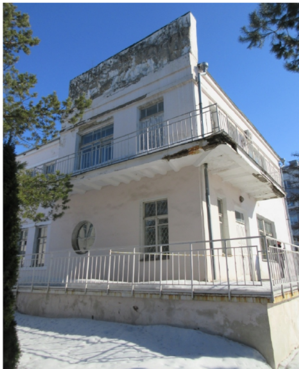
Вид с юго-запада. Угловой балкон
