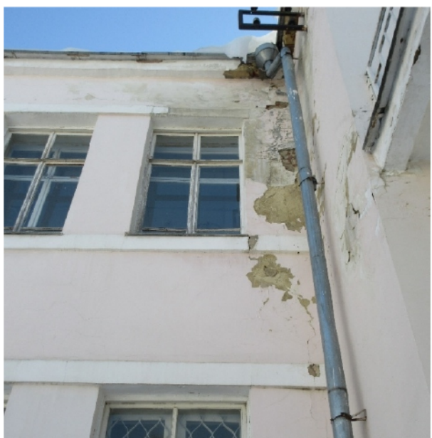
Фрагмент северо-западного фасада в месте примыкания выступающего прямоугольного в плане объема. Карниз, подоконный и надоконные пояса
