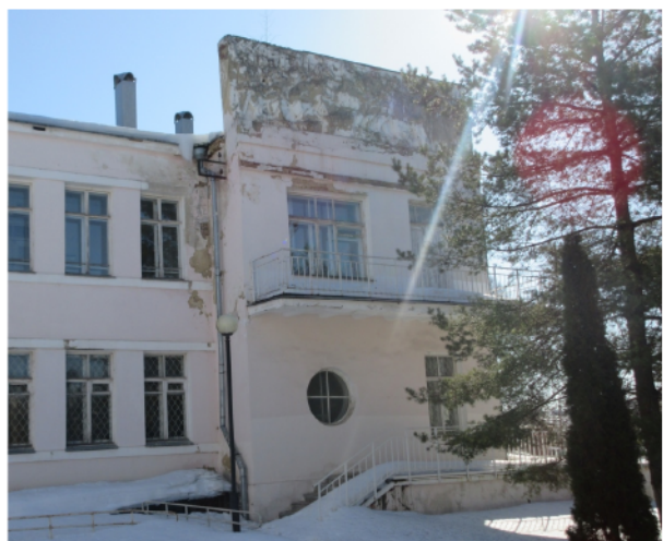
Фрагмент южной части северо-западного фасада восточного крыла и выступающего прямоугольного в плане объема
