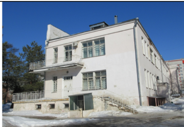
Вид с юга на юго-западный фасад восточного крыла
