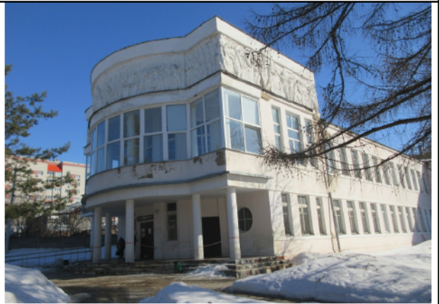
Общий вид здания с запада
