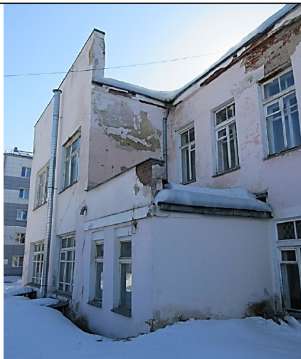
Фрагмент северо-восточного фасада углового северо-восточного объема северного крыла
