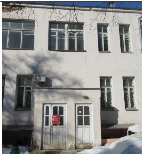
Центральная часть юго-восточного фасада восточного крыла
