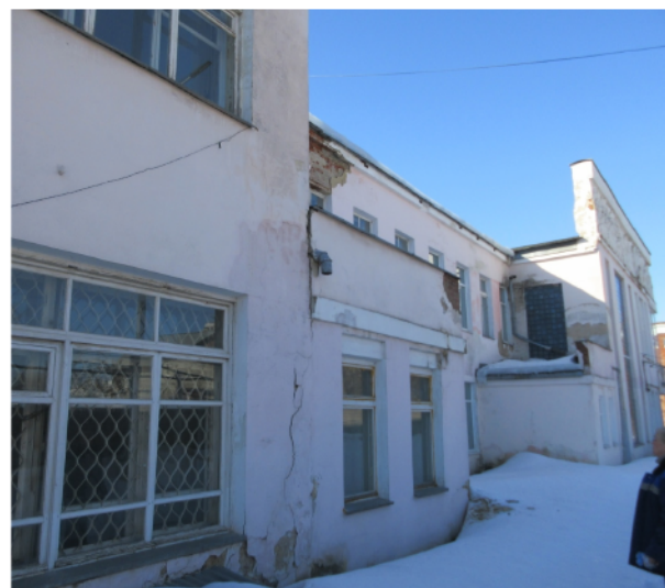
Фрагмент северо-восточного фасада северного крыла
