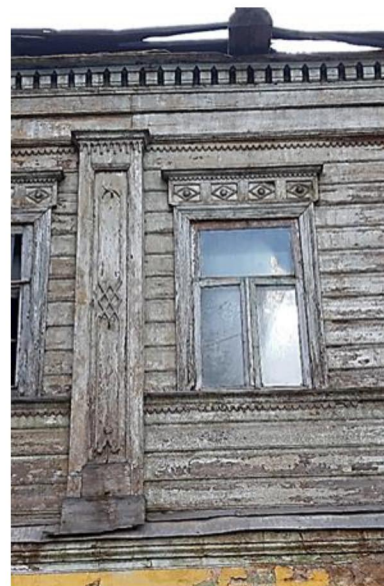
Фрагмент 2-го этажа. Рядовая пилястра, окно с сандриком, фриз и карниз
