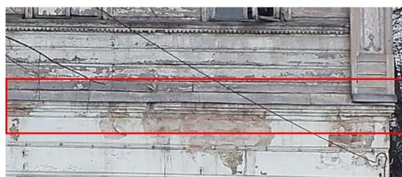
Фрагмент фасада по ул. Пушкинская. Междуэтажный карниз
