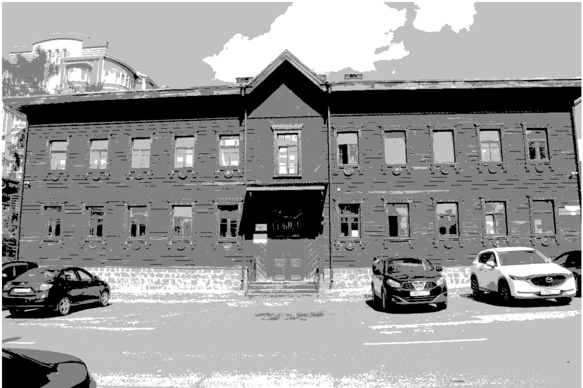
Видовая точка № 3. Вид главного юго-западного фасада здания
