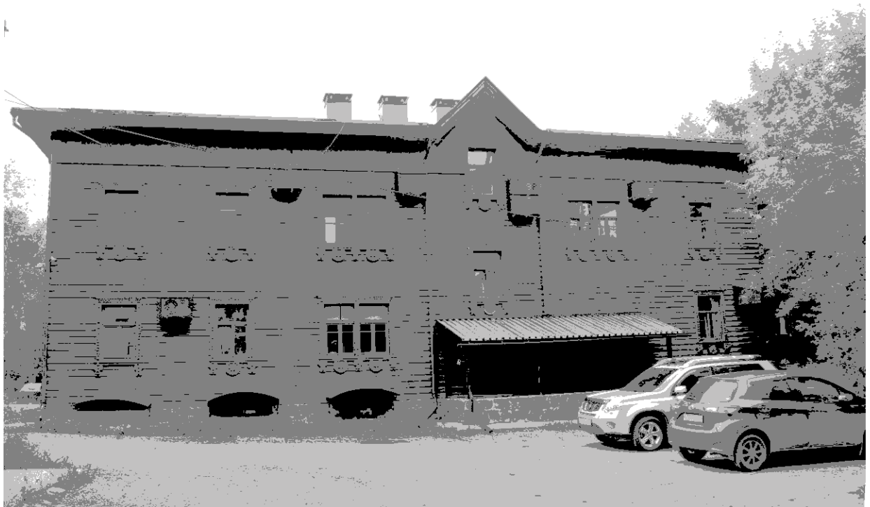
Видовая точка № 6. Общий вид дворового восточного фасада здания
