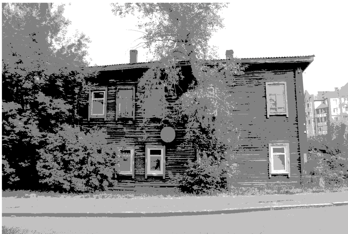
Видовая точка № 3. Общий вид южного фасада здания
