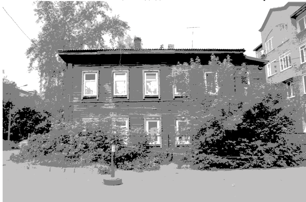
Видовая точка №2. Общий вид восточного фасада здания
