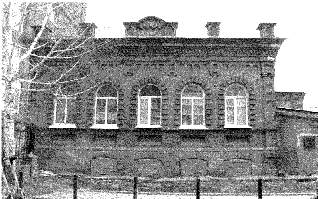
Видовая точка № 1. Главный западный фасад здания. Вид с пер. Типографского
