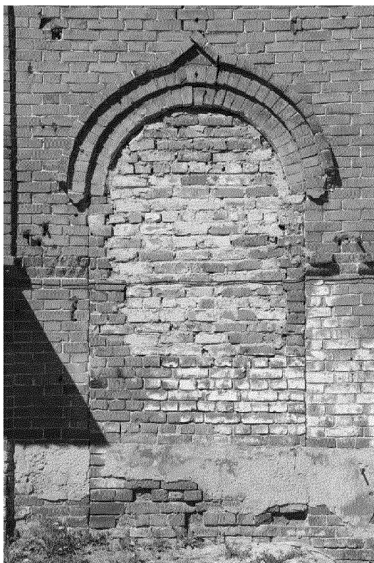
Видовая точка № 27. Арочный дверной проем выступающего объёма парадного входа южного фасада (заложён)
