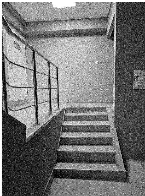
Видовая точка № 30. Лестница в западной части здания (1 этаж)
