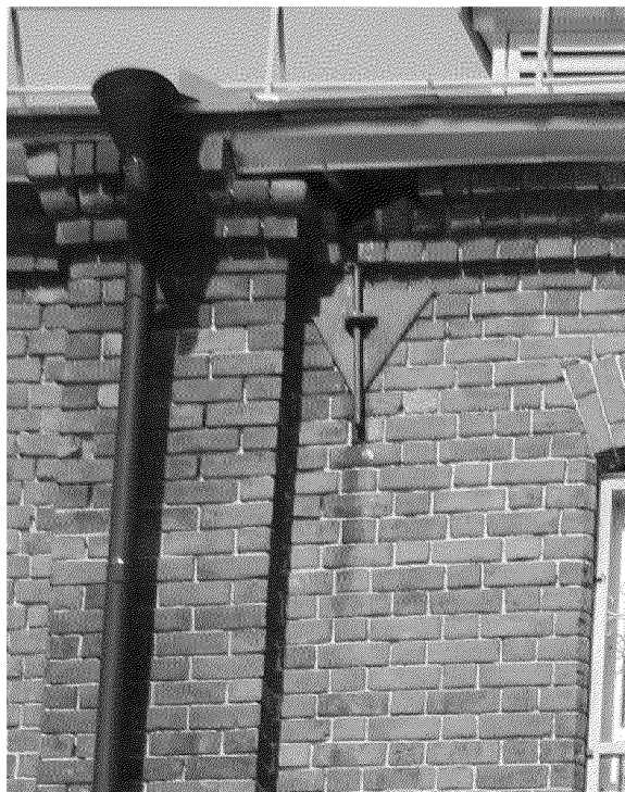
Видовая точка № 18. Фрагмент южного фасада здания, металлические тяжи (анкерные тяжи)
