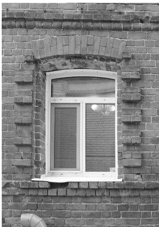
Видовая точка № 20. Оконный проём с лучковой перемычкой северного фасада здания
