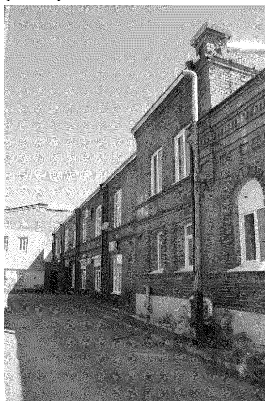
Видовая точка № 7. Фрагмент северного фасада здания
