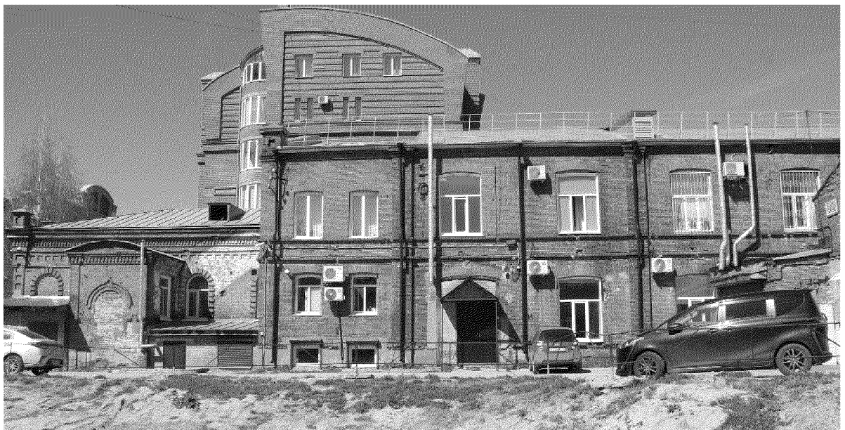
Видовая точка № 4. Фрагмент южного фасада здания. Общий вид с территории двора
