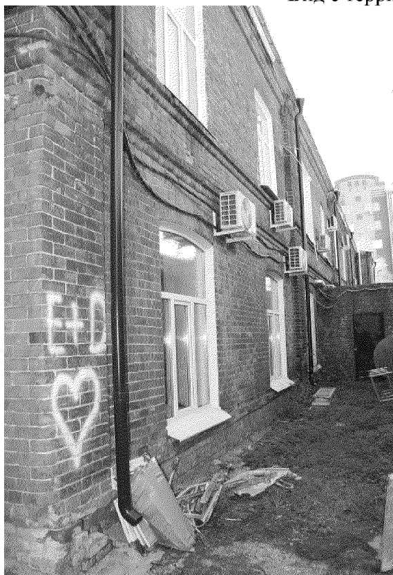
Видовая точка № 6. Фрагмент северного фасада здания
