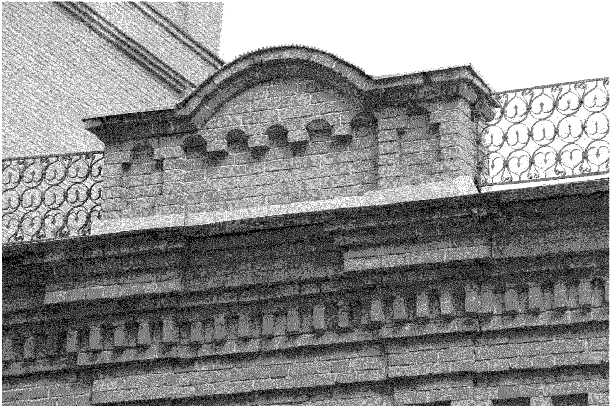
Видовая точка № 15. Аттик и элементы декора карниза западного фасада здания
