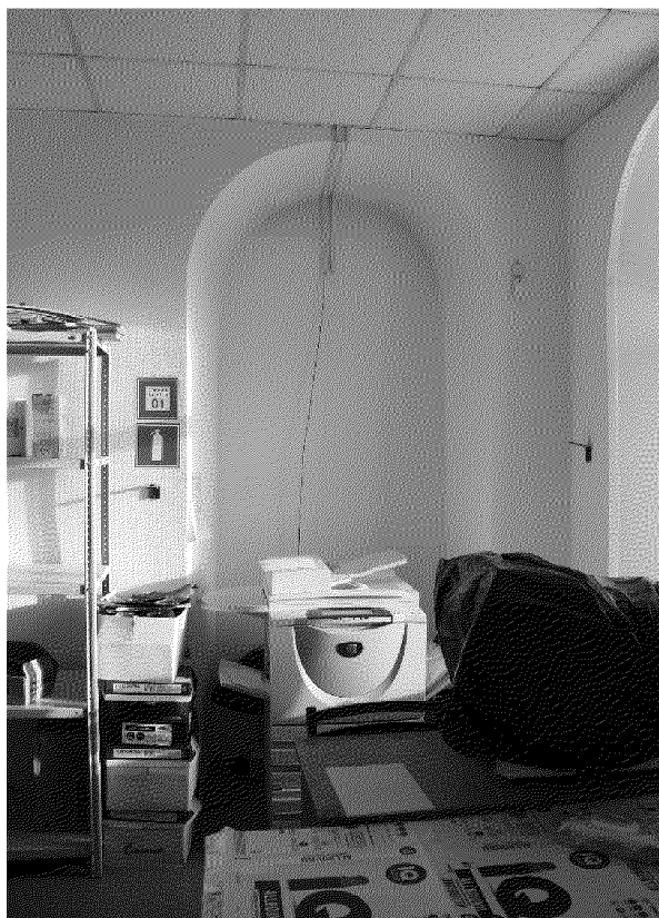
Видовая точка № 29. Арочный проем (частично заложен) в помещении первого этажа
