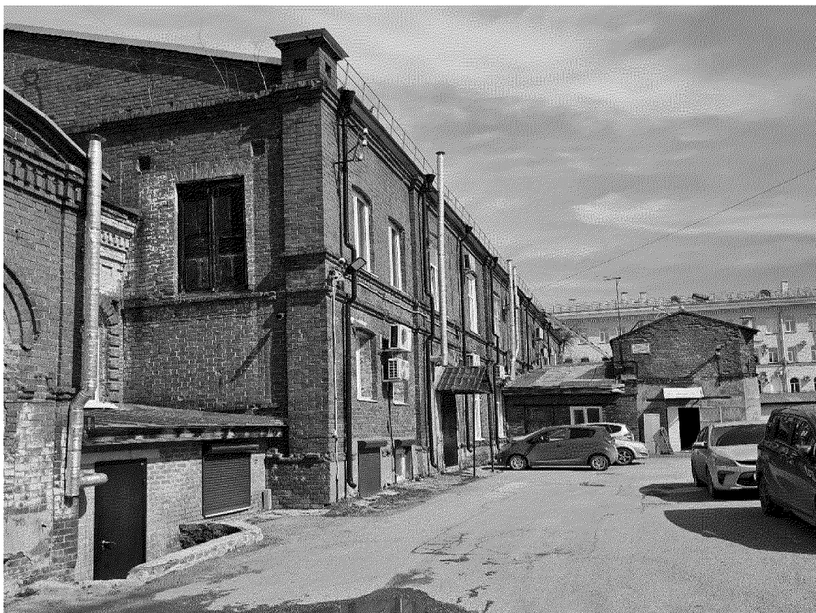
Видовая точка № 5. Общий вид здания, с одноэтажными пристройками. Вид с территории двора
