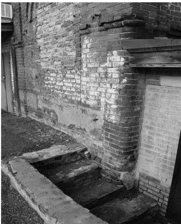
Видовая точка № 17. Оформление углов выступающего объёма парадного входа лопатками и фрагмент бутового фундамента
