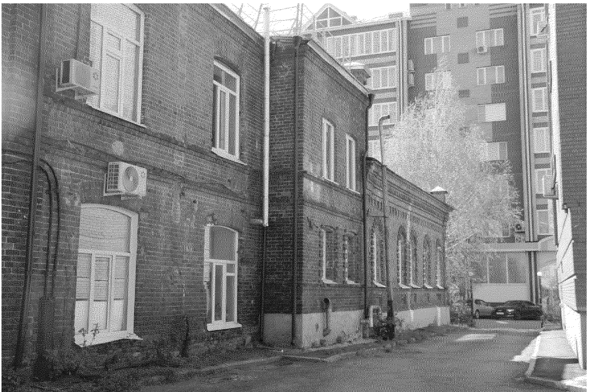
Видовая точка № 9. Фрагмент северного фасада здания
