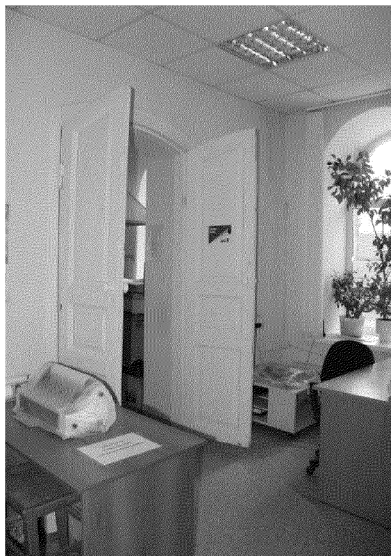
Видовая точка № 28. Деревянная двупольная филённая дверь с коробкой в помещении первого этажа одноэтажного объёма здания
