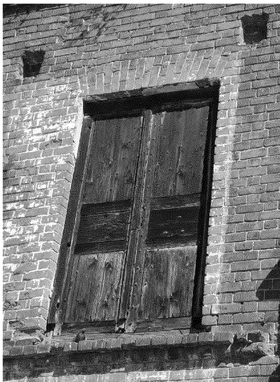
Видовая точка № 25. Деревянная двупольная филённая дверь с коробкой на западном фасаде двухэтажного объёма (2 этаж)
