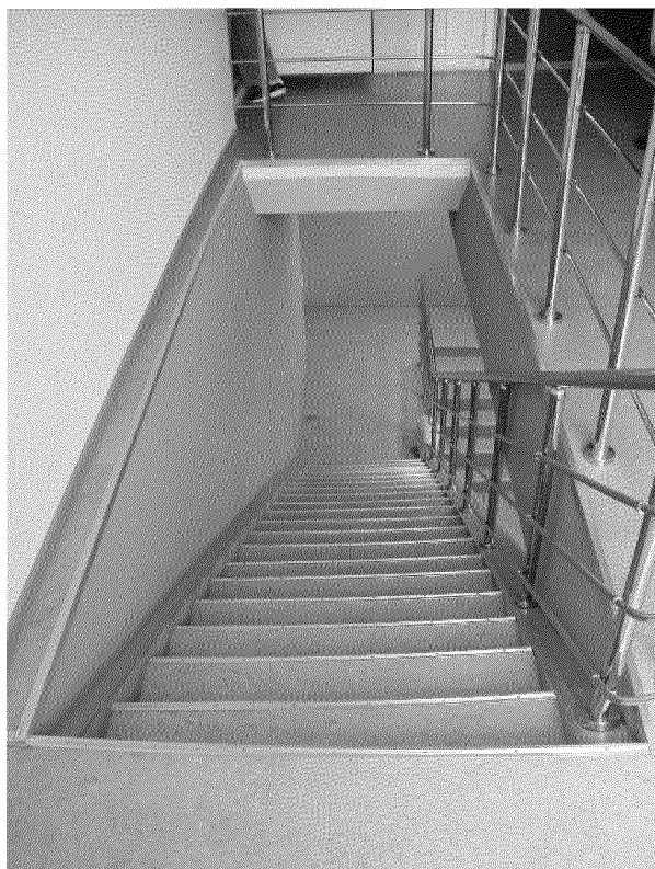
Видовая точка № 31. Лестница в западной части здания (2 этаж)
