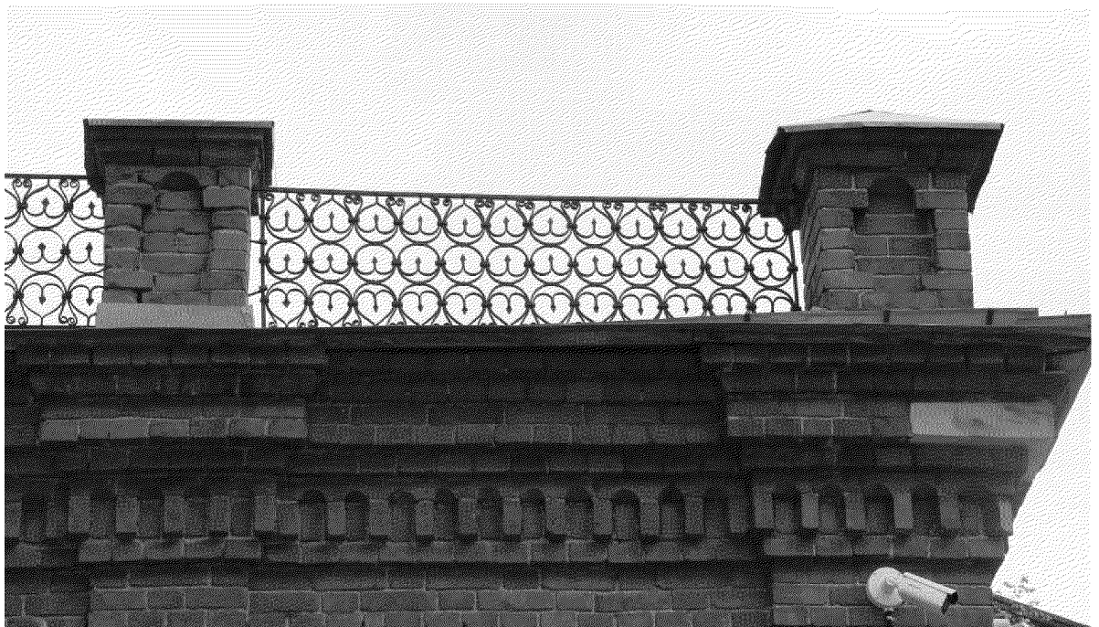
Видовая точка № 16. Фрагмент карниза и парапетного ограждения западного фасада здания. Угловые плиты из песчаника в конструкции карниза.
