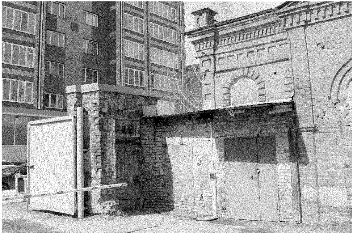
Видовая точка № 11. Фрагмент ворот. Вид с территории двора
