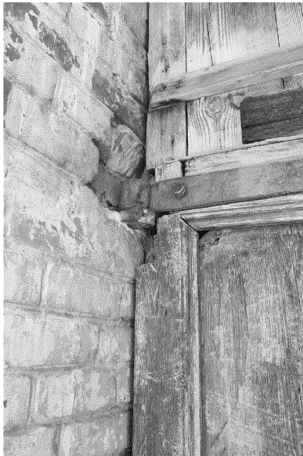
Видовая точка № 13. Фрагмент крепления двери калитки на кованые подставы, установленные в кладку на блоки из песчаника
