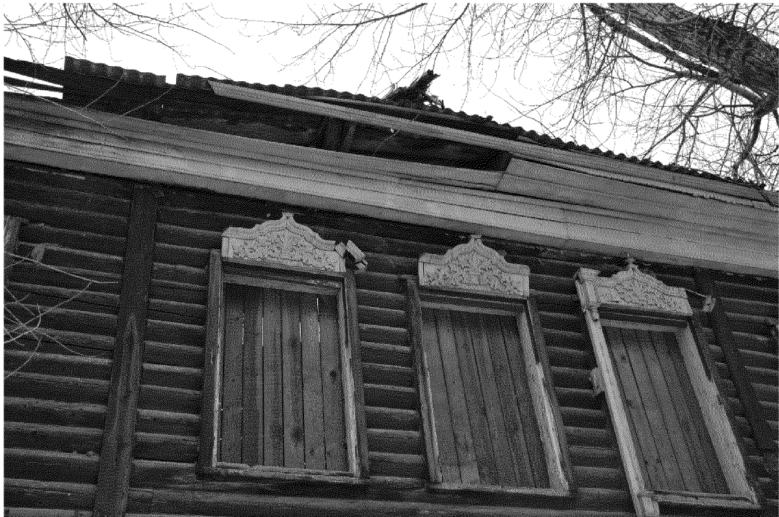
Видовая точка № 4. Фрагменты наличников окон 2-го этажа западного фасада (Матвеева Ю.С., 21.04.2026)
