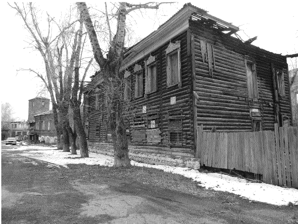
Видовая точка № 2. Общий вид здания с ул. Центральной (Артюховский Г.Т., 23.04.2025)
