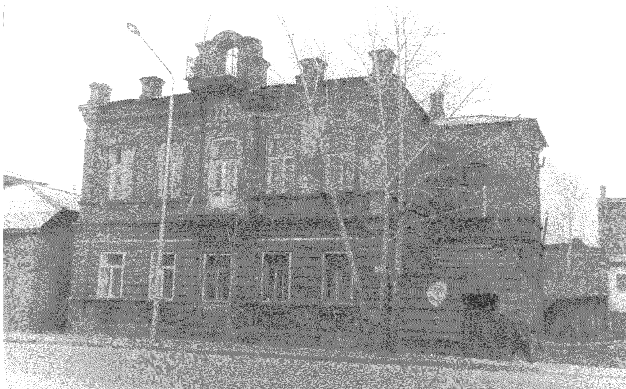
Видовая точка № 5. Общий вид здания с юго-западной стороны (до восстановления), фото 1989 г.
