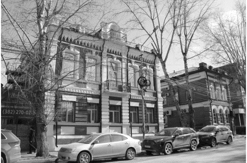
Видовая точка № 1. Общий вид здания в строчке застройки ул. К. Маркса
