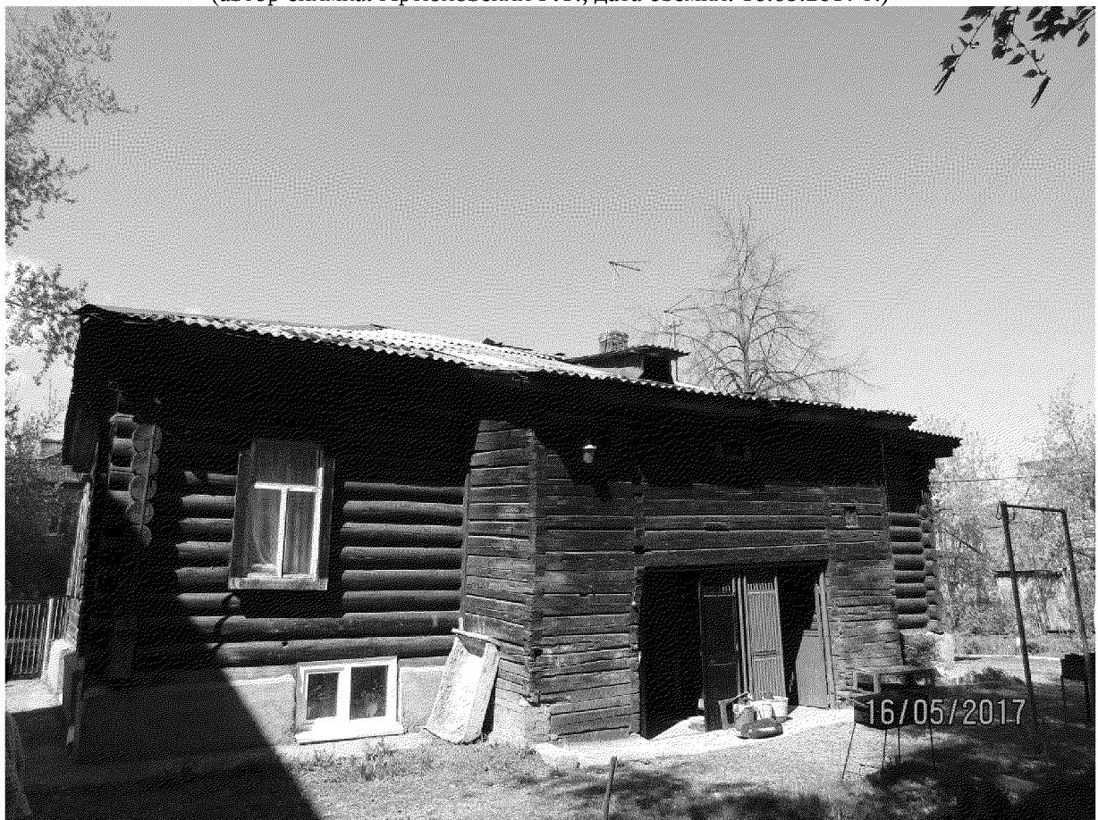
Видовая точка № 4. Дворовый (восточный) фасад. (автор снимка: Артюховский Г.Т., дата съемки: 16.05.2017 г.)
