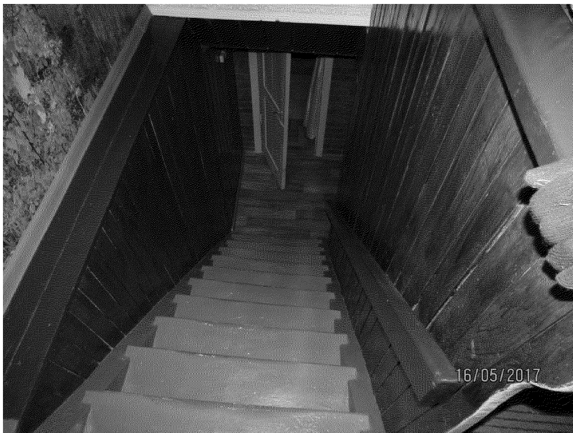
Видовая точка № 9. Деревянная лестница спуска в подвал (Артюховский Г.Т., 16.05.2017 г.)
