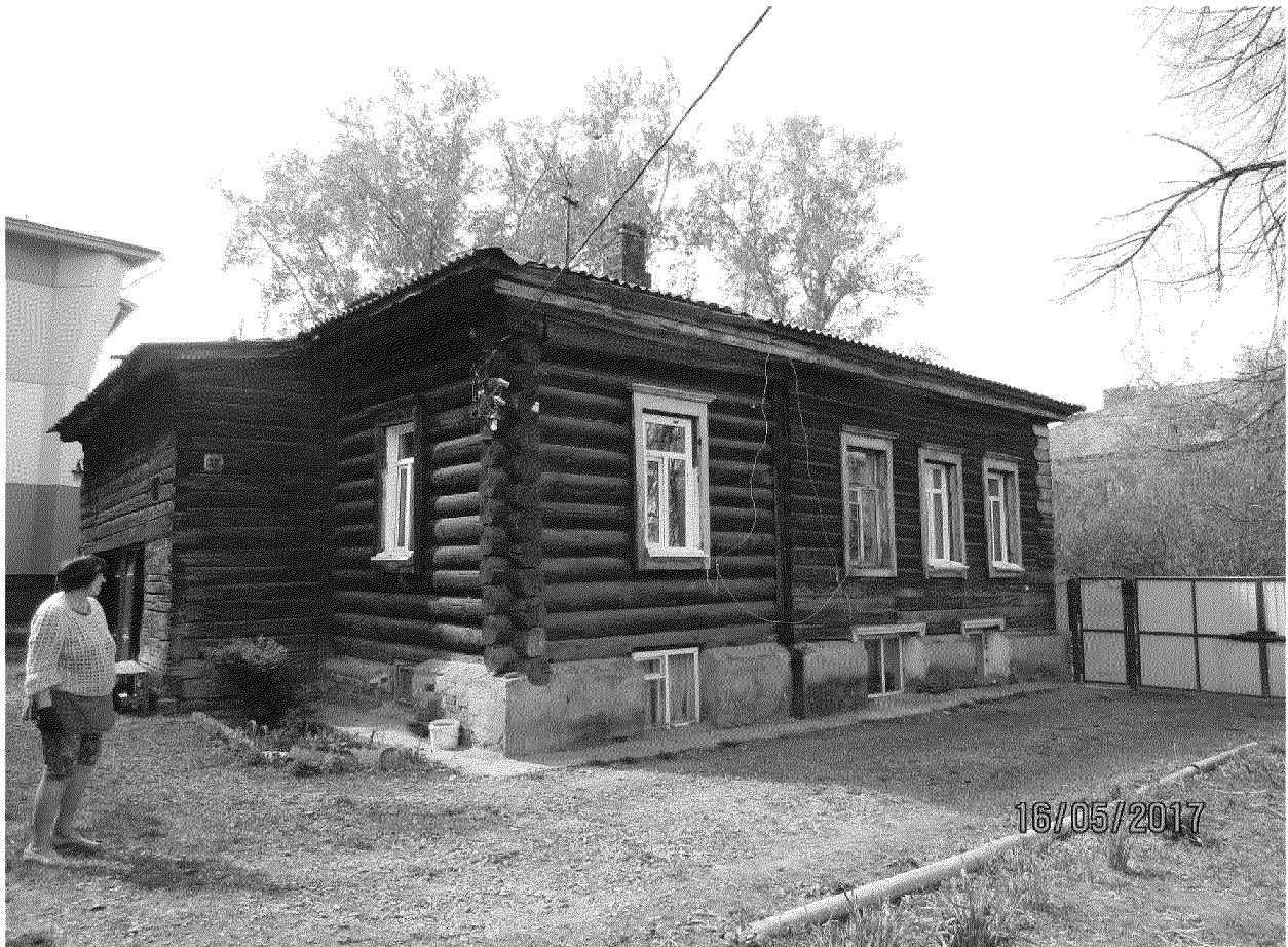
Видовая точка № 3. Боковой (северный) фасад. (автор снимка: Артюховский Г.Т., дата съемки: 16.05.2017 г.)
