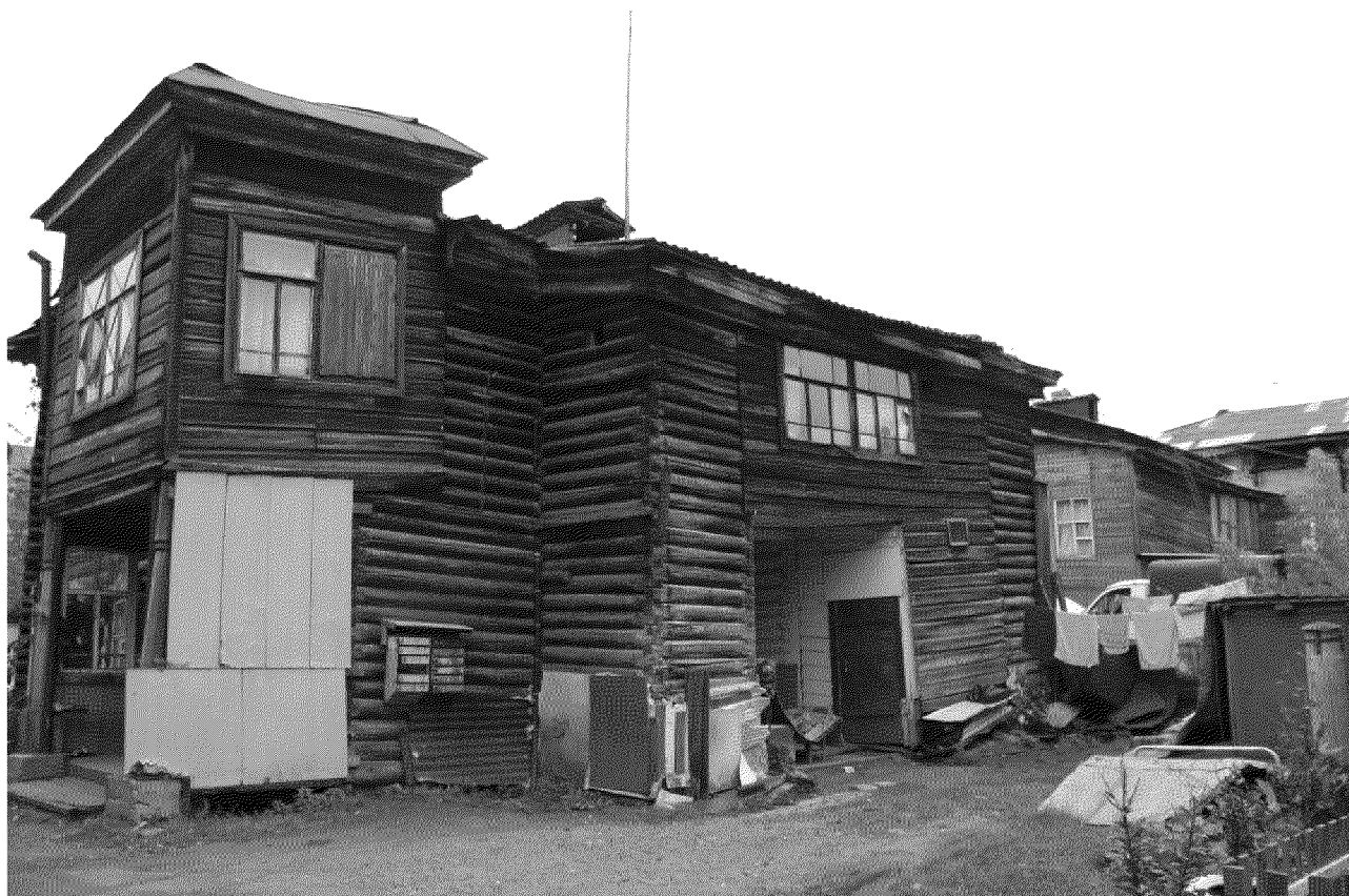
Видовая точка № 3. Западный (дворовый) фасад здания. Вид с территории двора.
