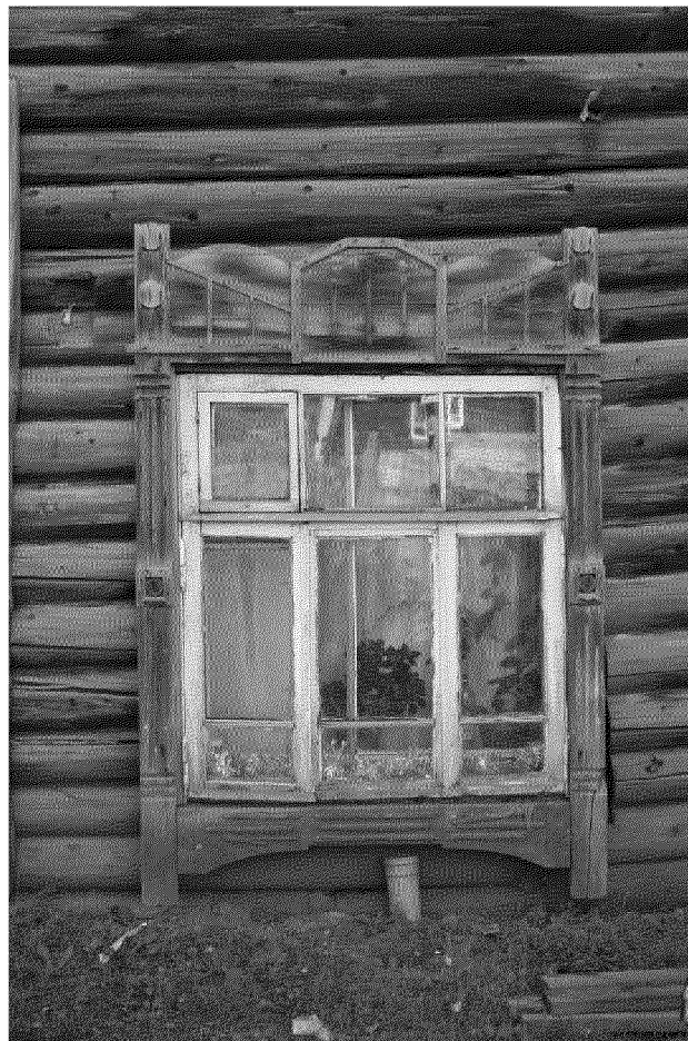
Видовая точка № 5. Окно 1-го этажа северного фасада
