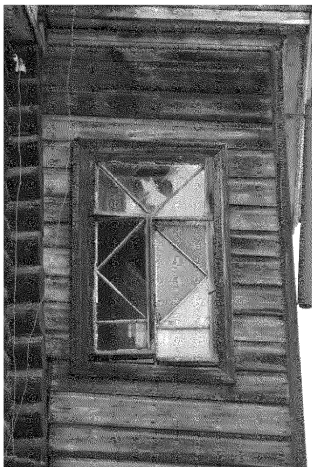
Видовая точка № 7. Фрагмент восточного фасада эркера. Окно 2-го этажа
