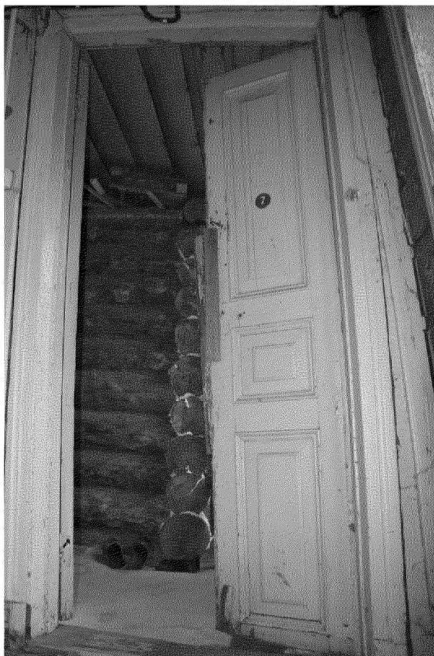
Видовая точка № 15. Дверь пристройки лестничного блока (Воловодова О.В., 2014 г.)
