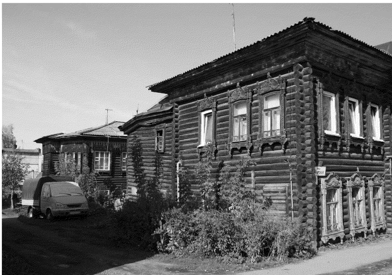
Видовая точка № 4. Южный фасад здания. Вид со стороны дворового проезда соседней усадьбы по ул. Татарская, 33, 33/1
