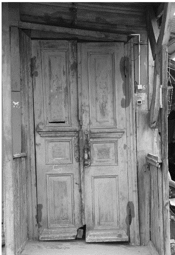
Видовая точка № 12. Деревянная филенчатая дверь основного входа
