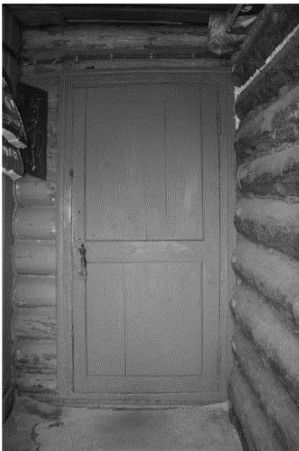
Видовая точка № 14. Деревянная дверь входа на этаж (Воловодова О.В., 2014 г.)
