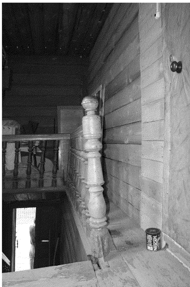
Видовая точка № 10. Лестница основного входа (2-й этаж). (Воловодова О.В., 2014 г.)
