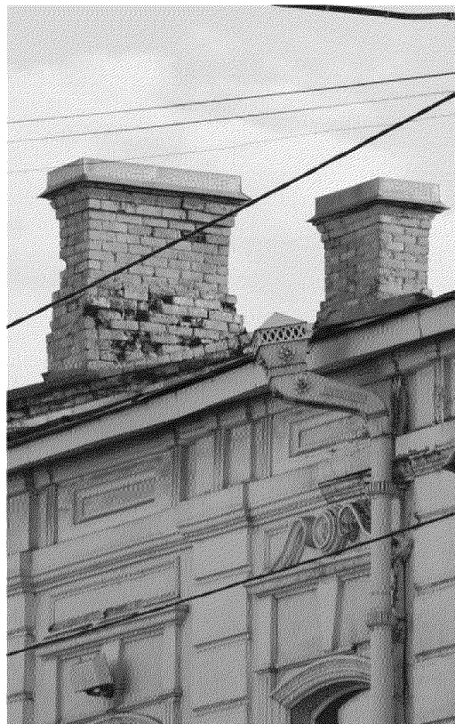
Видовая точка № 7. Кирпичные дымовые трубы (Яблонская М.А., 28.08.2020)
