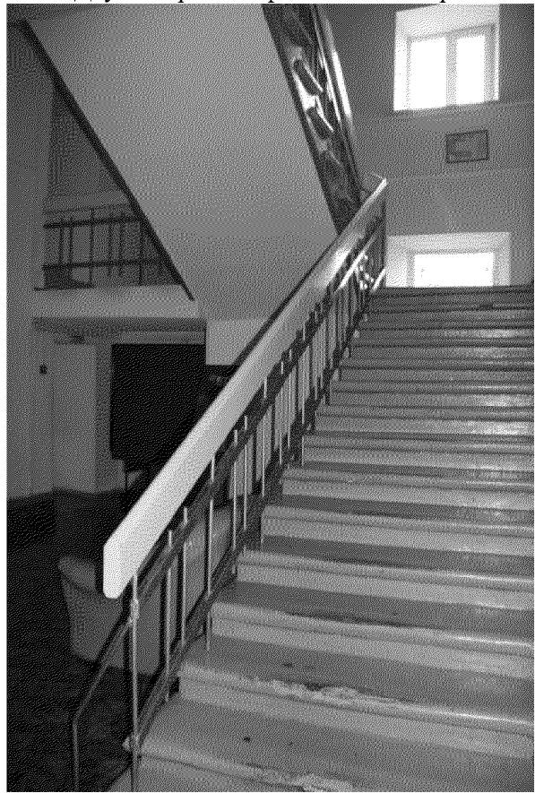
Видовая точка № 34. Лестница двухмаршевая (песчаник)
