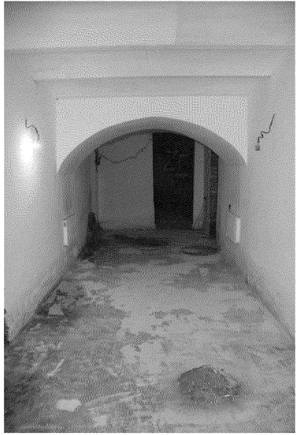
Видовая точка № 42. Помещение подвала (Ленина пр., 78/ Нахановича пер., 5). Лучковая арка, кирпичные своды по металлическим балкам
