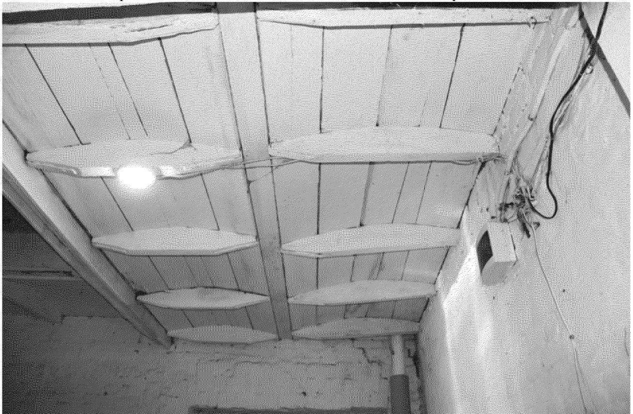
Видовая точка № 67. Помещение 1-го этажа пристройки, вид на конструкцию лестничной площадки (предположительно сохранившаяся деревянная опалубка под кирпичные своды по металлическим балкам)
