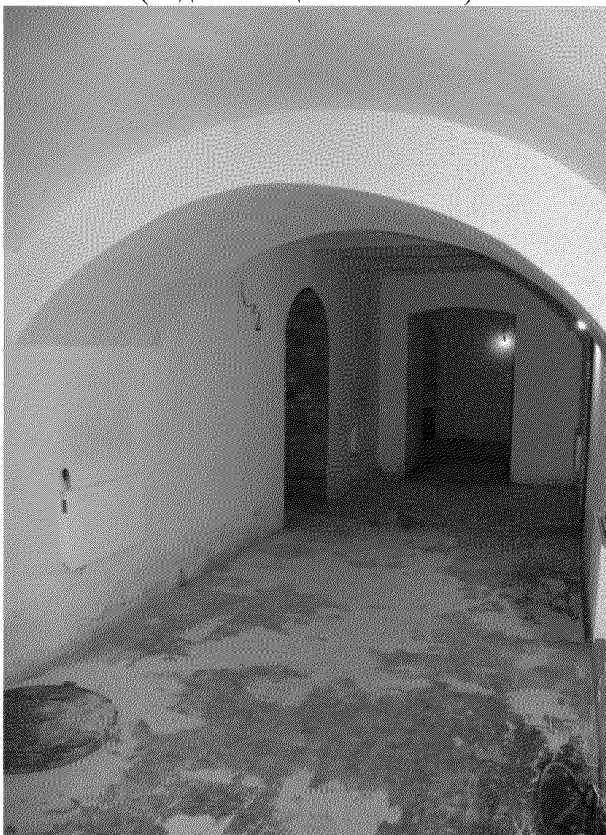
Видовая точка № 43. Помещение подвала с кирпичным коробовым сводом и лучковой аркой (Ленина пр., 78/Нахановича пер., 5)
