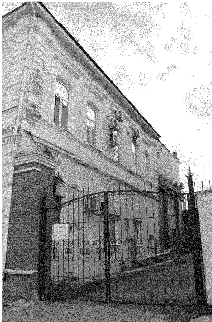
Видовая точка № 5. Западный (торцевой) фасад здания (Яблонская М.А., 28.08.2020)
