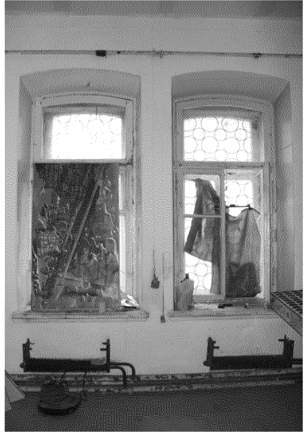
Видовая точка № 53. Оконные проемы с откосами и профильными подоконными досками
