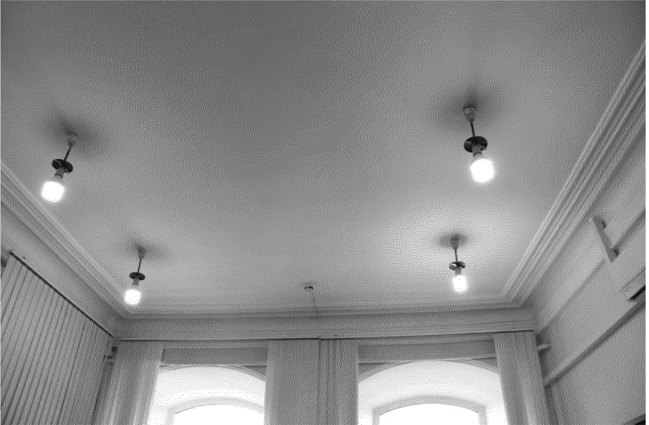
Видовая точка № 29. Профильные потолочно-стенные тяги в помещении 2-го этажа
