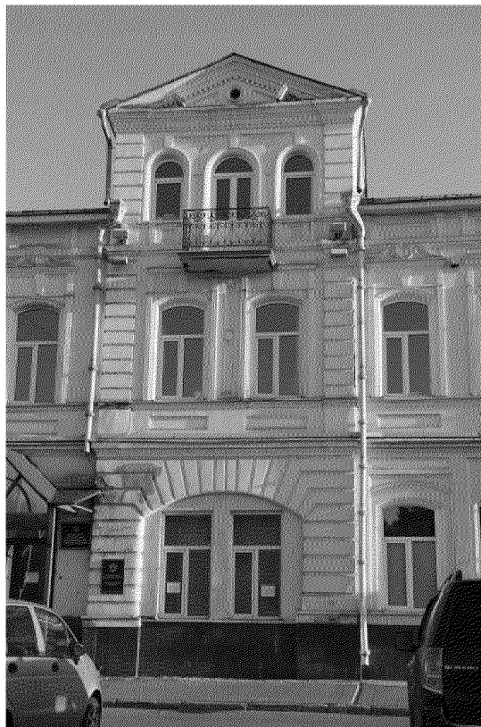
Видовая точка № 6. Фрагмент северного фасада, мезонин и проезд во двор (заложен). Вид с пер. Нахановича
