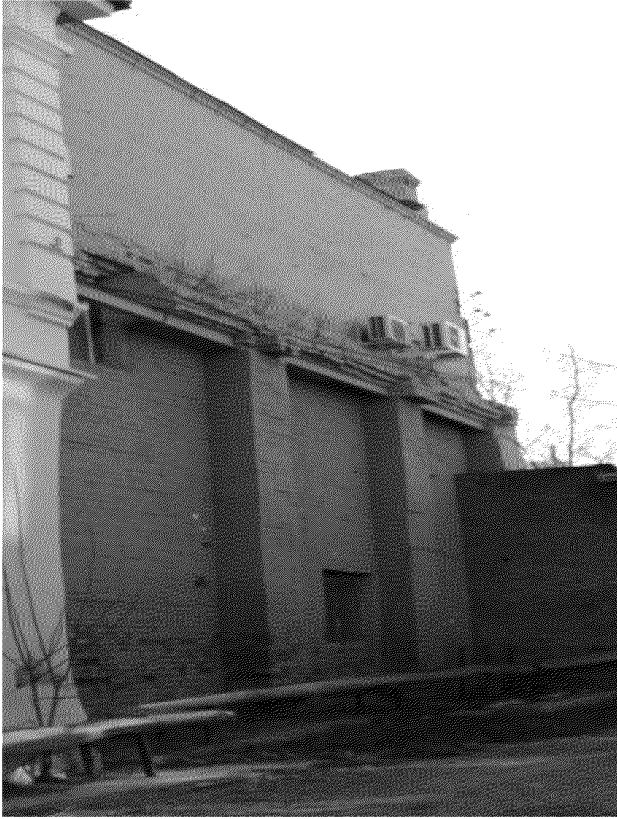
Видовая точка № 48. Западный фасад (брандмауэрная стена) с пилонами 2-х этажной пристройки (пер. Нахановича, 3а)
