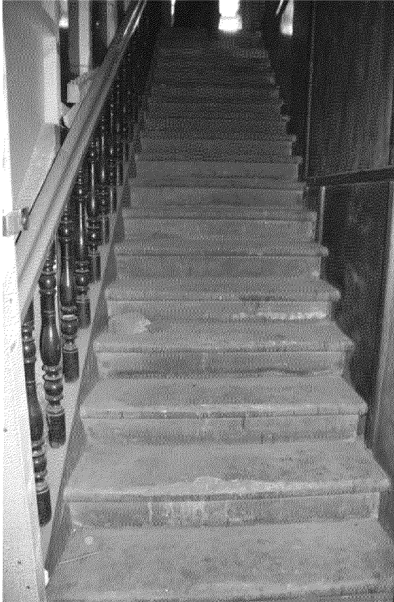
Видовая точка № 65. Двухмаршевая лестница (песчаник), лестничный марш на 2-й этаж
