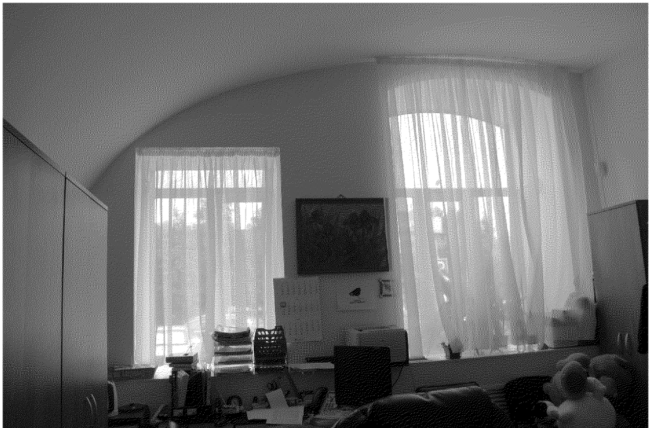
Видовая точка № 37. Помещение 1-го этажа перекрытое кирпичным коробовым сводом (Нахановича пер., 3а)
