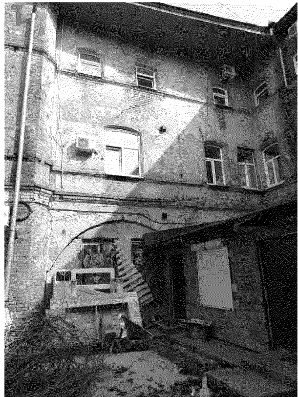
Видовая точка № 15. Дворовый фасад здания. Арочный проем сквозного проезда во двор
