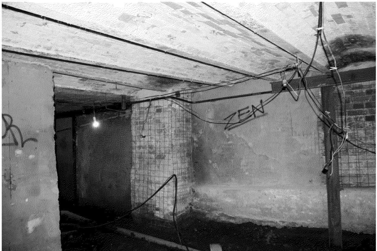
Видовая точка № 40. Помещение подвала (Нахановича пер., 3а). Кирпичные своды по металлическим балкам
