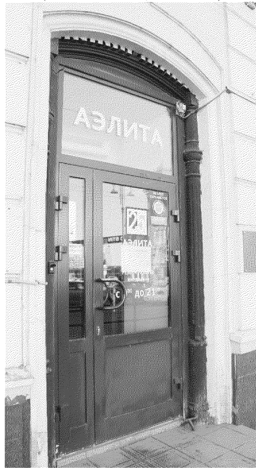
Видовая точка № 9. Деревянный декор дверного проема восточного фасада
