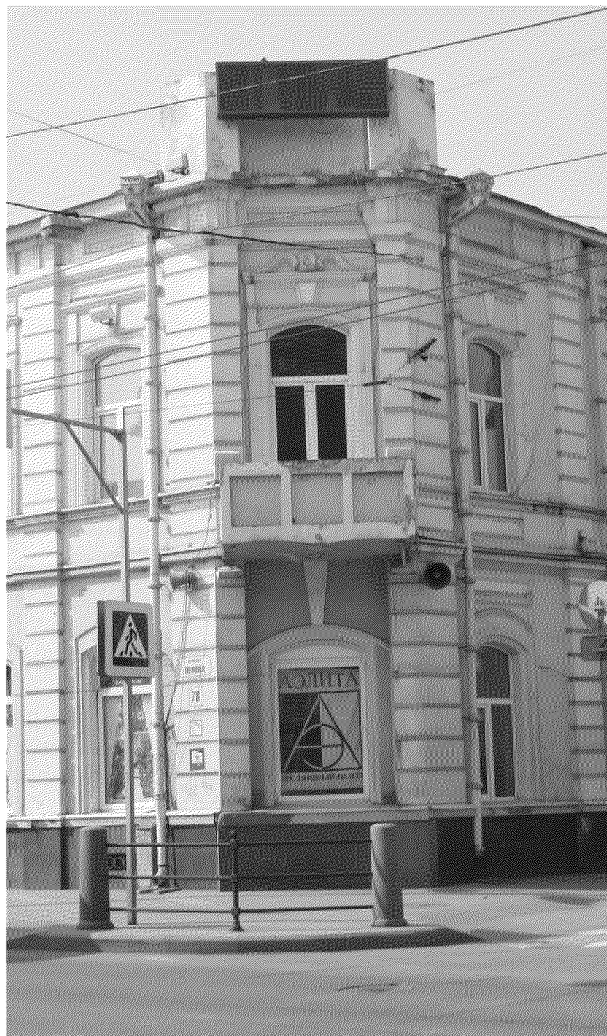
Видовая точка № 4. Северо-восточный угол здания
