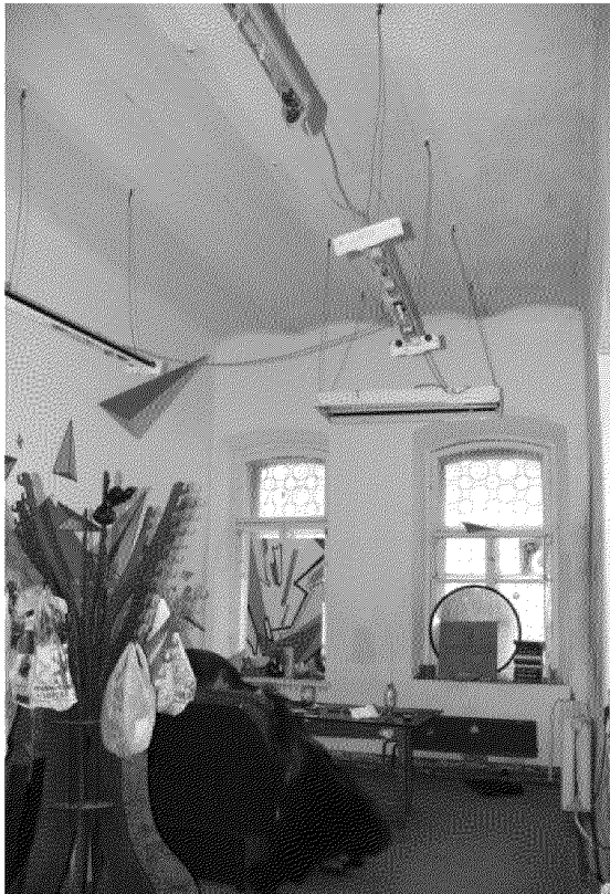
Видовая точка № 54. Кирпичные своды по металлическим балкам в помещении 1-го этажа
