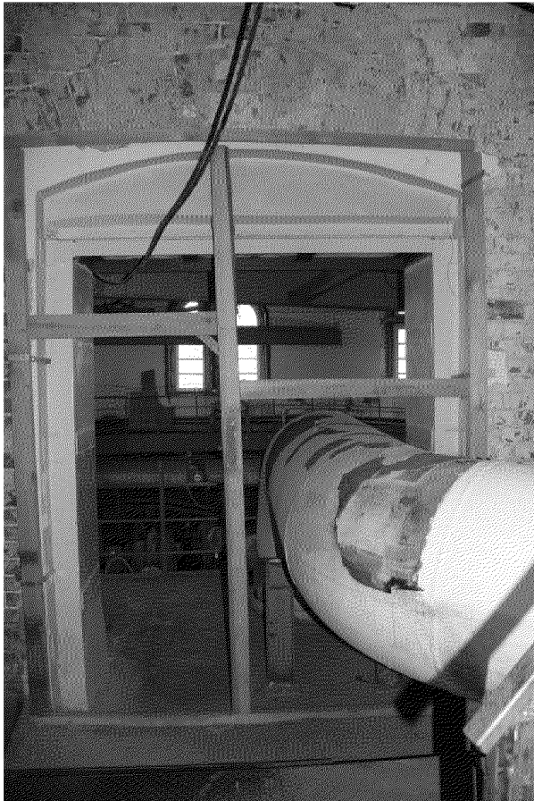
Видовая точка № 14. Проем с лучковой перемычкой перехода в корпус «резервуара»
