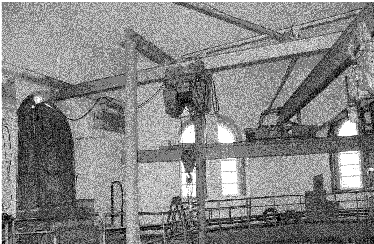
Видовая точка № 16. Общий вид помещения «резервуара» с восьмигранным сводом
