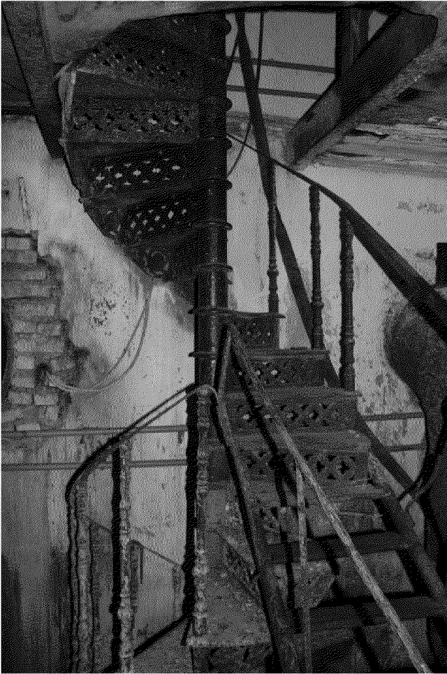
Видовая точка № 21. Винтовая лестница спуска в подвал
