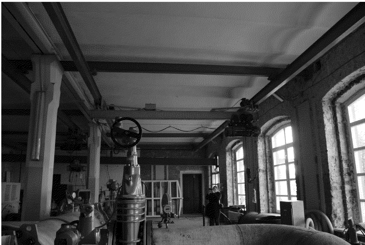
Видовая точка № 12. Общий вид помещения 1-го этажа центрального объема. Междуэтажное перекрытие из кирпичных сводов по металлическим балкам
