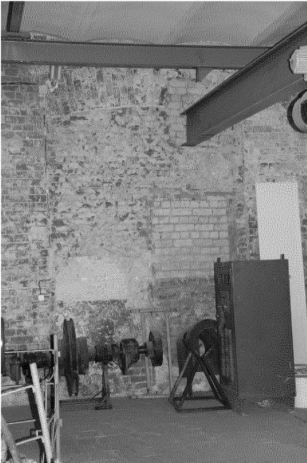
Видовая точка № 18. Заложенный оконный проем с лучковой перемычкой помещения 1-го этажа
