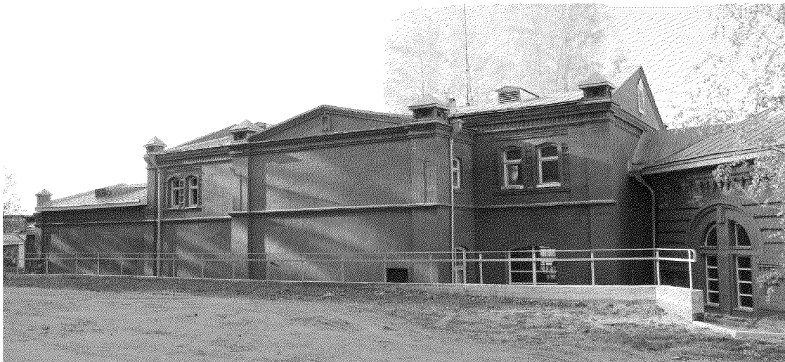
Видовая точка № 3. Дворовый (восточный) фасад здания
