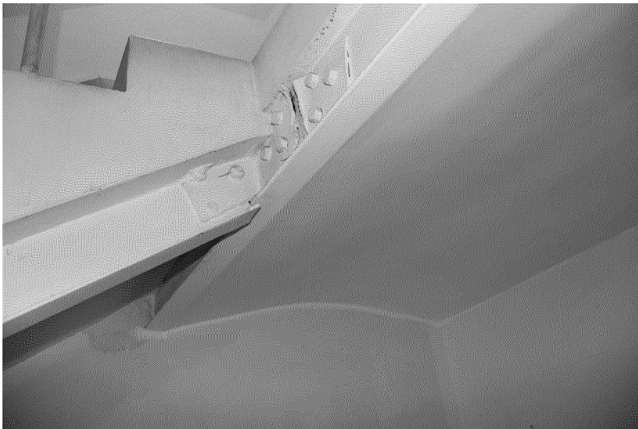
Видовая точка № 17. Кирпичный свод в конструкции междуэтажной площадки двух маршевой лестницы центрального объема здания (дворовой ризалит)
