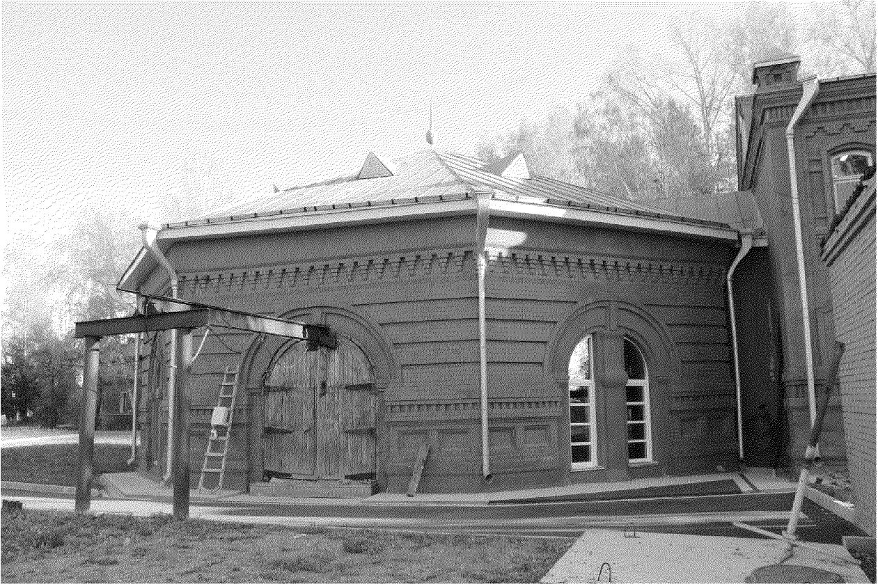
Видовая точка № 6. Фрагмент главного (западного) фасада здания (корпус резервуара)
