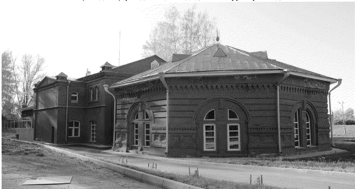
Видовая точка № 2. Общий вид здания с северной стороны
