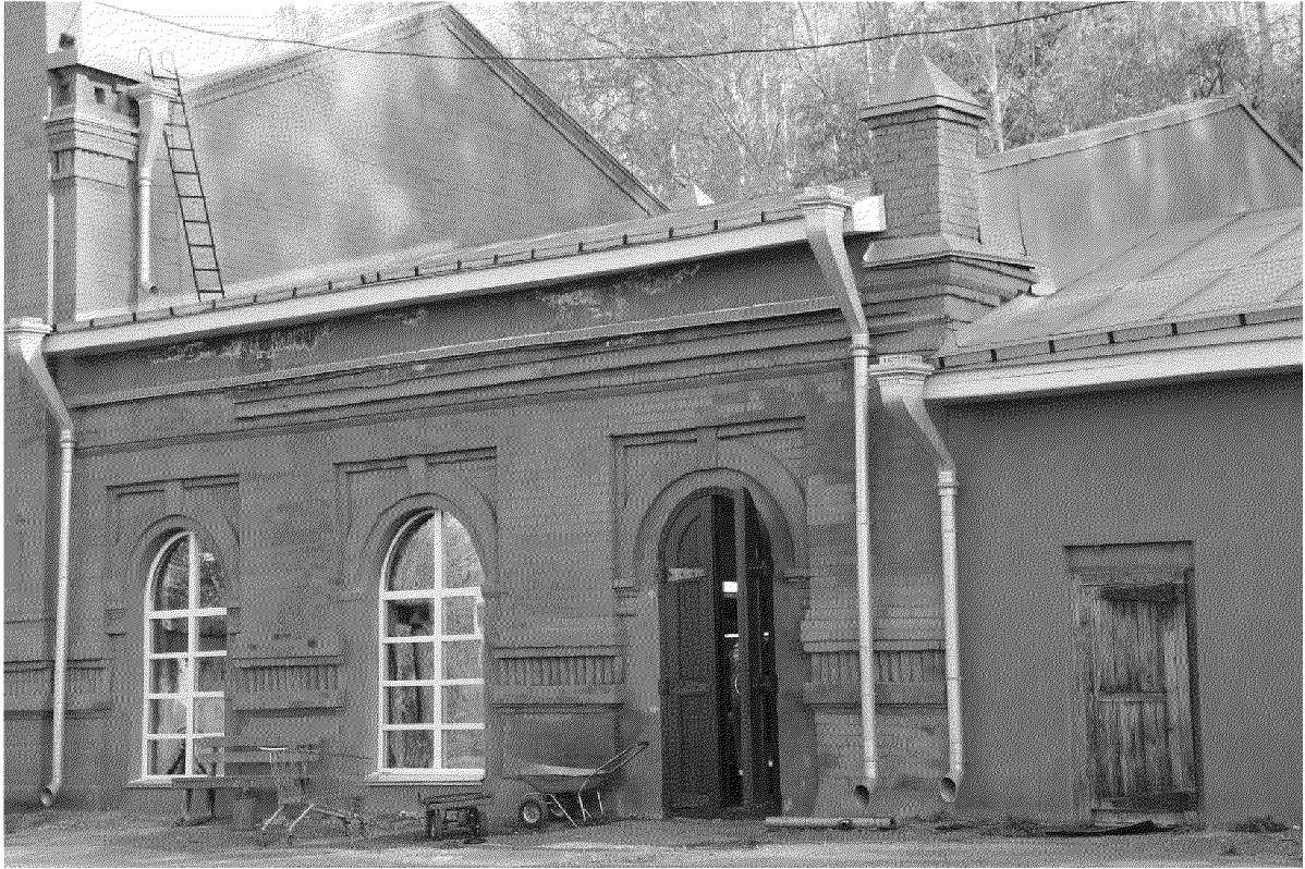
Видовая точка № 8. Фрагмент главного (западного) фасада здания (корпус бывшей «котельной»)
