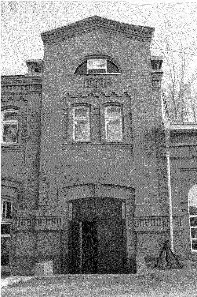
Видовая точка № 9. Фрагмент главного (западного) фасада здания. Ризалит центрального объема
