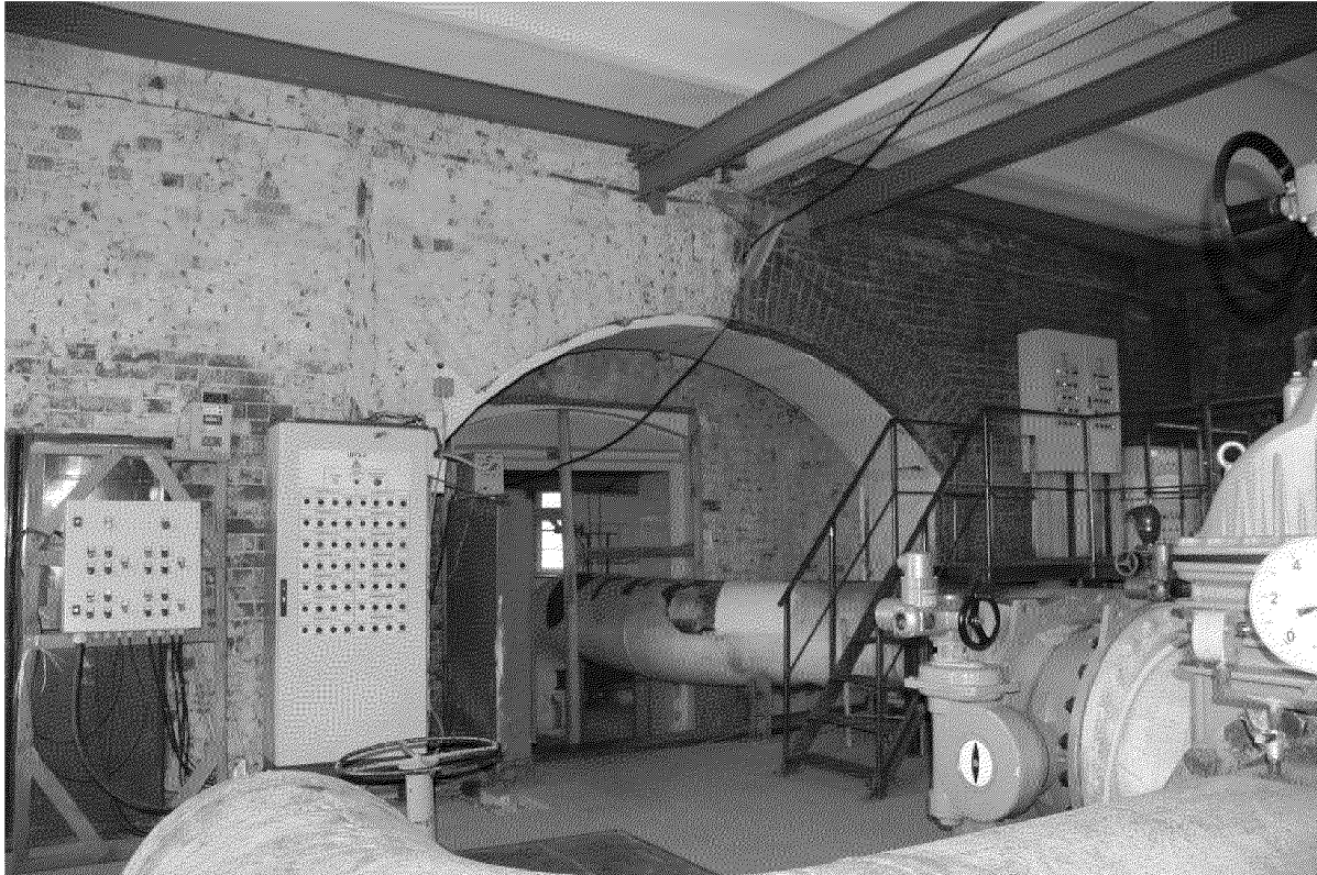
Видовая точка № 13. Помещение 1-го этажа центрального объема. Крупные лучковые проемы перехода в корпус «резервуара»
