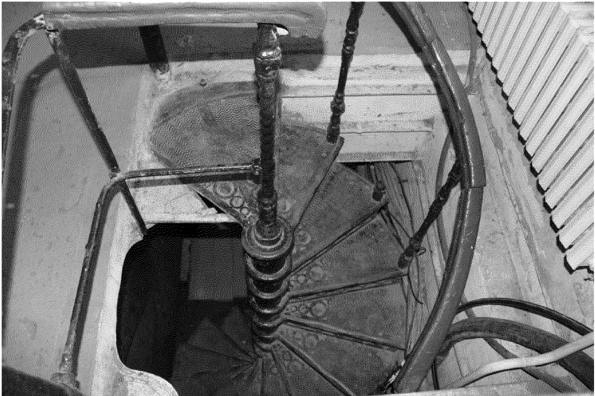
Видовая точка № 20. Винтовая лестница спуска в подвал (помещение 1-го этажа центрального объема здания)
