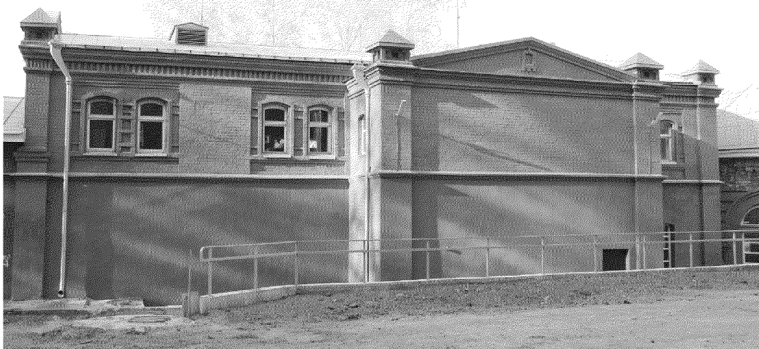
Видовая точка № 4. Дворовый (восточный) фасад здания
