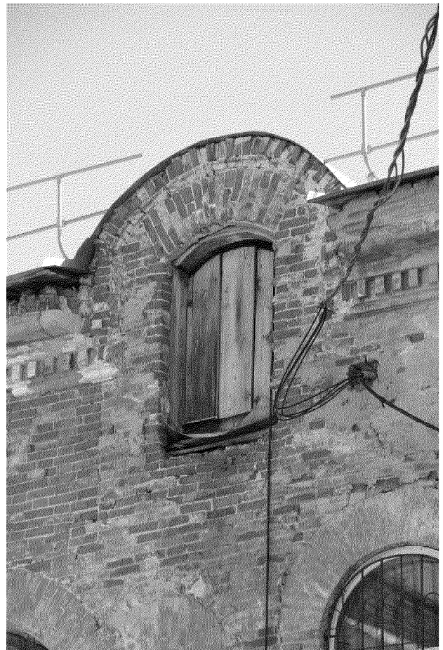
Видовая точка № 16 Слуховое окно дворового западного фасада (Яблонская М.А., 17.07.2020 г.)
