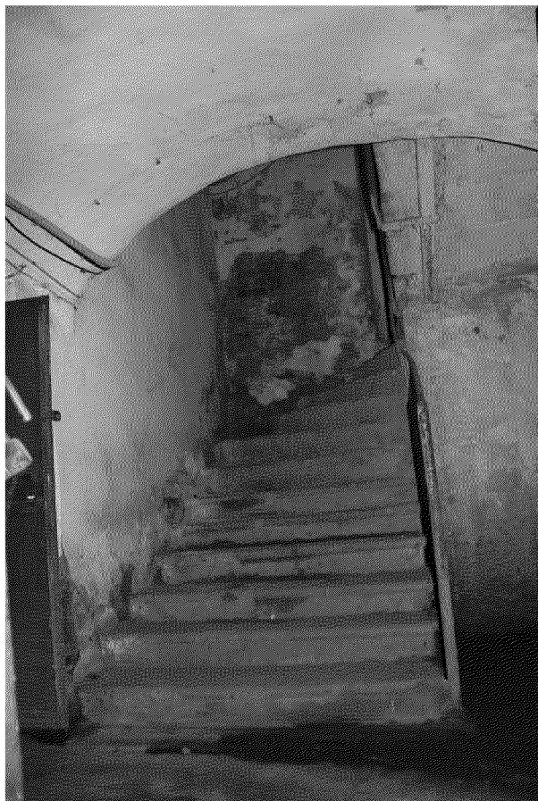
Видовая точка № 26 Железобетонная лестница с забежными ступенями спуска в подвал (Яблонская М.А., 17.07.2020 )
