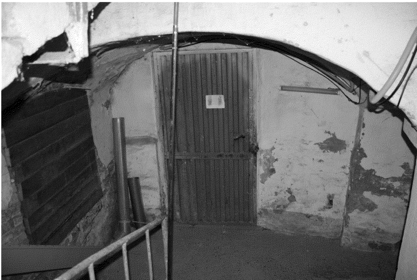
Видовая точка № 25. Кирпичный свод в помещении спуска в подвал. (автор снимка: Рыжикова А.Ю., дата съемки: 2016 г.)
