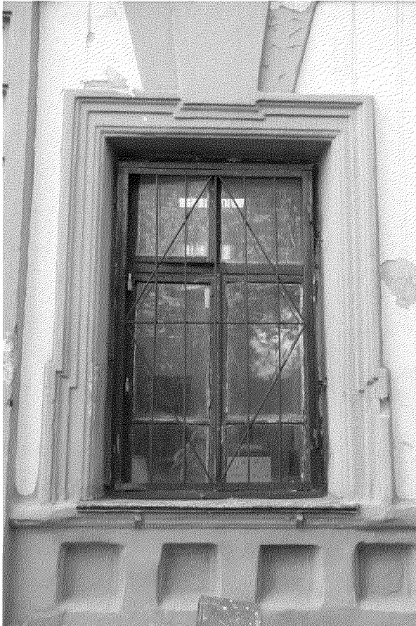
Видовая точка № 13 Окно 1-этажа северного фасада
