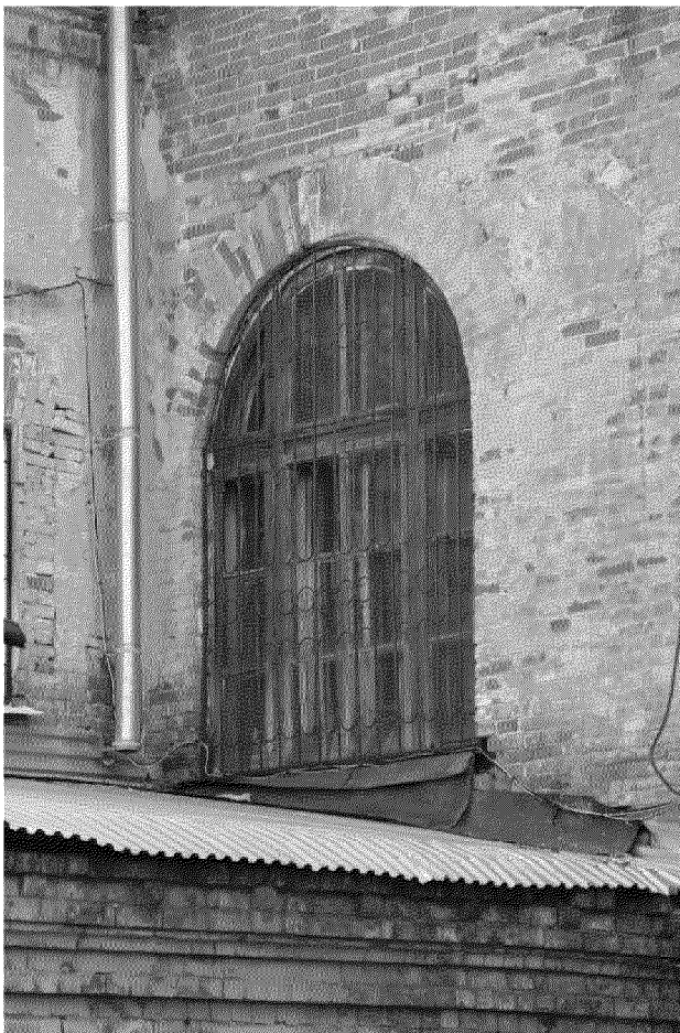
Видовая точка № 15 Окно 2-этажа дворового западного фасада (Рыжикова А.Ю., 24.08.2016 г.)
