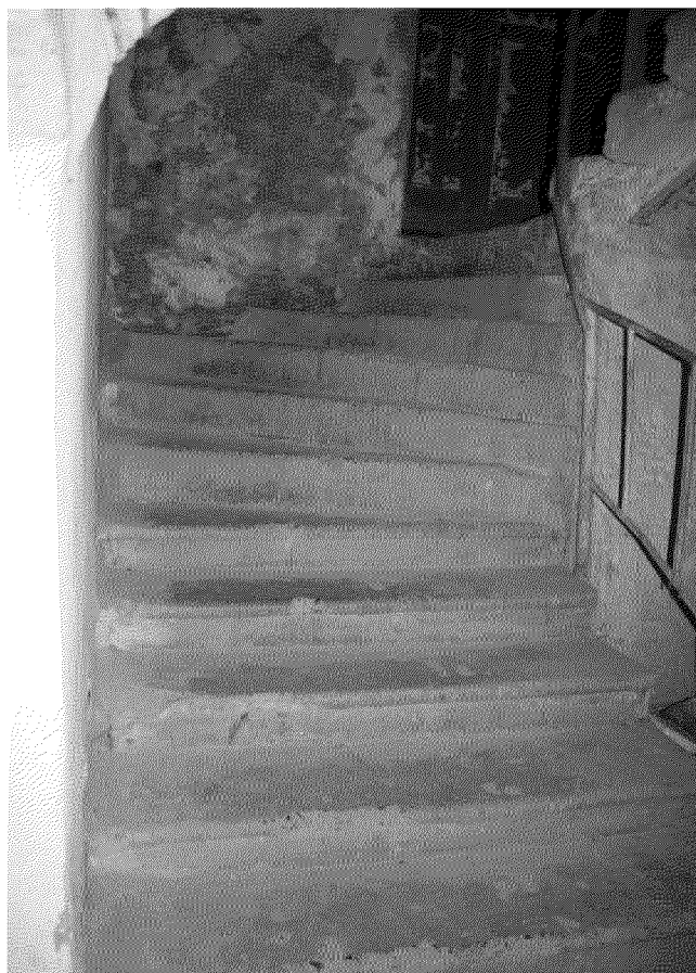
Видовая точка № 27 Железобетонная лестница с забежными ступенями спуска в подвал (Рыжикова А.Ю., дата съемки: 2016 г.)
