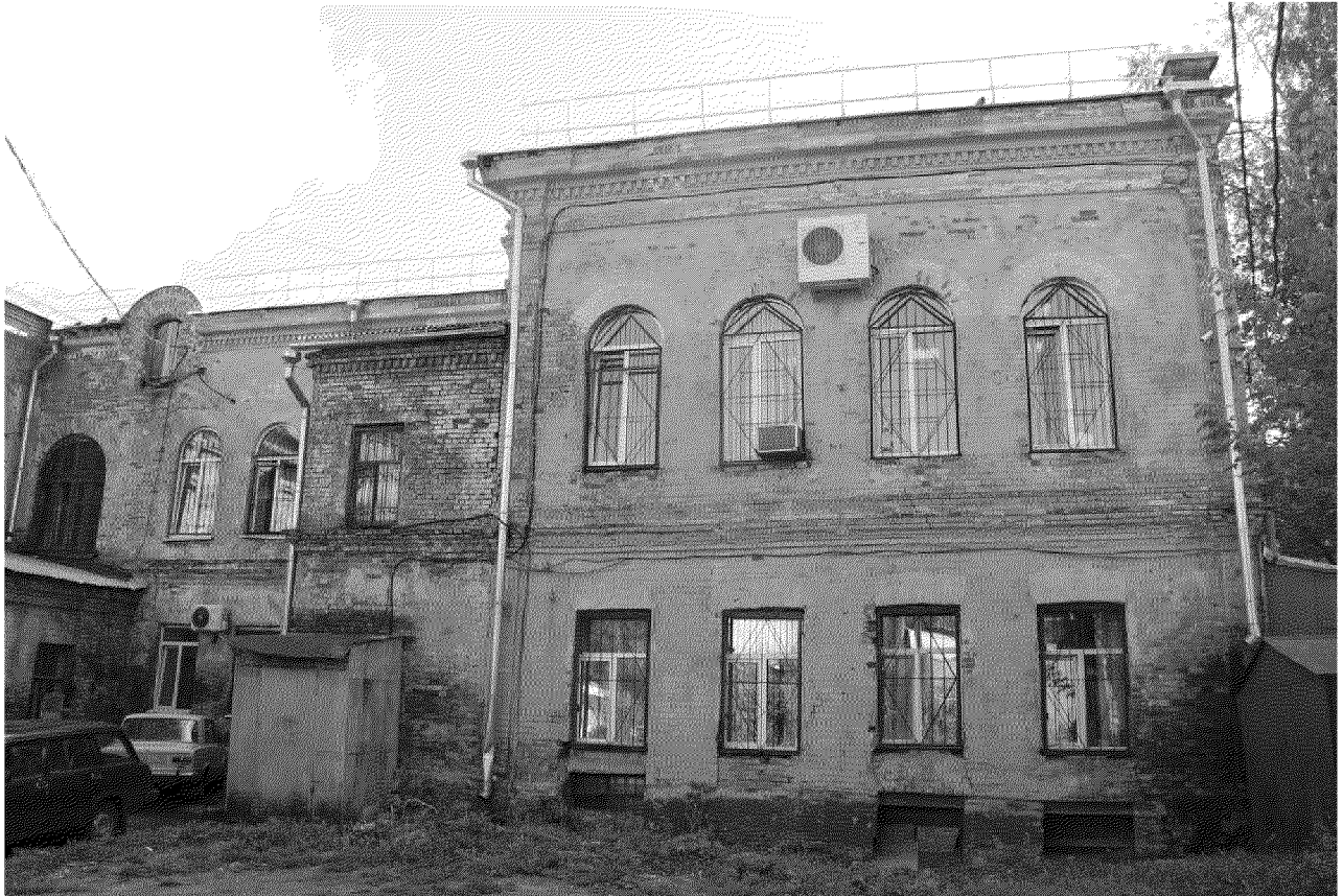
Видовая точка № 5. Западный (дворовой) фасад здания (автор снимка: Рыжикова А.Ю., 24.08.2016)
