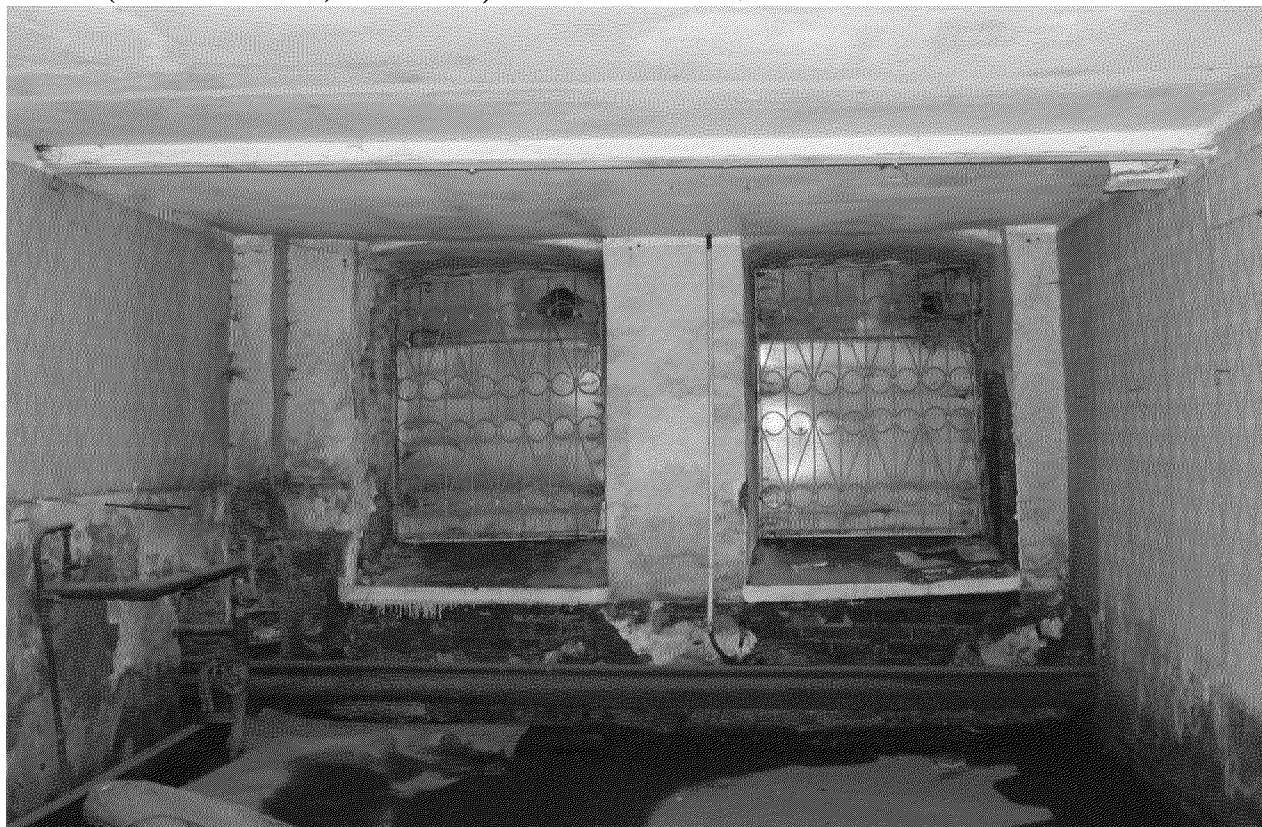
Видовая точка № 28. Оконные проемы помещения подвала с лучковыми кирпичными перемычками (Яблонская М.А., 17.07.2020 г.)
