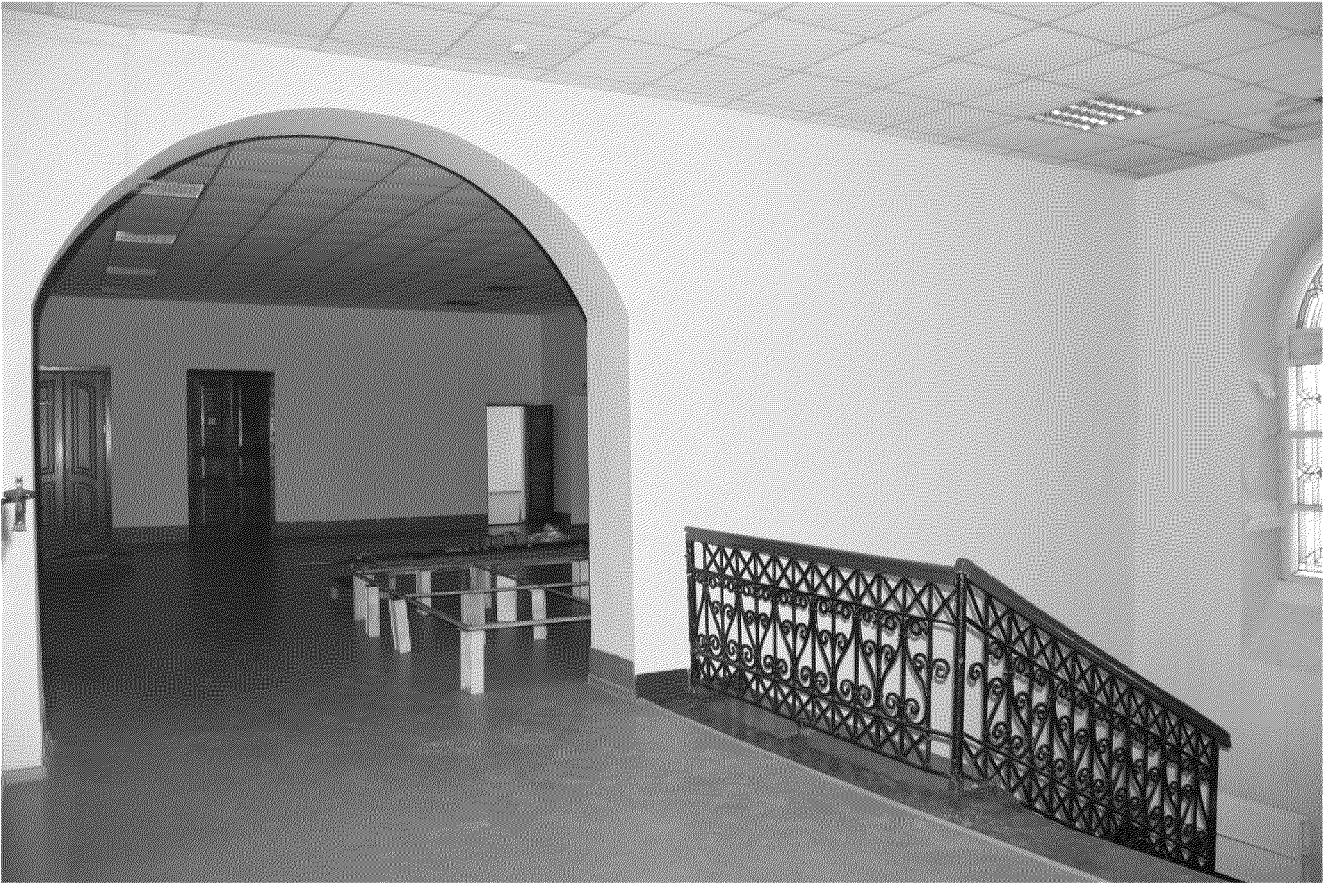
Видовая точка № 20. Общий вид помещения парадной лестницы (автор снимка: Яблонская М.А., дата съемки: 17.07.2020 г.)
