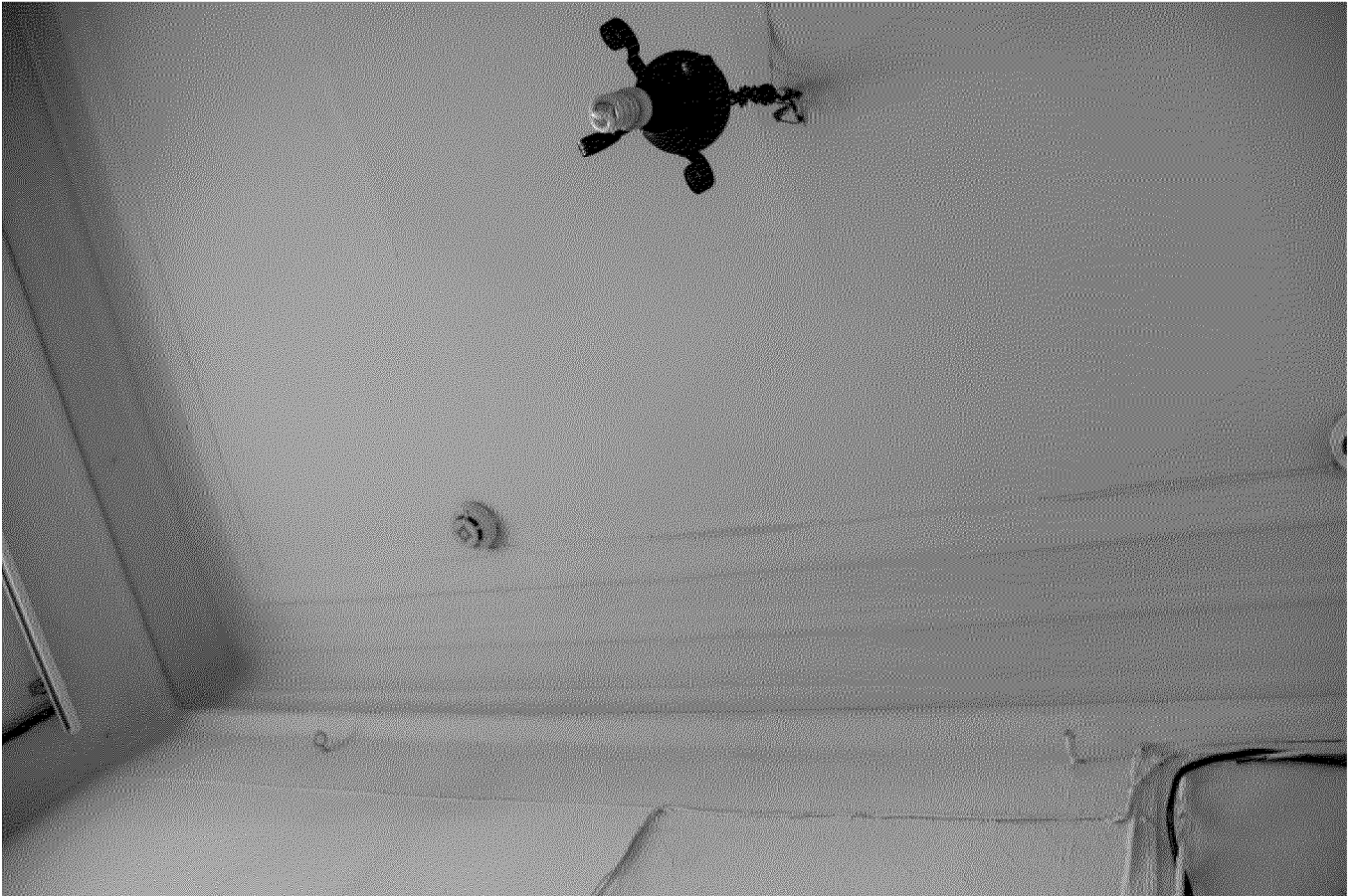
Видовая точка № 22 Профильные штукатурные тяги в оформлении потолка помещения 1-го этажа (Рачковская О.Н., 17.07.2020 г.)
