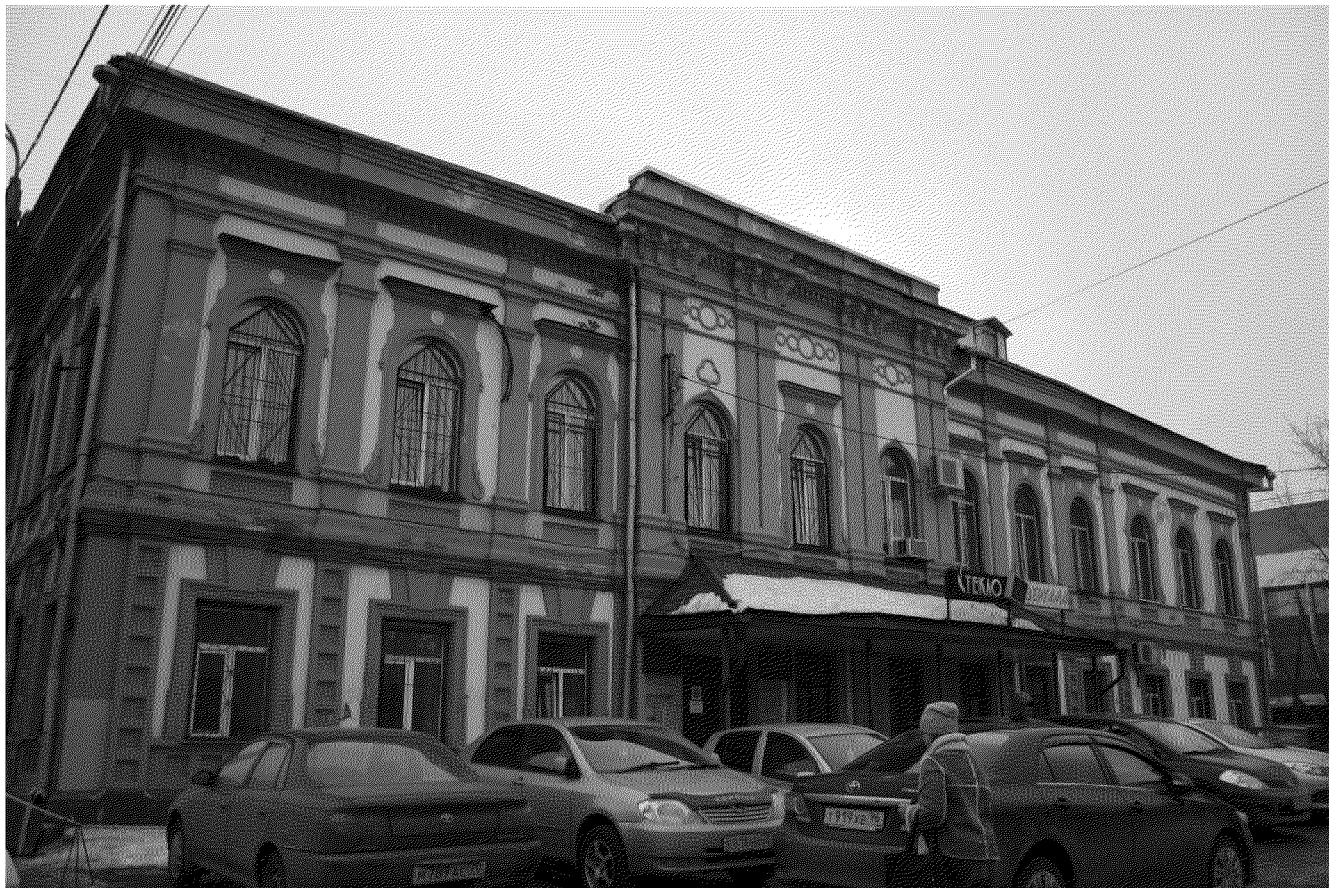
Видовая точка № 3. Северный фасад здания (фото 24.03.2015 – Рыжикова А.Ю.)
