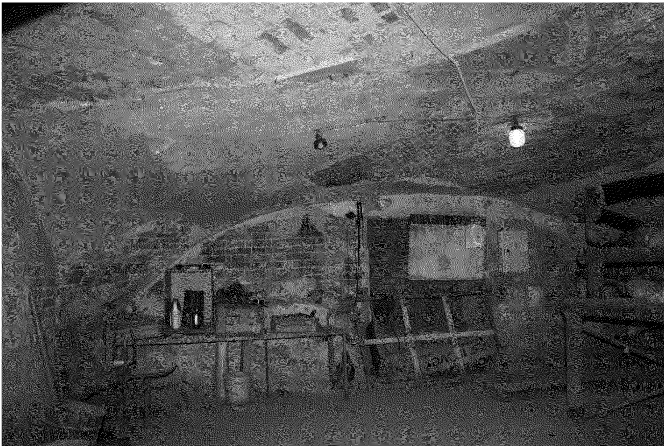
Видовая точка № 24. Кирпичные парусные своды в помещении подвала (автор снимка: Рыжикова А.Ю., дата съемки: 2016 г.)
