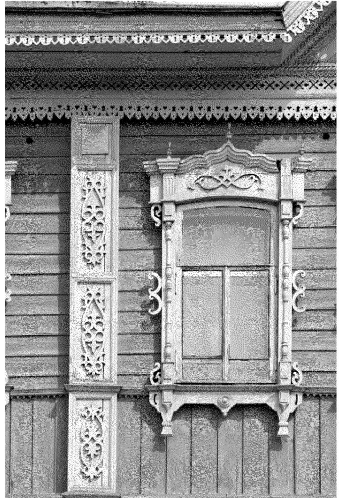
Видовая точка № 7 Окно 2-го этажа, наличник, обшивка фасада, фрагмент пилястры
