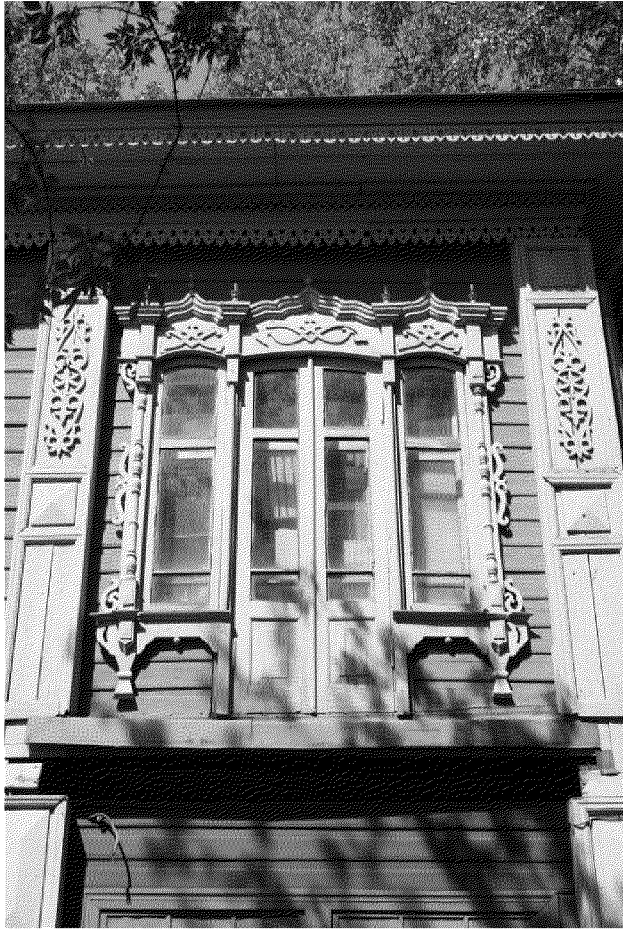
Видовая точка № 9 Балконная дверь южного фасада
