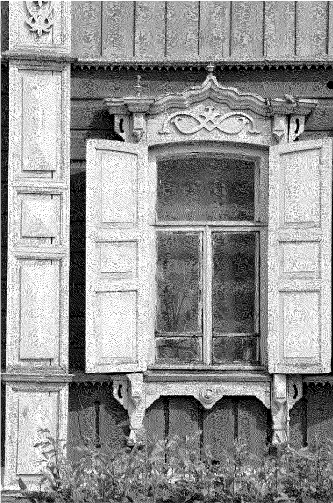
Видовая точка № 6 Окно 1-го этажа, наличник, ставни, фрагмент пилястры
