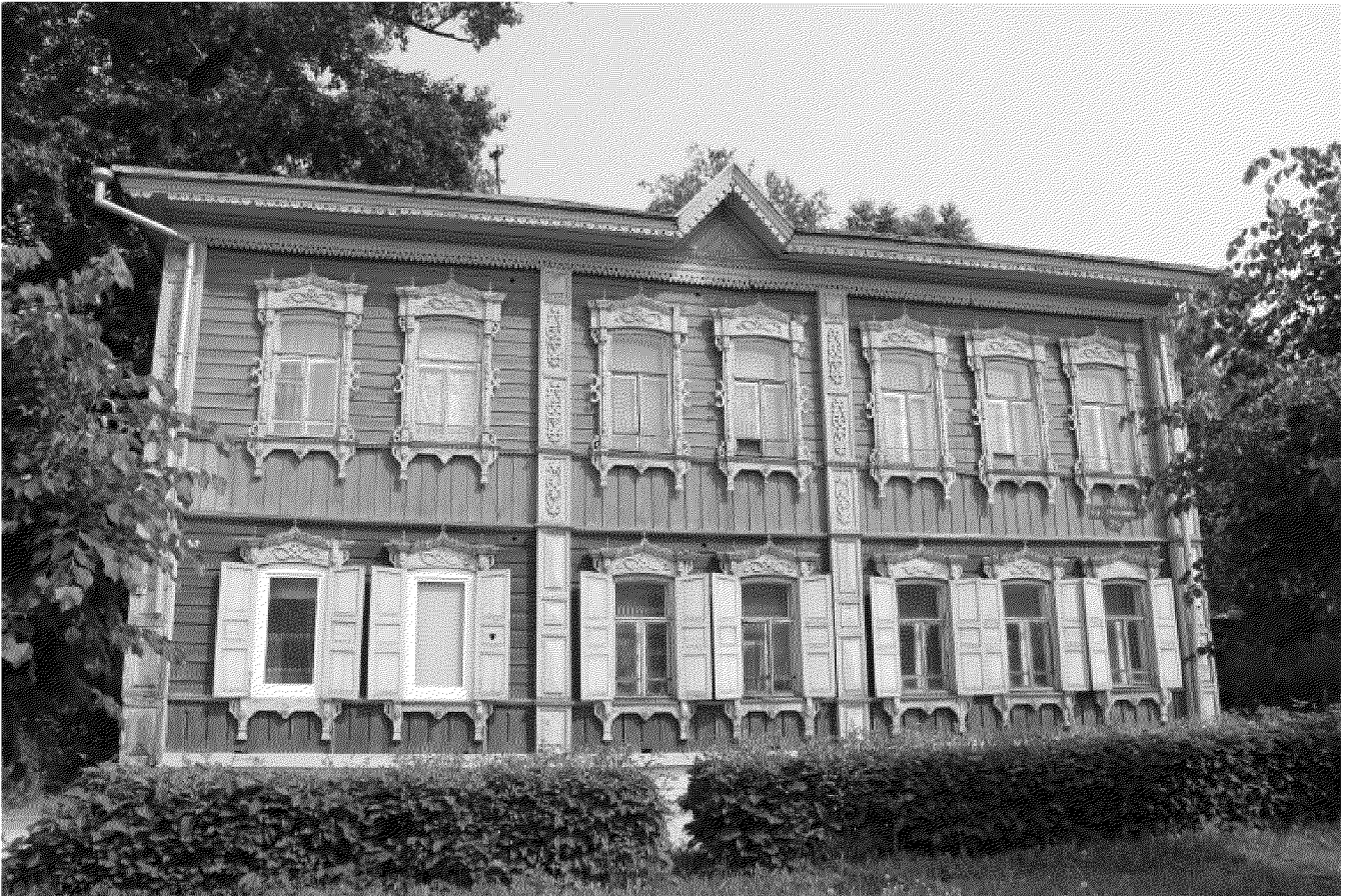
Видовая точка № 4 Главный (западный) фасад
