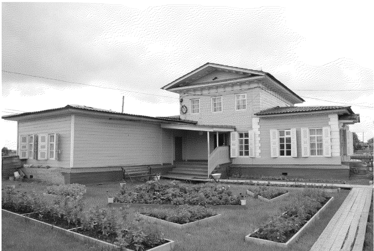
Видовая точка № 4. Общий вид здания с территории двора (ТГАСУ, 2017 г.)
