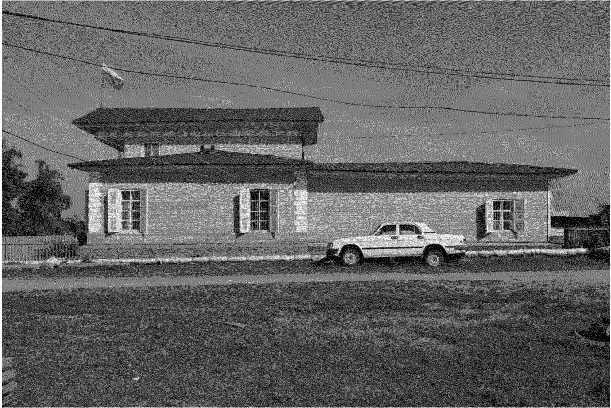
Видовая точка № 3. Фрагмент бокового фасада (ТГАСУ, 2017 г.)
