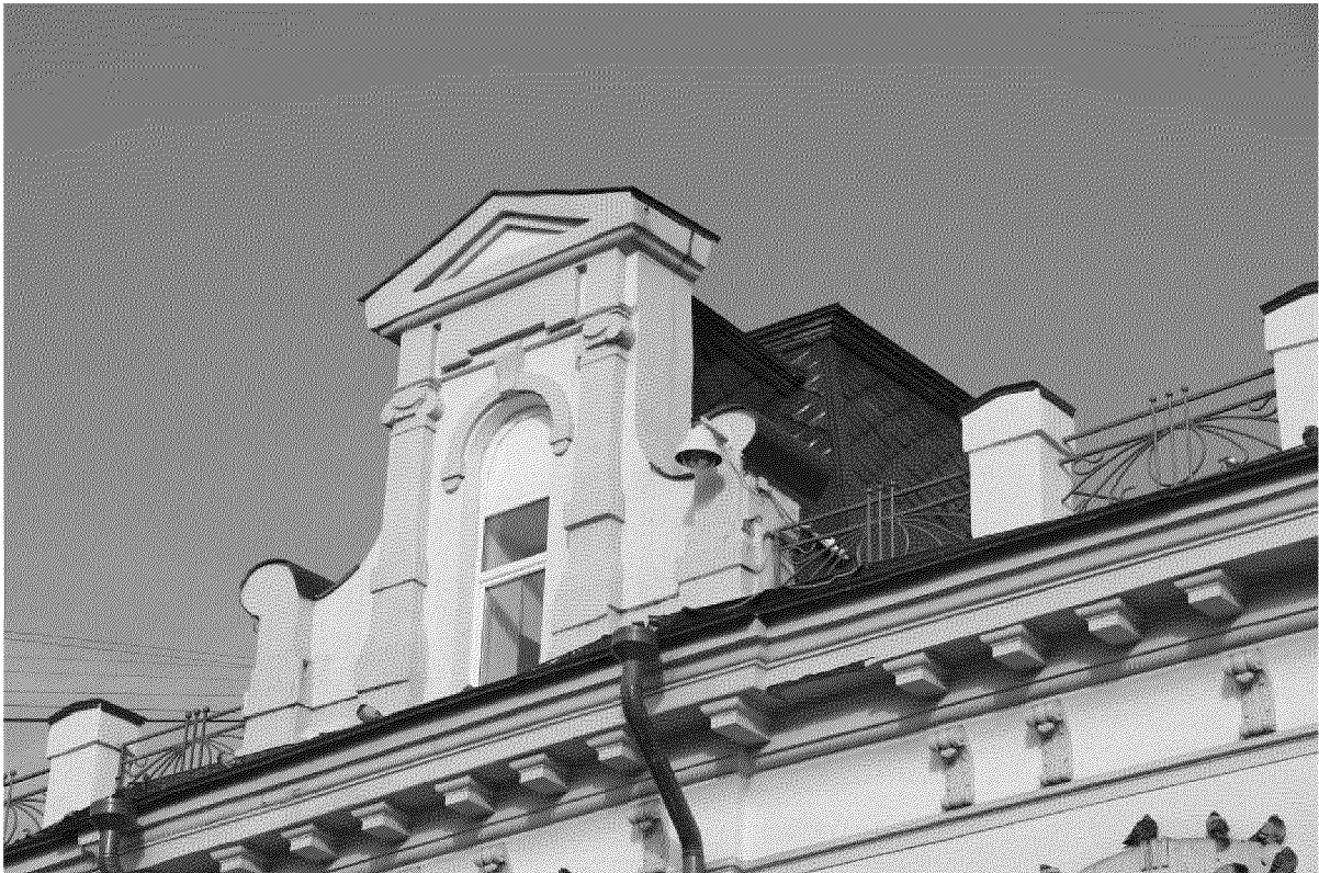
Видовая точка № 6 Фрагмент главного фасада. Центральный аттик.
