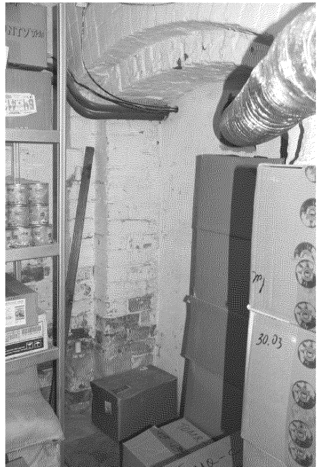
Видовая точка № 27 Дверной проем помещения подвала
