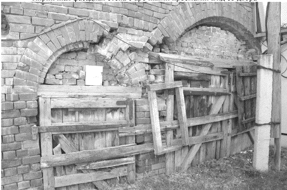
Видовая точка № 14 Арочные проемы с деревянными воротами на кованых навесах.
