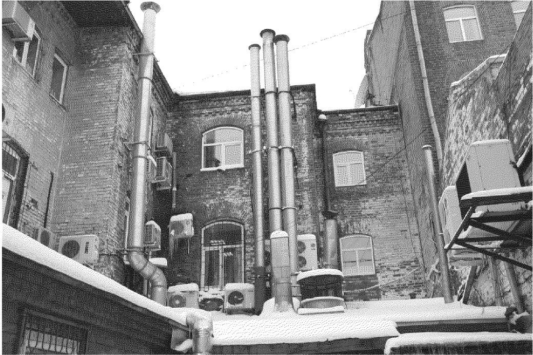
Видовая точка № 14 Восточный (дворовый) фасад здания
