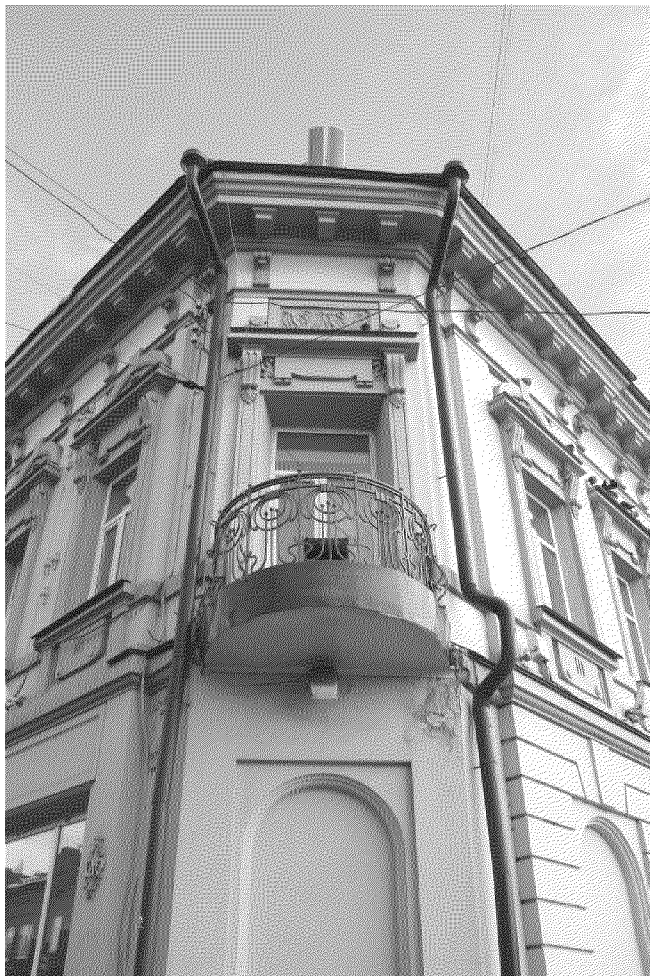
Видовая точка № 4 Фрагмент угловой части здания. Балкон 2-го этажа.
