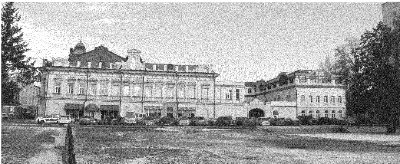
Видовая точка № 2. Общий вид усадьбы с пл. Ново-Соборной
