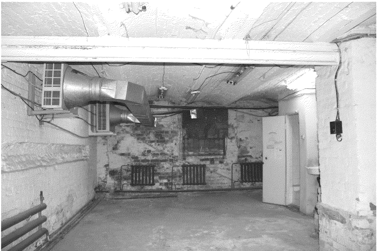
Видовая точка № 9. Фрагмент интерьера подвала. Кирпичные своды по металлическим балкам (17.01.2017)
