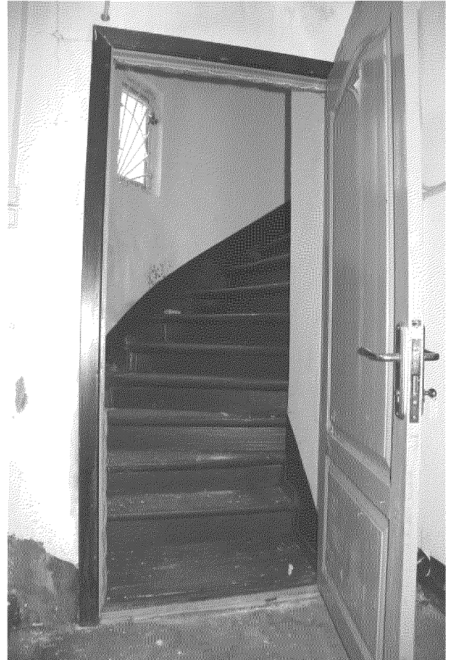
Видовая точка № 25 Деревянная лестница с забежными ступенями
