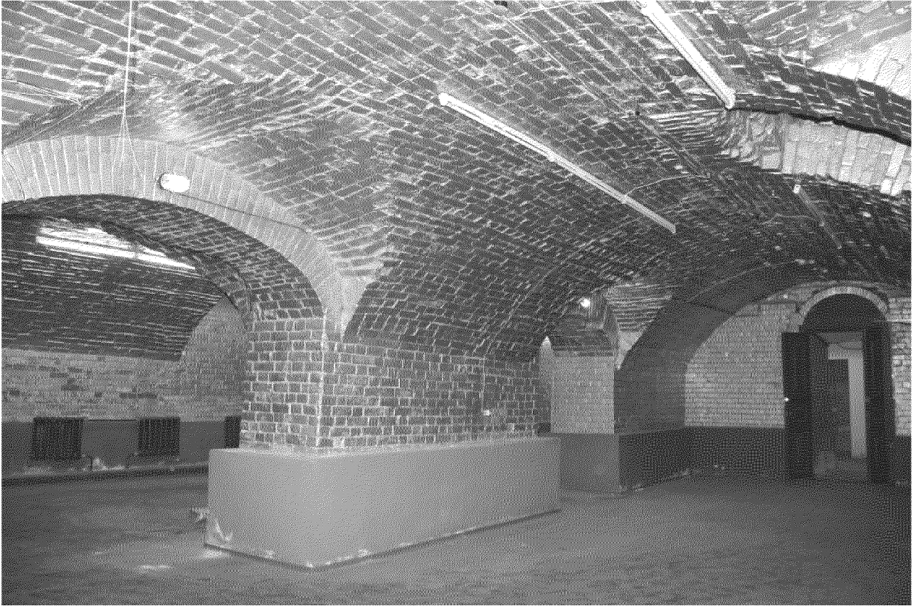
Видовая точка № 5. Фрагмент интерьера подвала. Цилиндрические своды с распалубками (17.01.2017)
