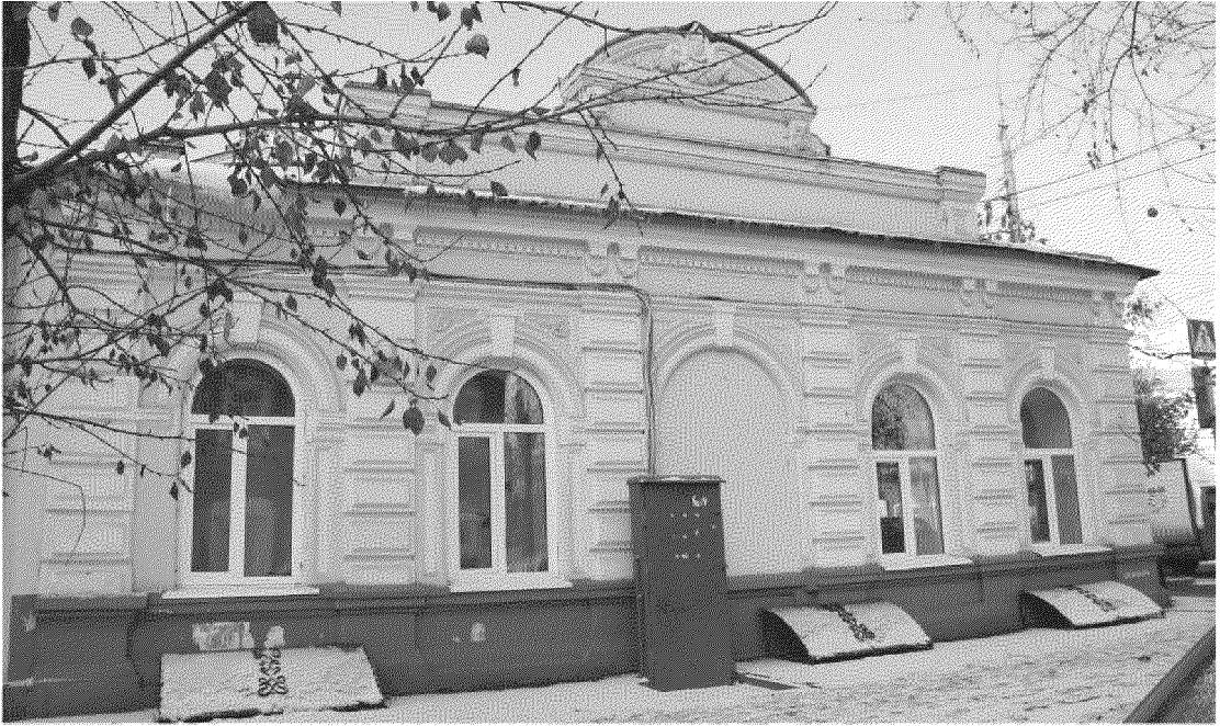
Видовая точка № 3 Восточный фасад здания, вид с ул. Гагарина.
