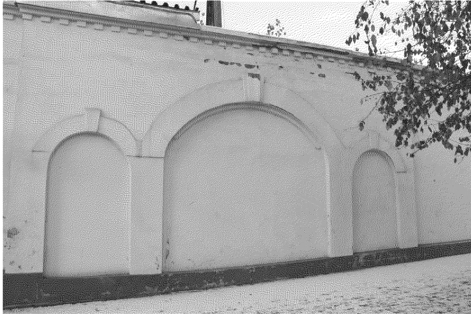
Видовая точка № 12 Кирпичная фасадная стена с арочными проемами, вид с ул. Гагарина
