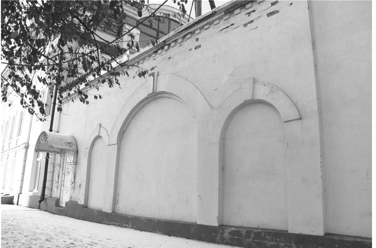
Видовая точка № 10 Кирпичная фасадная стена с арочными проемами, вид с ул. Гагарина
