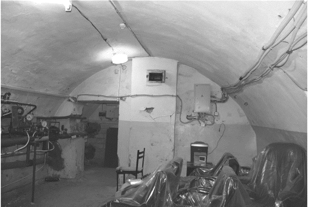
Видовая точка № 10 Помещение подвала с кирпичным сводом.
