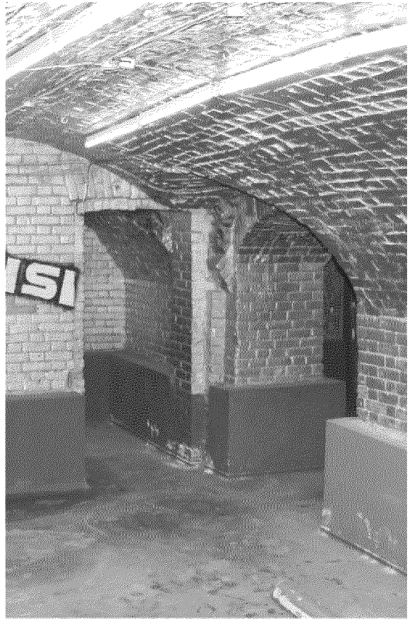
Видовая точка № 8 Проем с лучковой перемычкой (17.01.2017)
