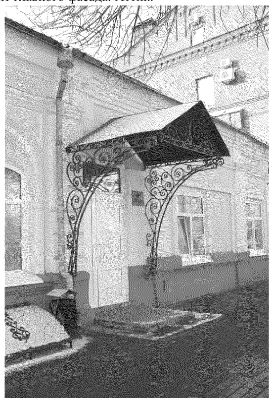
Видовая точка № 6 Кованный металлический козырек
