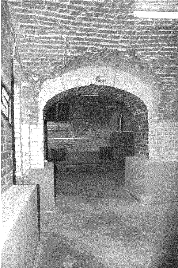
Видовая точка № 7 Проем с трехцентровой арочной перемычкой (17.01.2017)
