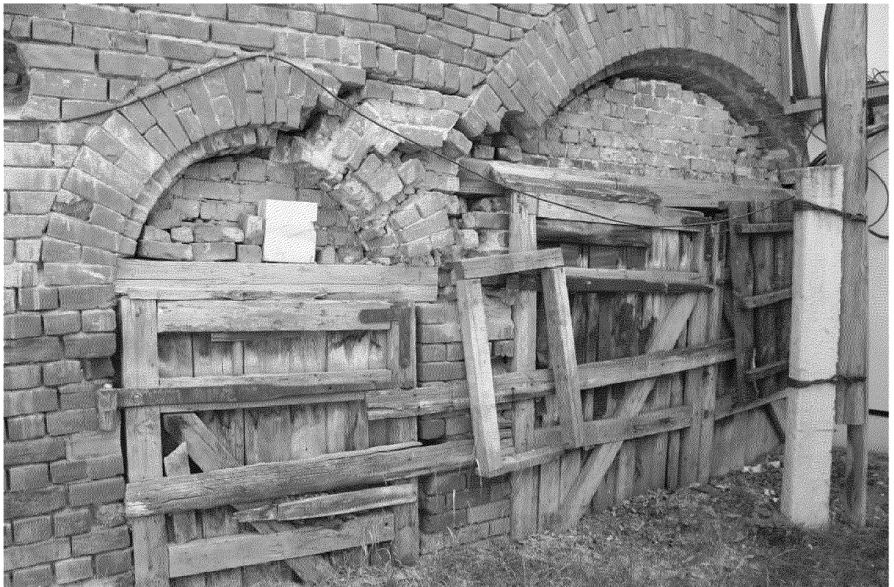
Видовая точка № 10 Кирпичная фасадная стена с арочными проемами. Ворота на кованых навесах.
