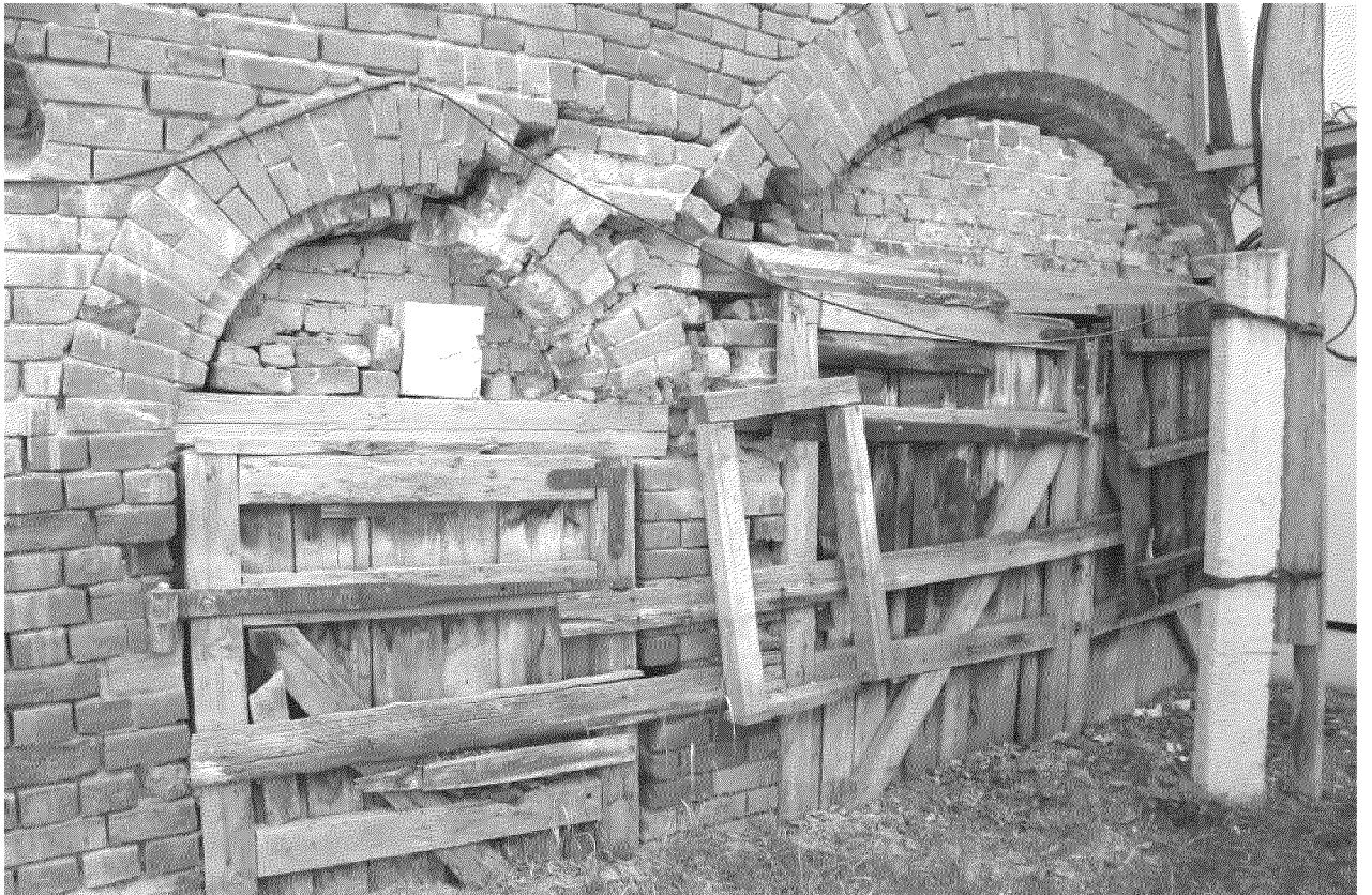
Видовая точка № 11 Арочные проемы с деревянными воротами на кованых навесах.
