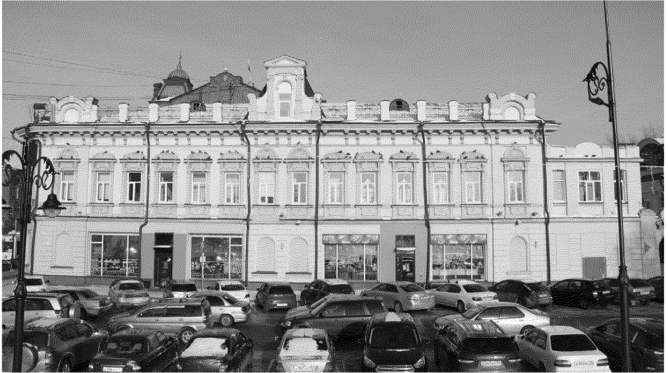
Видовая точка № 3 Южный фасад здания, вид с пл. Ново-Соборной.
