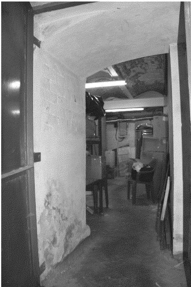
Видовая точка № 26 Фрагмент помещения подвала
