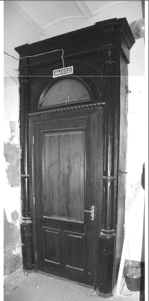
Видовая точка № 20 Входная дверь с тамбуром (вход восточного фасада).
