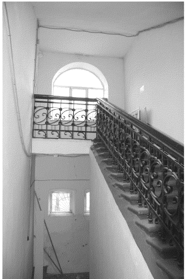
Видовая точка № 23 Фрагмент лестницы из песчаника с кованым ограждением
