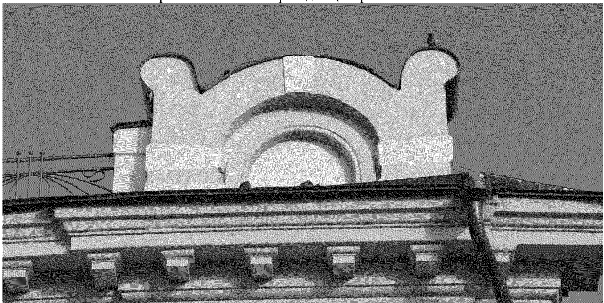
Видовая точка № 7 Аттик бокового ризалита южного фасада.
