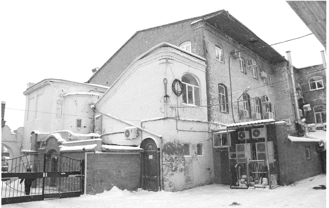
Видовая точка № 11 Общий вид дворового фасада с северо-восточной стороны
