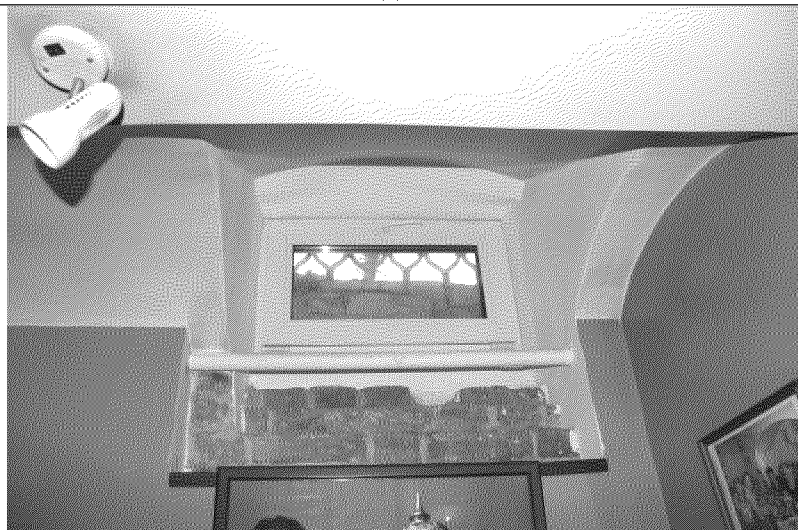
Видовая точка № 19 Оконный проем подвала с кованой решеткой
