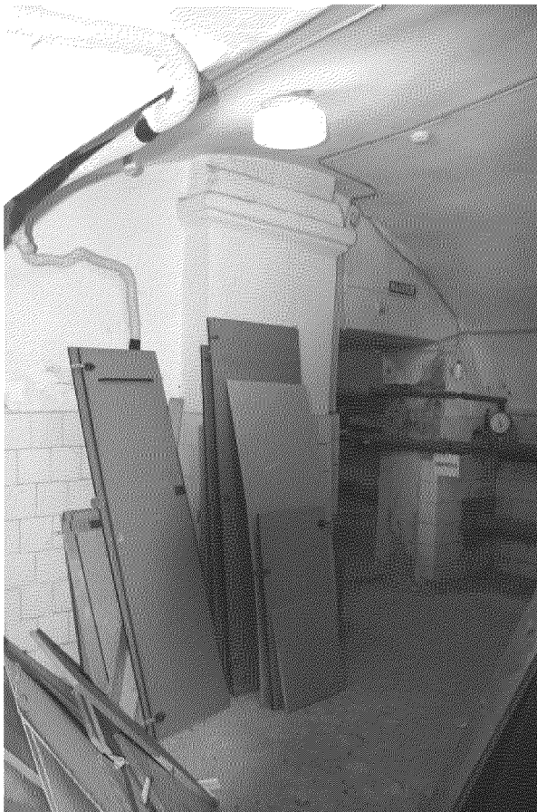
Видовая точка № 8 Помещение подвала с кирпичным сводом. Печь.
