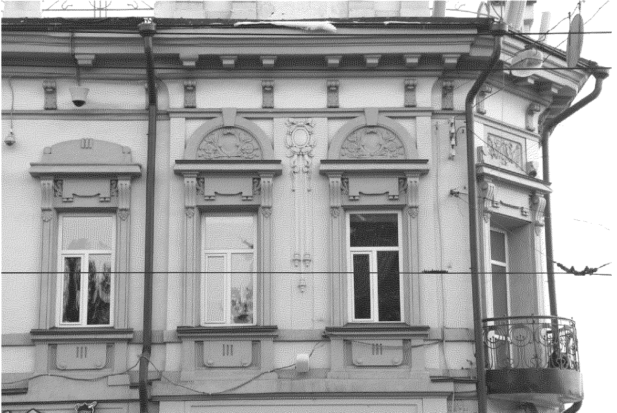
Видовая точка № 9 Элементы фасадного декора 2-го этажа западного фасада. Балкон.
