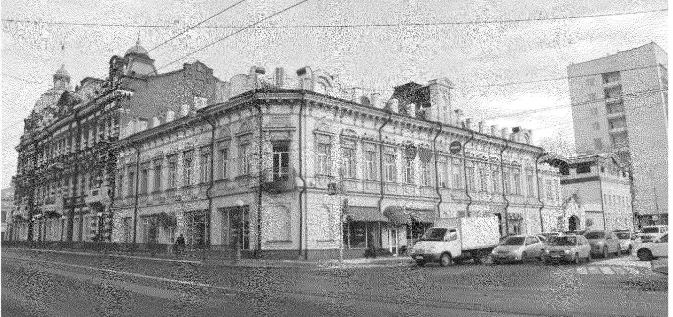
Видовая точка № 1 Общий вид здания с юго-западной стороны (с пр. Ленина)
