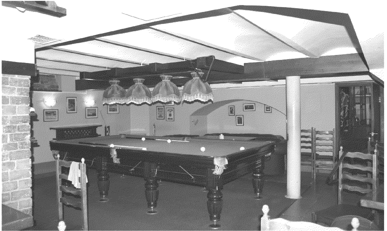
Видовая точка № 17 Общий вид помещения подвала
