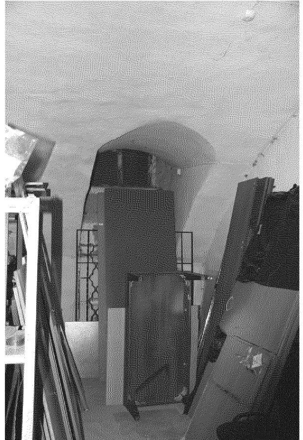
Видовая точка № 9 Кирпичный свод с распалубкой в месте расположения оконного проема.
