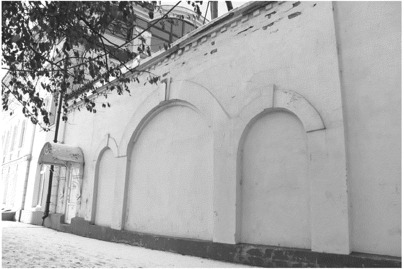
Видовая точка № 9 Кирпичная фасадная стена с арочными проемами, вид с ул. Гагарина
