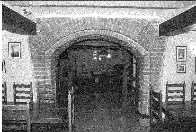
Видовая точка № 18 Лучковый дверной проем в помещении подвала
