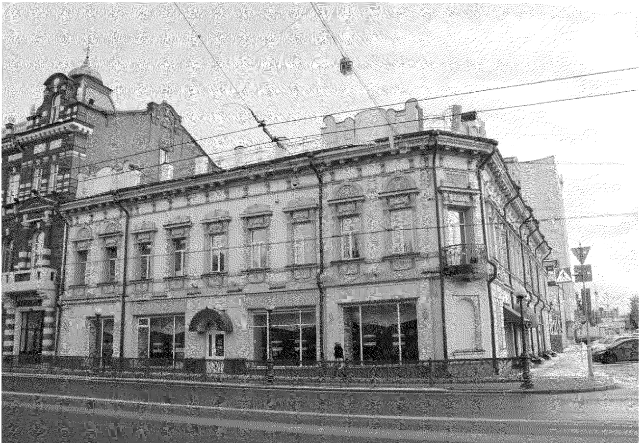
Видовая точка № 2 Западный фасад здания, вид с пр. Ленина.
