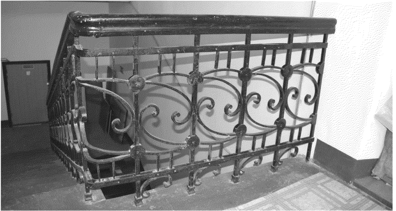
Видовая точка № 21 Фрагмент кованого ограждения лестницы.
