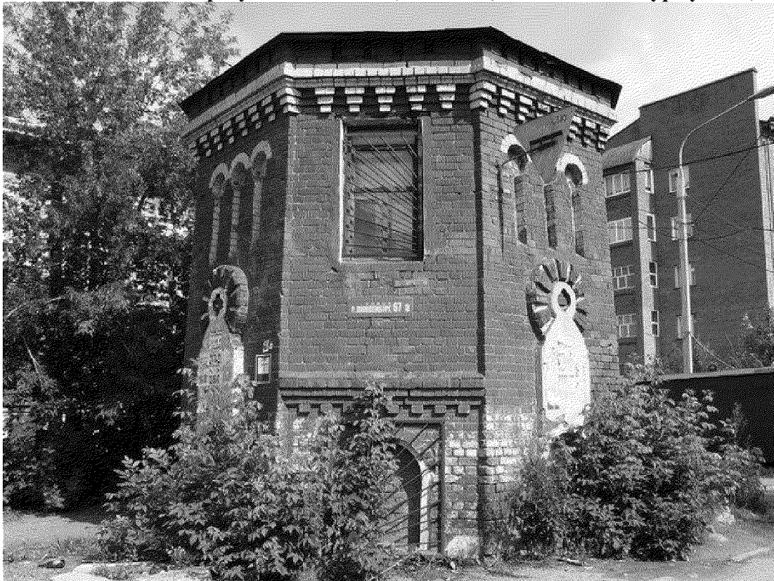
Видовая точка № 1. Общий вид башни с пр. Ленина (2015 г.)
