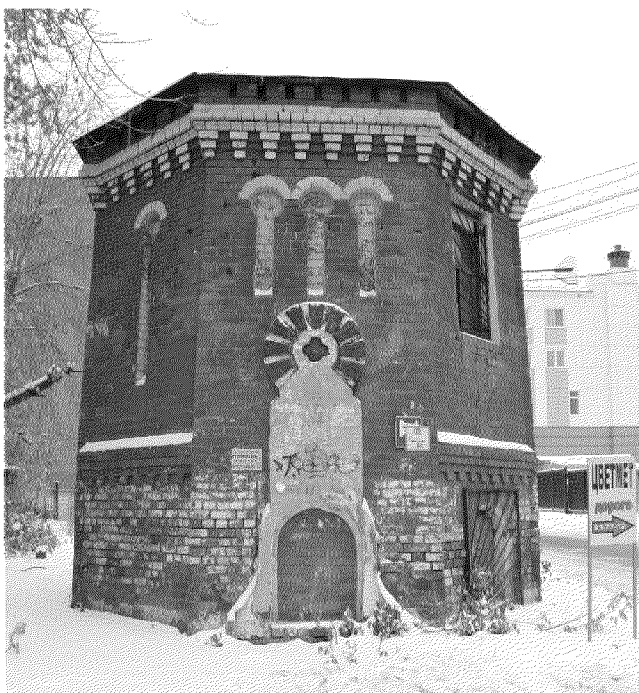
Видовая точка № 2. Западный фасад (Рыжикова А.Ю., 2016 г.)
