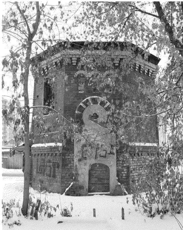
Видовая точка № 5. Северный фасад (Рыжикова А.Ю., 2016 г.)
