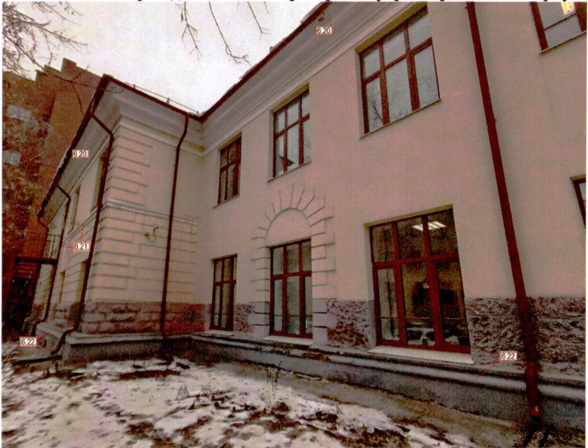
Юго-восточный фасад восточного пристроя внутриквартального корпуса
