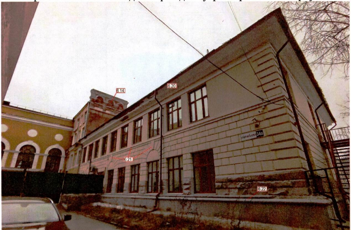
Правая часть юго-западного фасада внутриквартального корпуса
