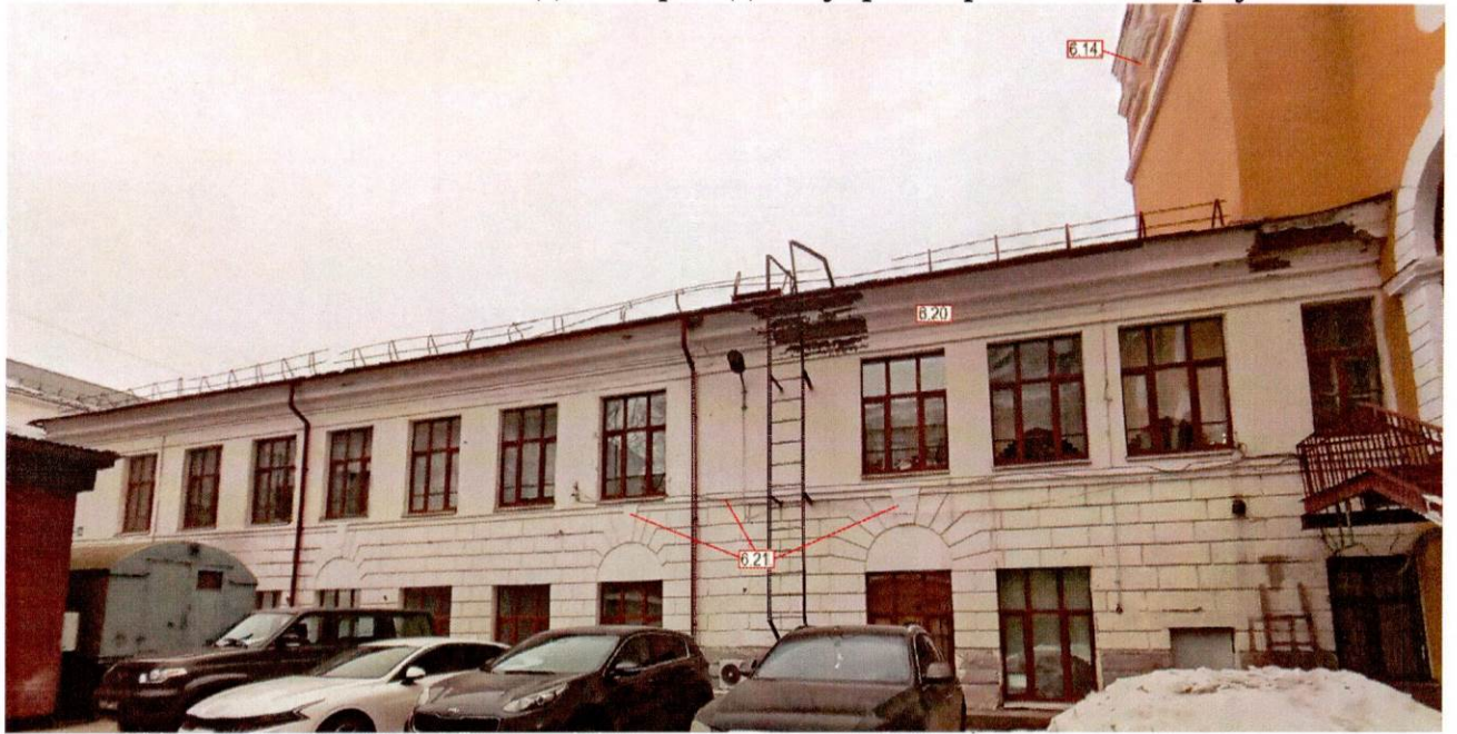
Левая часть юго-западного фасада внутриквартального корпуса
