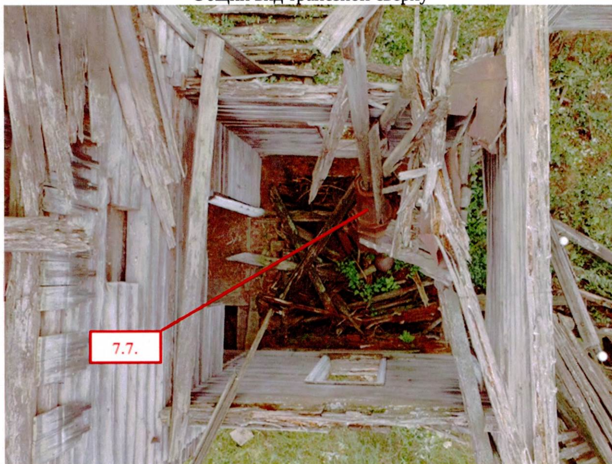
Общий вид трапезной сверху
