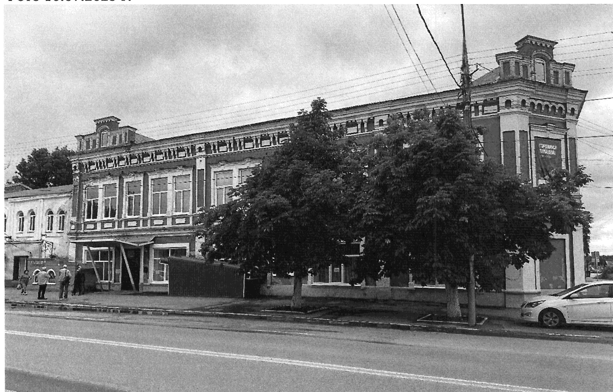
2. Северо-западный фасад по ул. Московской. Фото 10.07.2025 г. Композиционное решение фасада, количество световых осей, световые проемы, лопатки, горизонтальные членения.
