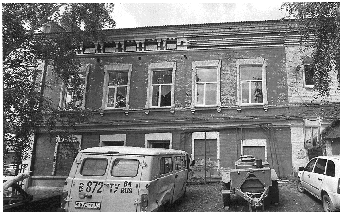
14. Юго-восточный (дворовой) фасад. Фото 10.07.2025 г. Междуэтажный карниз, подоконный пояс, венчающий карниз, боковая лопатка, наличники.
