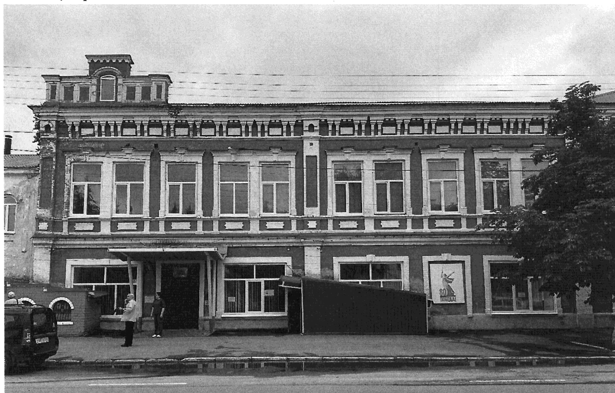
4. Северо-западный фасад по ул. Московской. Фото 10.07.2025 г. Световые проемы, лопатки, горизонтальные членения, аттик.
