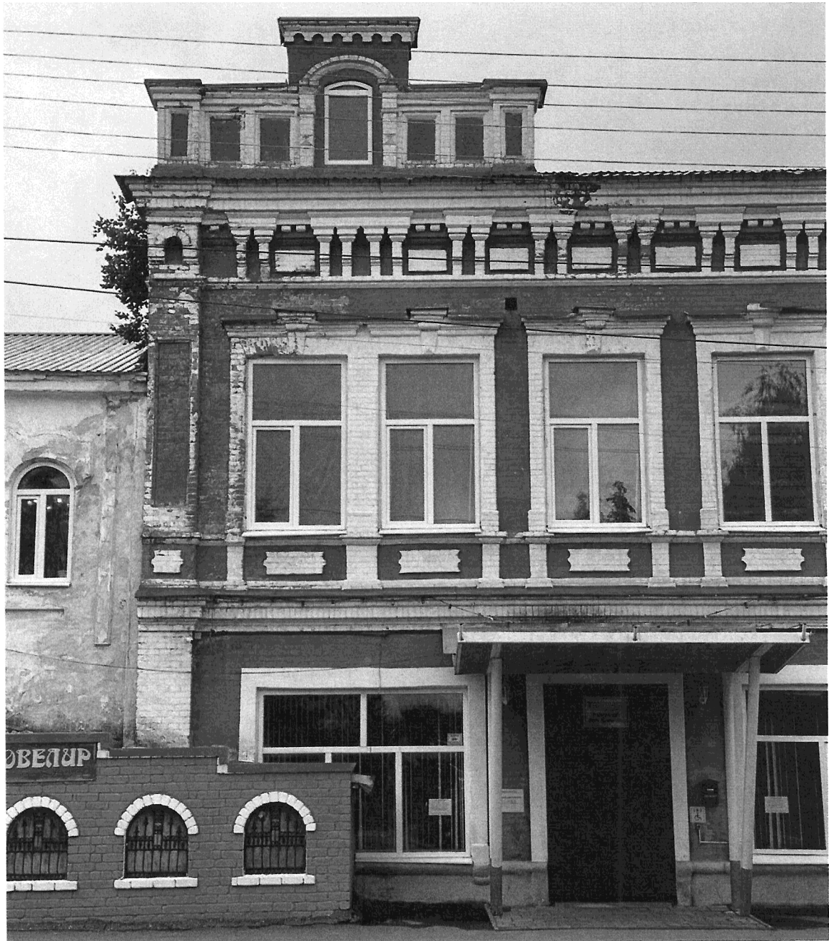
5. Северо-западный фасад по ул. Московской. Фото 10.07.2025 г. Световые проемы, лопатки, горизонтальные членения, аттик.
