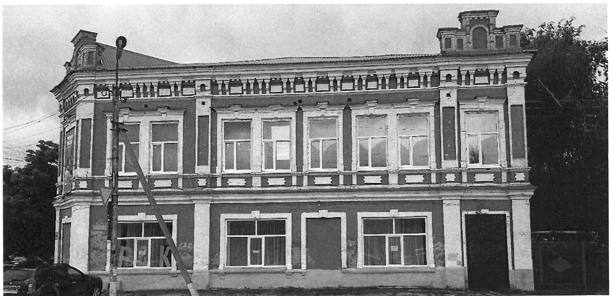
10. Юго-западный фасад по ул. Кольцова. Фото 10.07.2025 г. Композиционное решение фасада, количество световых осей, световые проемы, лопатки, горизонтальные членения.
