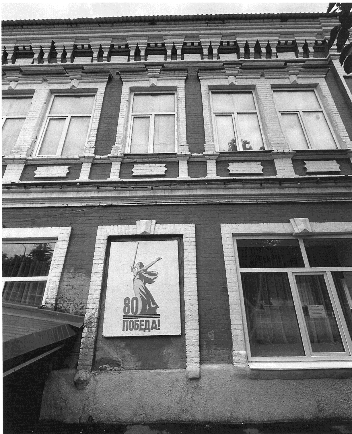
7. Северо-западный фасад по ул. Московской. Фото 10.07.2025 г. Световые проемы, горизонтальные членения.
