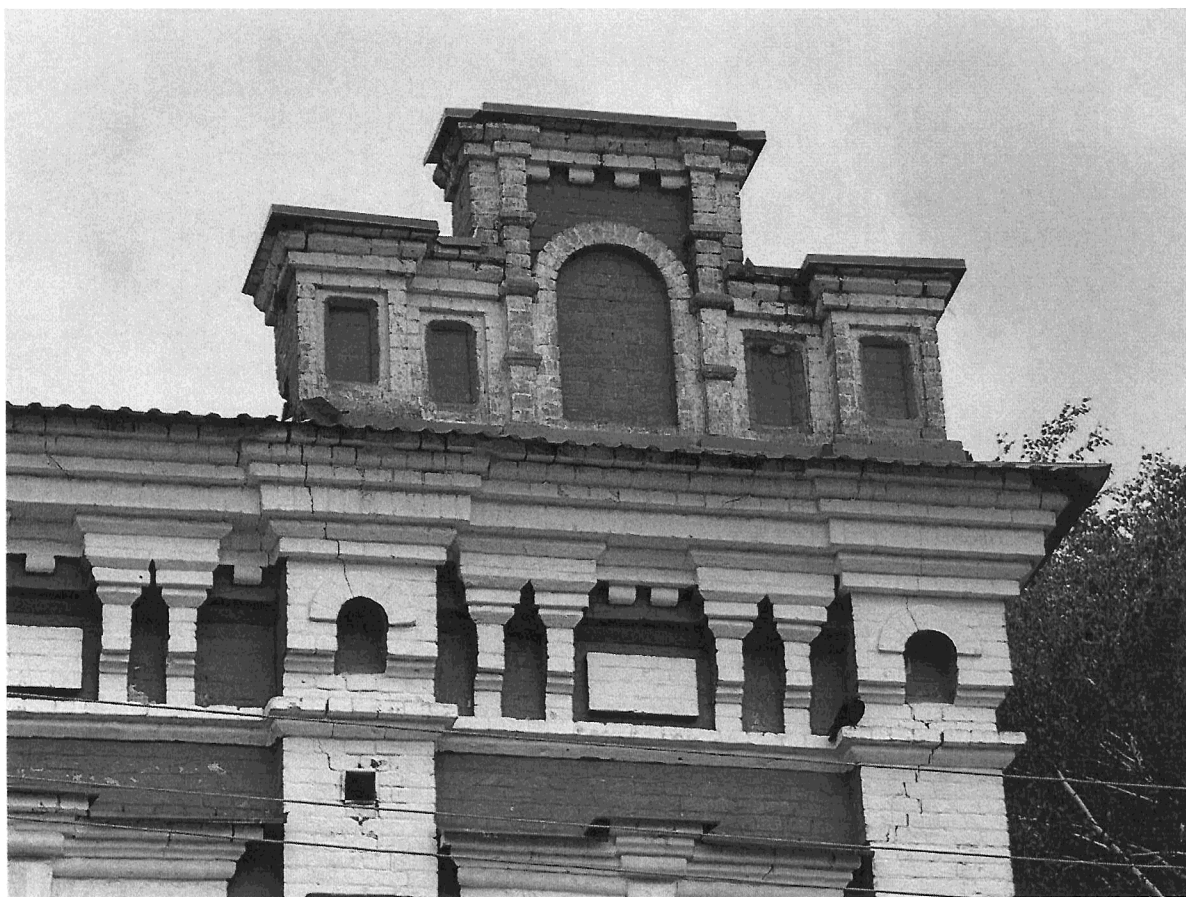
13. Юго-западный фасад по ул. Кольцова. Фото 10.07.2025 г. Венчающий карниз, аттик.
