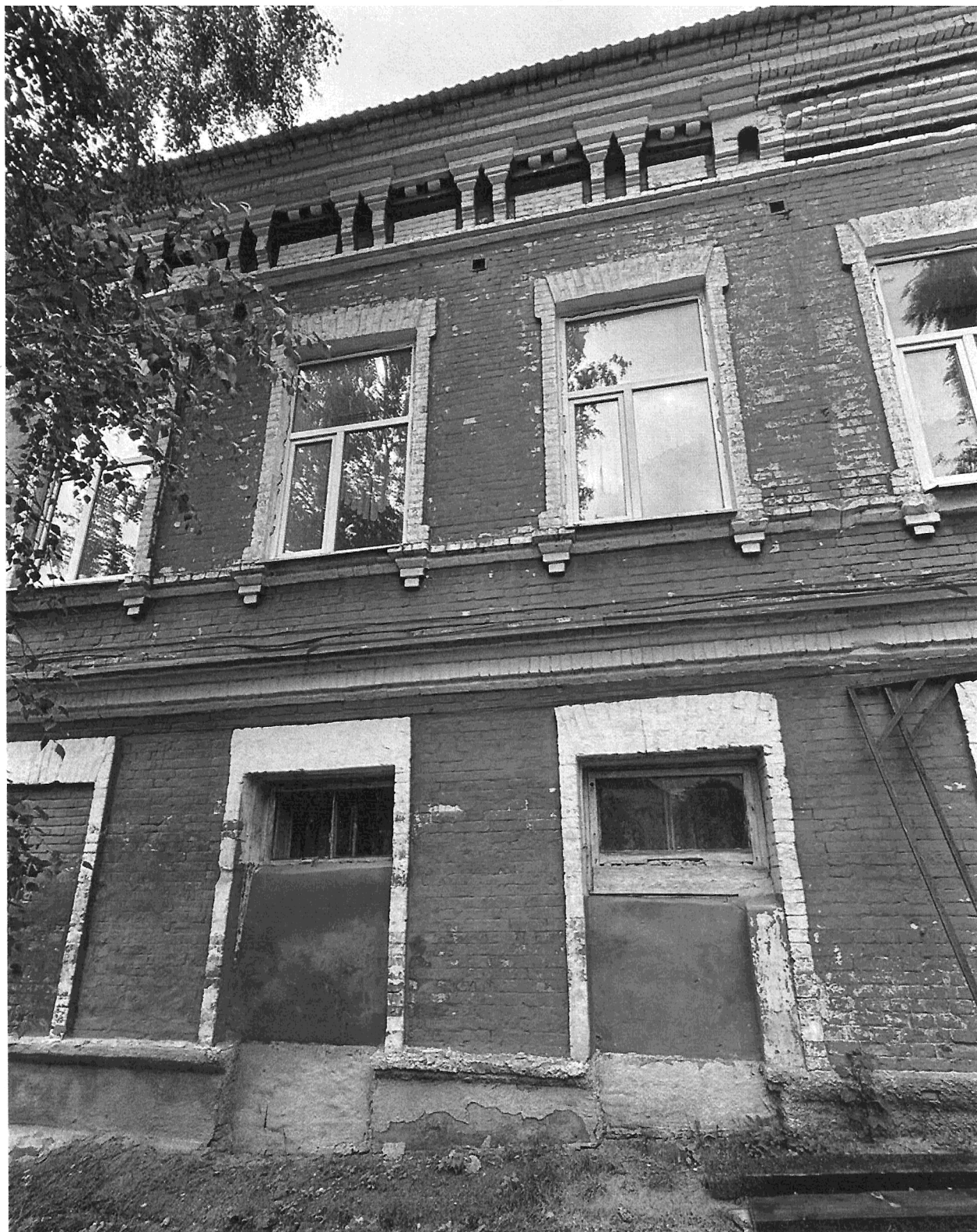
15. Юго-восточный (дворовой) фасад. Фото 10.07.2025 г. Междуэтажный карниз, подоконный пояс, венчающий карниз, наличники.
