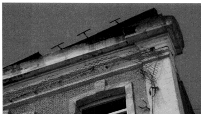
Замковый камень, венчающий оконные проемы 4-го этажа
