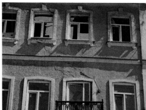
Плоское обрамление оконных проемов 3-го и 4-го этажей
