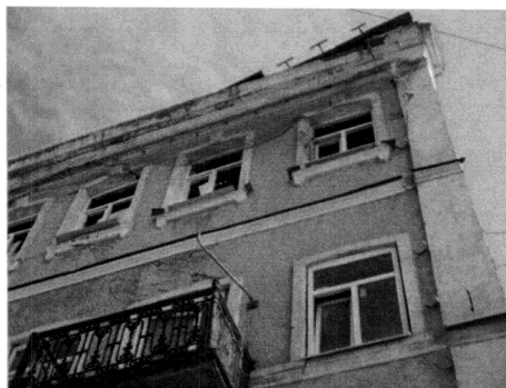
Лучковое завершение и габаритные размеры оконных проемов 3-го и 4-го этажей
