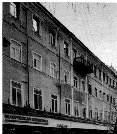
Пилястры в уровне 2-го, 3-го и 4-го этажей, расположенные в простенках оконных проемов
