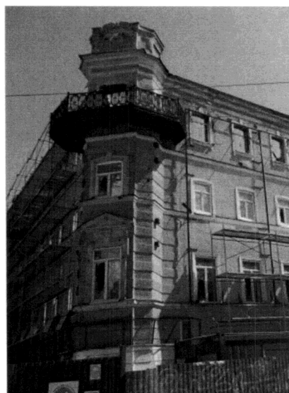
Эркер, расположенный на угловой части фасада
