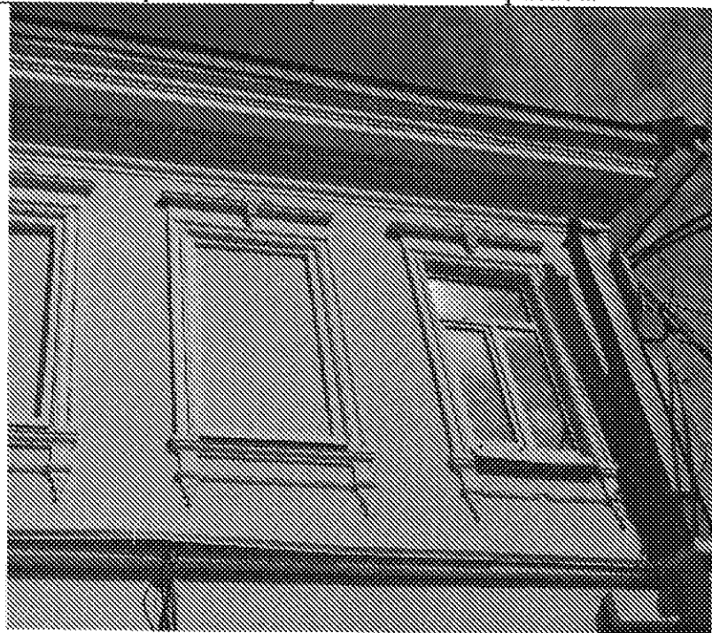
Фрагмент северо-восточного фасада.
