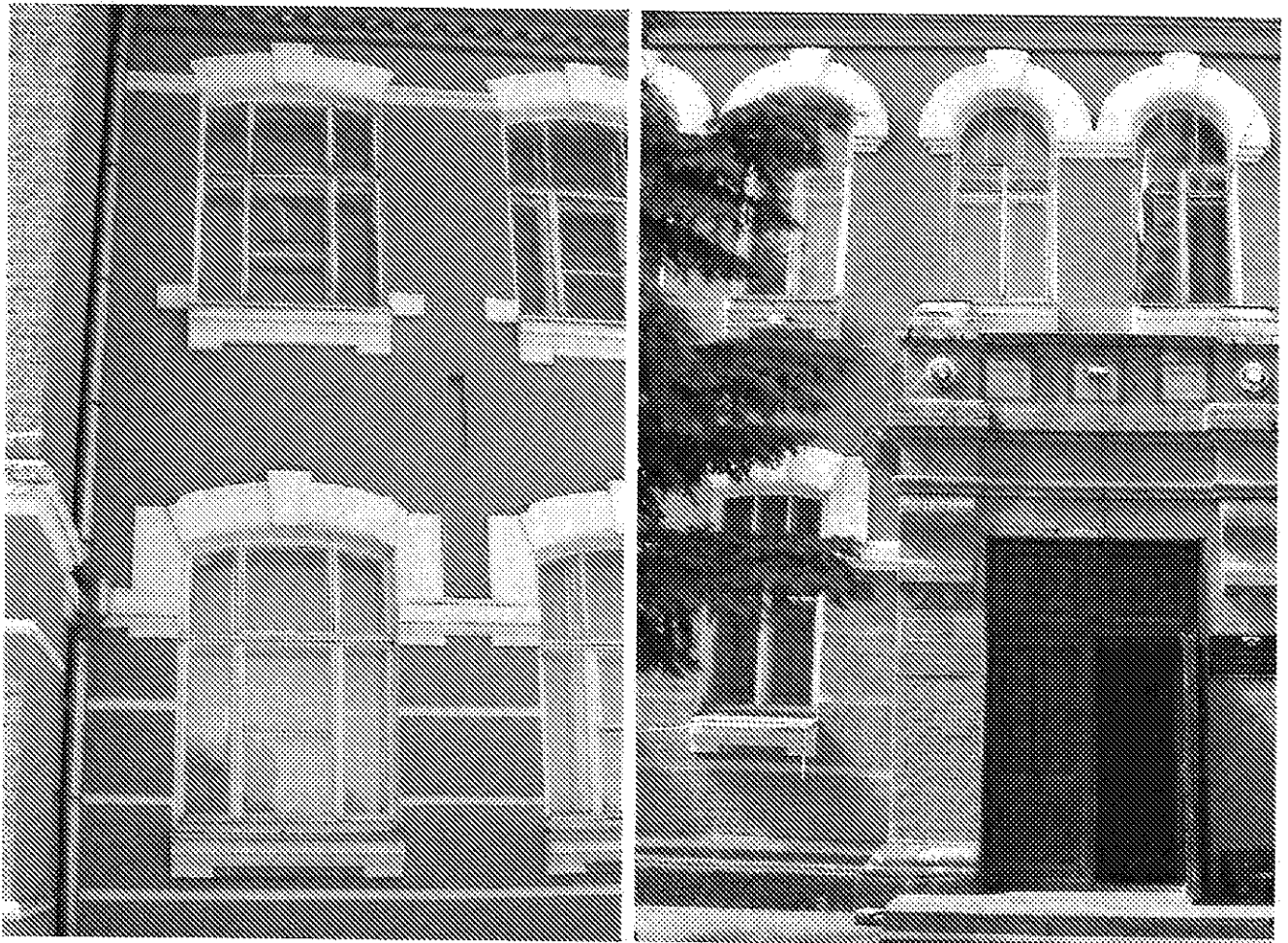
Фото – 13,14. Обрамления оконных проемов с замковыми камнями на оконных перемычках, подоконные карнизы, расстекловка окон.
