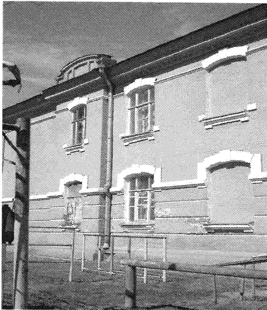
Фото-4. Боковой фасад с ризалитом, аттиком
