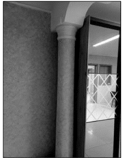
колонна в помещении № 3 подвала литер А
