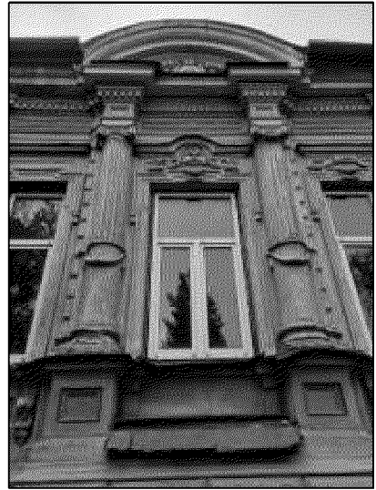
архитектурное оформление прямоугольного оконного проема раскреповки ризалита
