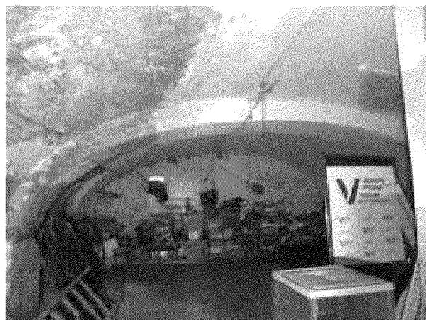
коробовый свод перекрытия 1-го этажа
