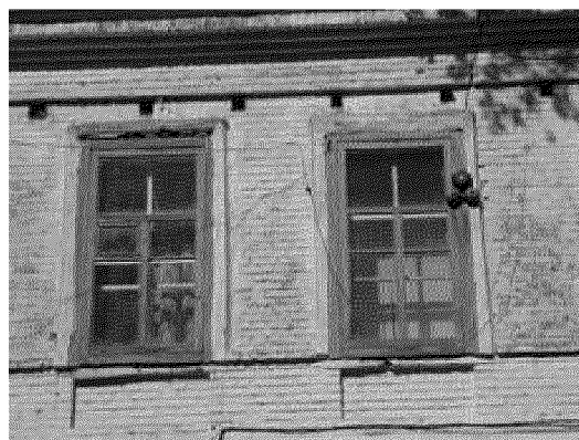
окна в уровне 2-го этажа на юго- западном фасаде
