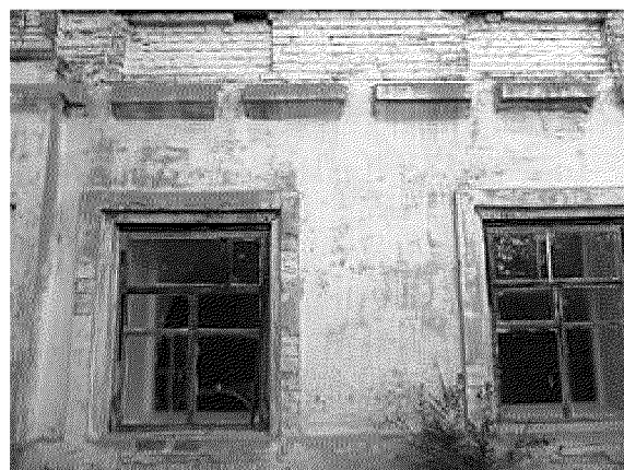
окна в уровне 1-го этажа на юго- восточном фасаде
