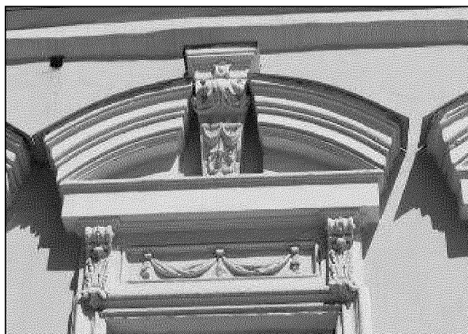
фрагмент парадного южного фасада объекта культурного наследия в уровне первого этажа (дугообразный «разорванный» сандрик на декоративных кронштейнах, оформленных небольшими волютами и вставками лепного растительного орнамента в виде листьев аканта, сложносоставной замковый камень трапецевидной формы в оформлении сандрика оконного проема, надоконная ниша, обрамленная филенкой и лепной декоративной вставкой в виде лепных гирлянд)
