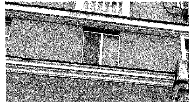
Междуэтажный карниз и подоконная полочка
