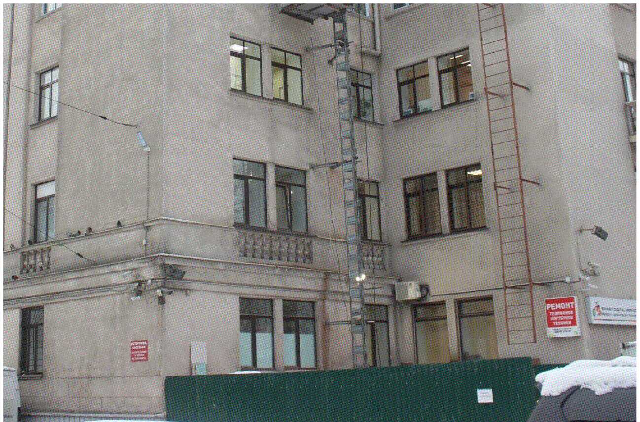
Фото 12. Сдвоенные оконные проемы; архитектурно-декоративные элементы, стилизующие изображение балюстрад; междуетажный карниз, расположенный между 1-м и 2-м этажами, подоконная тяга, расположенная в уровне 2-го этажа
