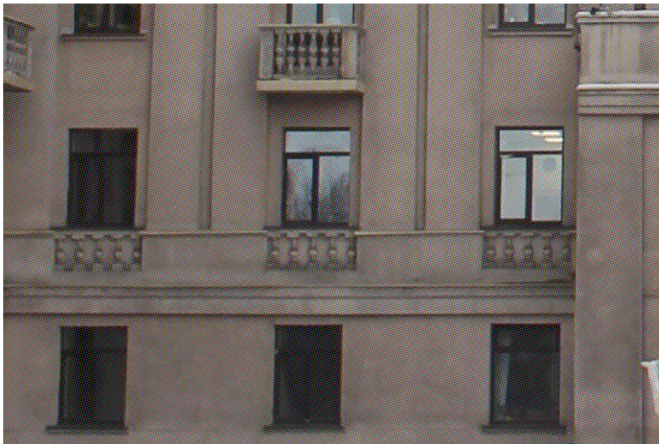
Фото 3. Междуэтажный карниз, расположенный между 1-м и 2-м этажами, подоконная тяга, расположенная в уровне 2-го этажа
