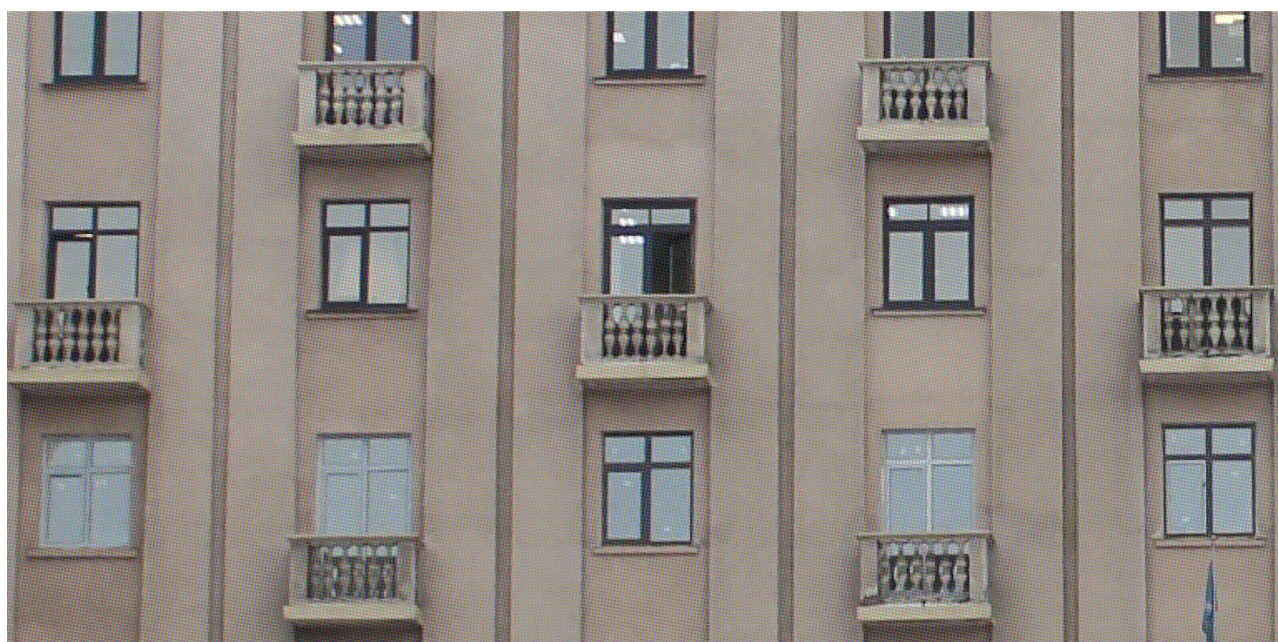
Фото 2. Западный фасад центрального (шестиэтажного) объема, оконные проемы, дверные (балконные) проемы, расположенные в шахматном порядке, с формой ограждений в виде балюстрады
