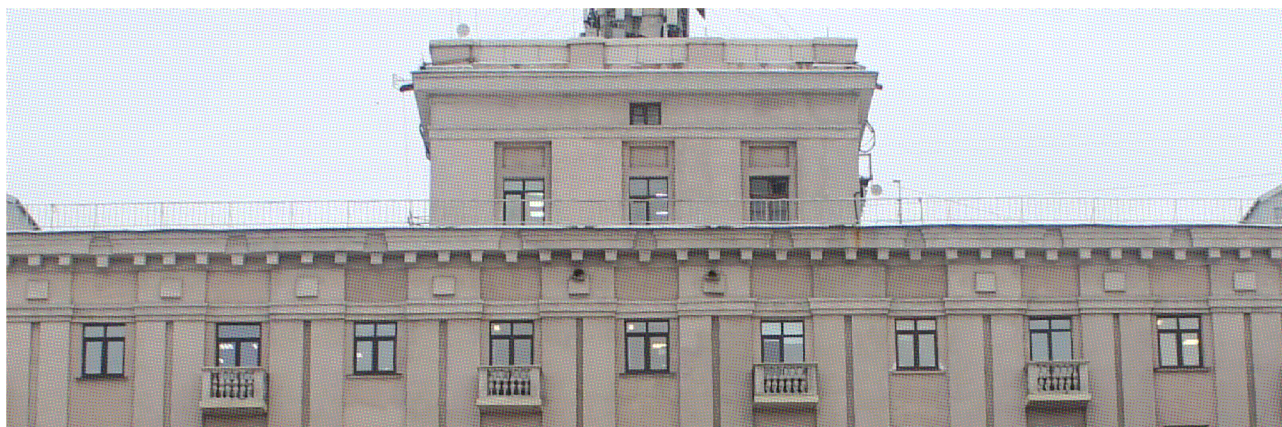
Фото 4. Профилированная тяга над окнами 6-го этажа и венчающий профилированный карниз с кронштейнами и 11 модульонами
