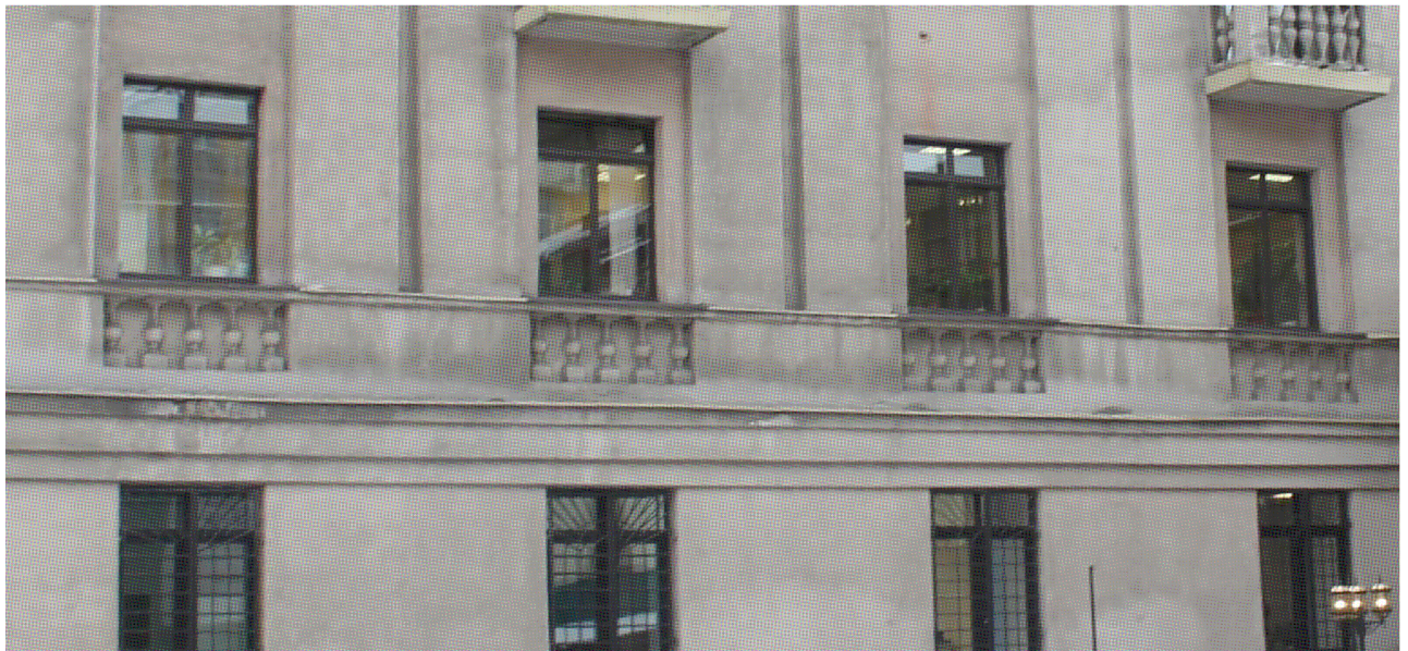
Фото 11. Междуетажный карниз, расположенный между 1 и 2 этажами, подоконная тяга, расположенная в уровне 2-го этажа
