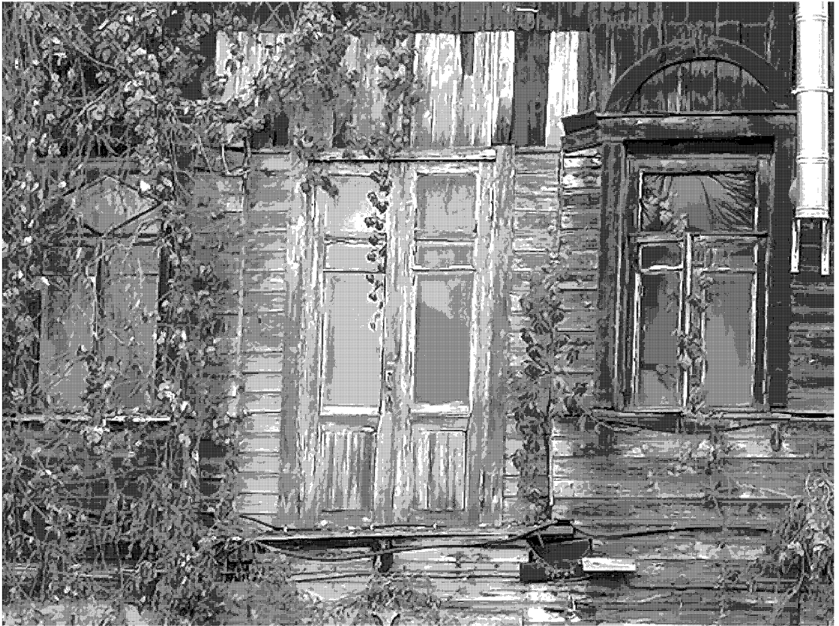
2. Фрагмент восточного фасада здания. Балконный дверной проем и оконные проемы второго этажа.
