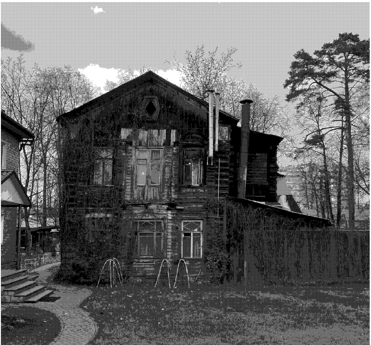
1. Общий вид восточного фасада здания с Ульяновской улицы.
