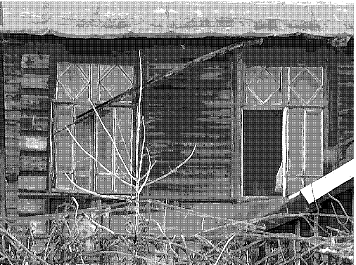
5. Фрагмент северного фасада здания. Оконные проемы второго этажа.
