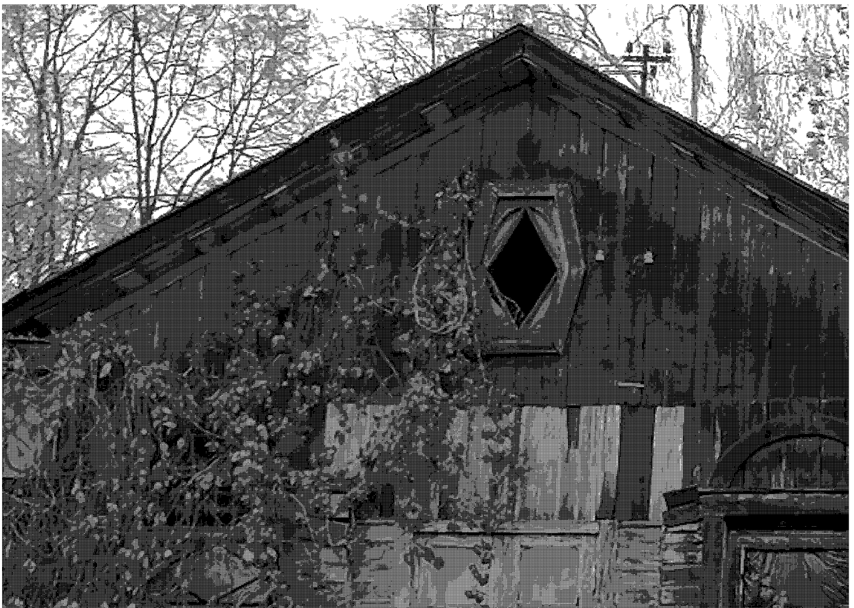
3. Фрагмент восточного фасада здания. Ромбовидный оконный проем фронтона.
