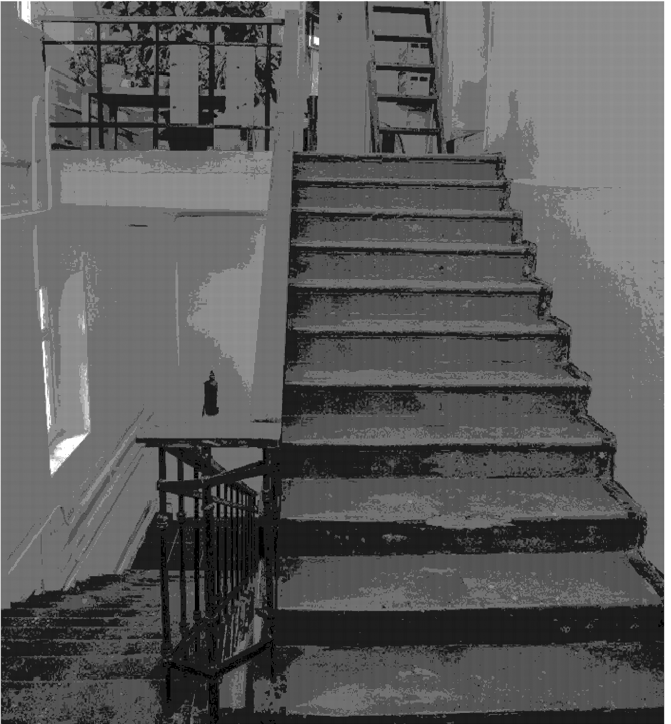
11. Фрагмент интерьера западного объема здания. Лестница запасного входа.
