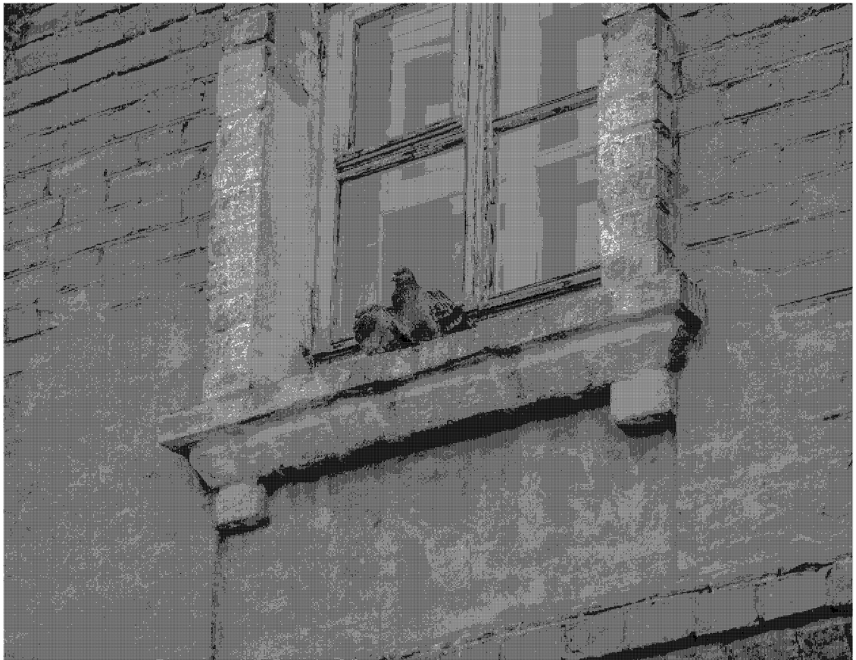
10. Фрагмент южного фасада здания. Окно второго этажа.
