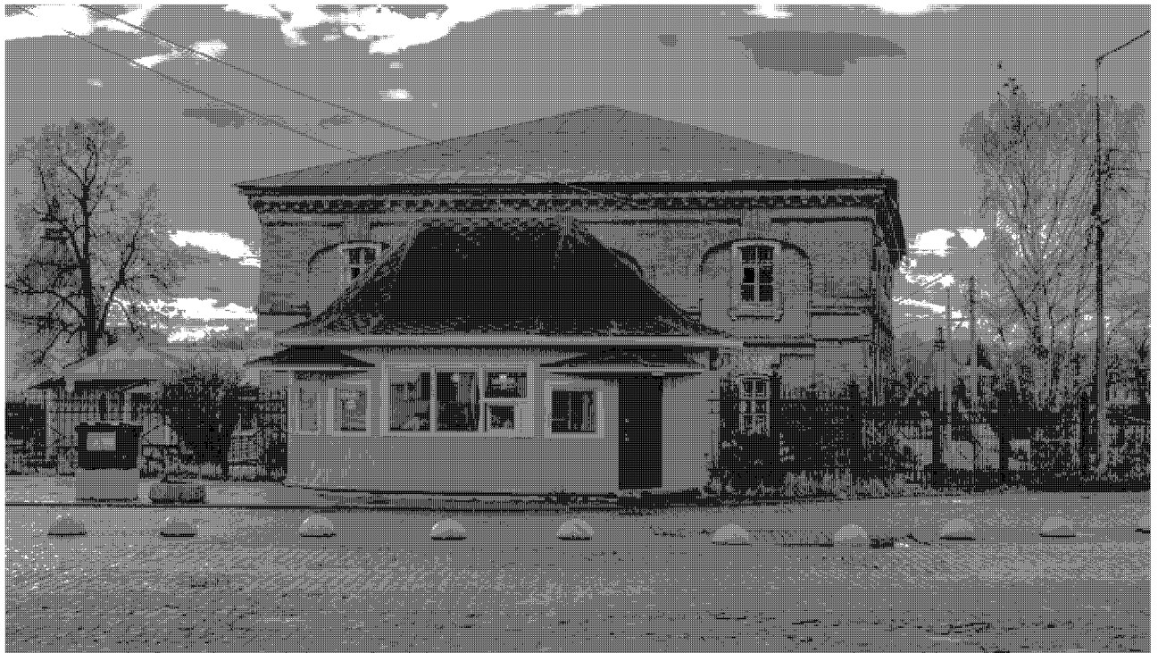
3. Общий вид здания и прилегающей территории с востока.
