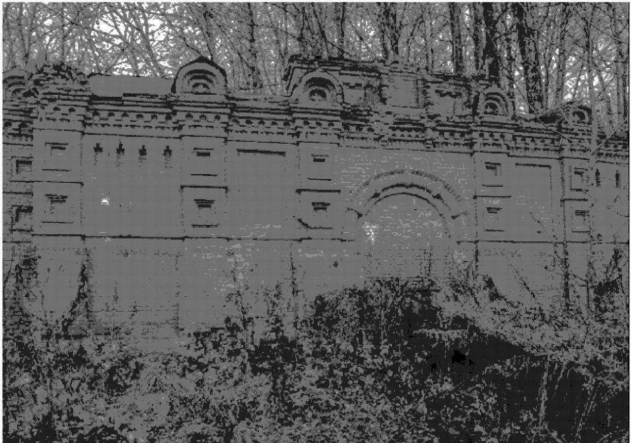
7. Северный участок стены ограды Гефсиманского скита. Северные ворота с утраченной надвратной часовней. Вид с севера.
