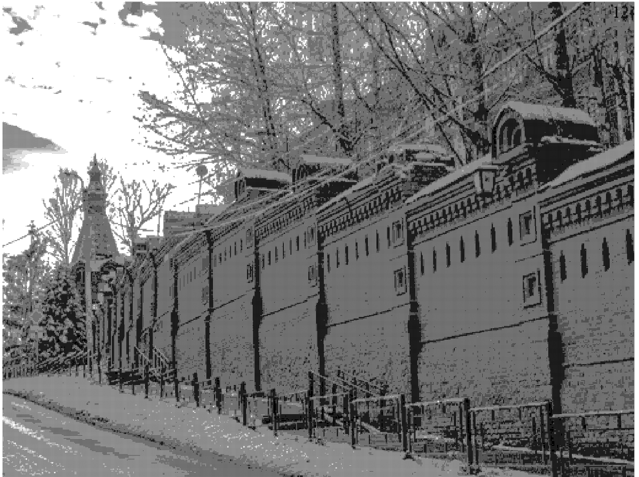
1. Восточный участок стены ограды Гефсиманского скита и Восточная башня. Вид с северо-востока.
