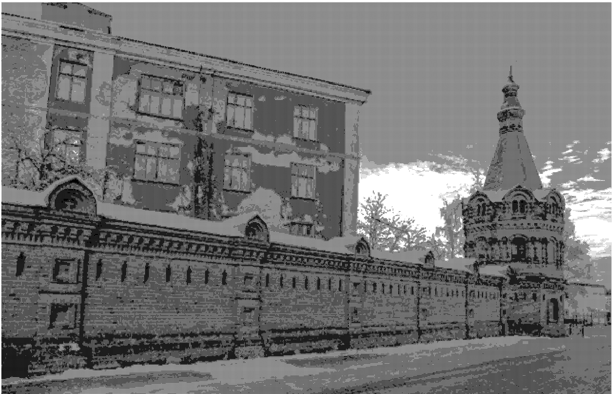
10. Южный участок стены ограды и Восточная угловая башня ограды Гефсиманского скита. Вид с юго-запада.
