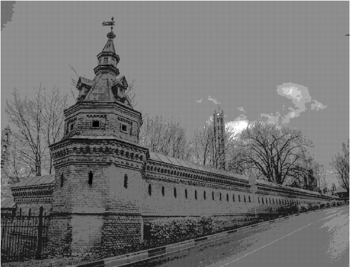
1. Фрагмент северного участка ограды, северная башня и северо-западный участок ограды Пафнутьева сада. Вид с северо-запада.
