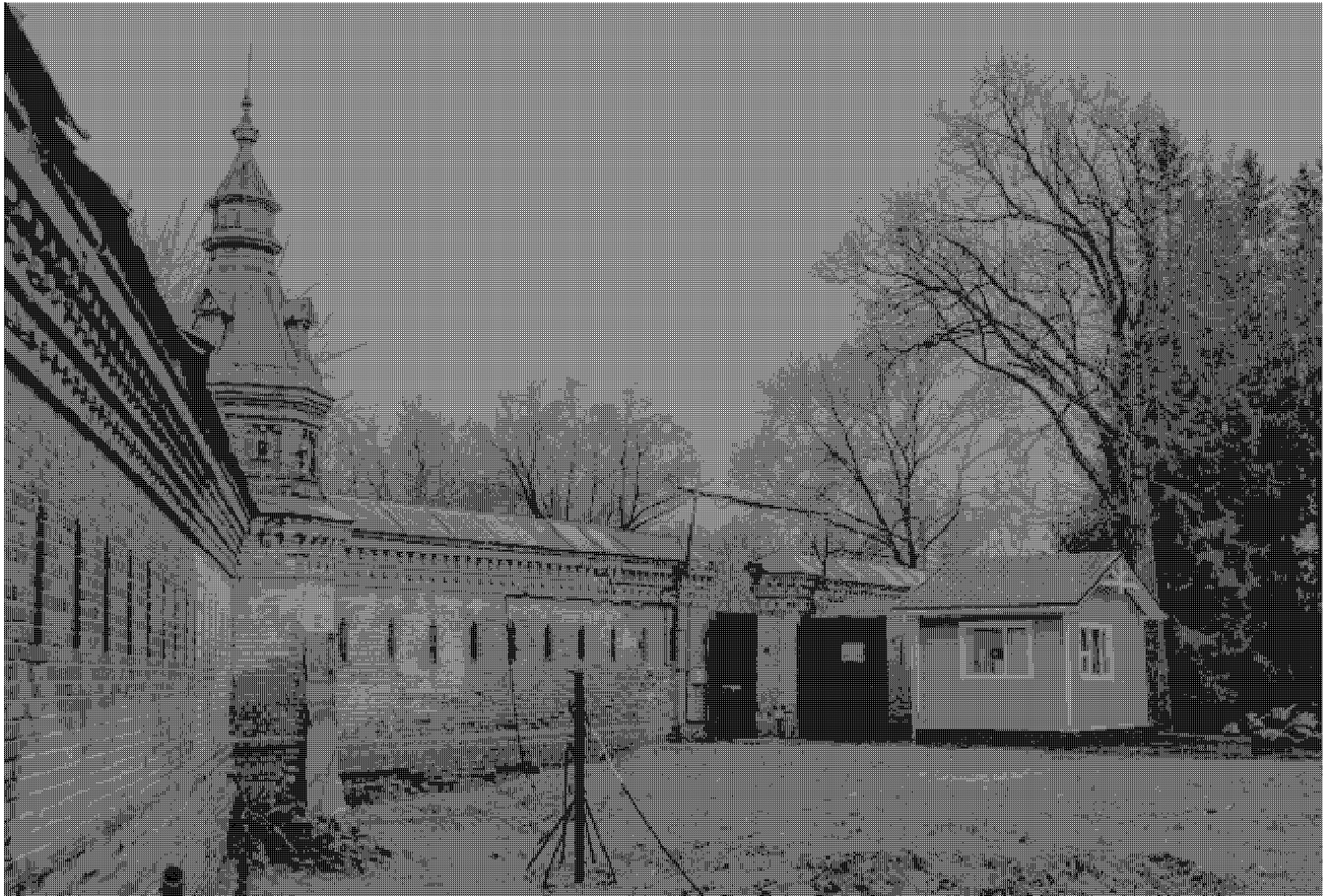
16. Восточный участок ограды, юго-восточная башня ограды Пафнутьева сада и Южные ворота на юго-восточном участке. Вид с северо-востока.
