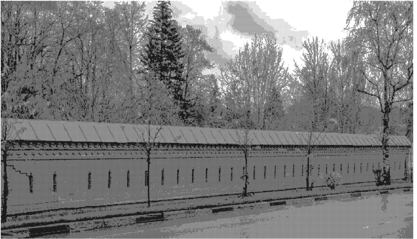
8. Юго-западный участок ограды Пафнутьева сада. Вид с северо-запада.
