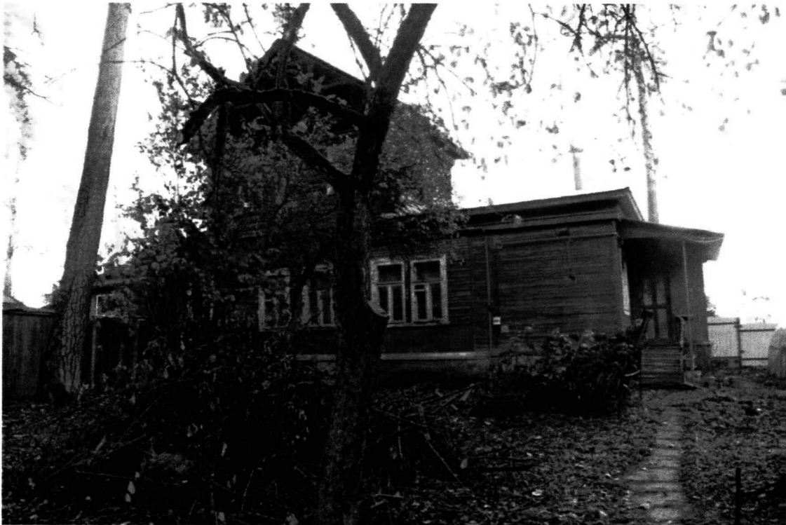
3. Западный фасад здания, вид с юго-запада.
