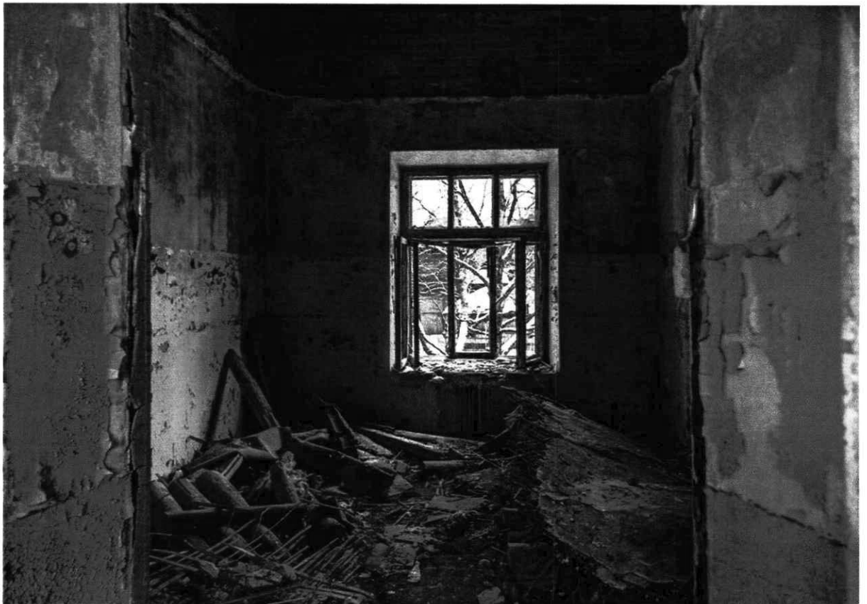
9. Помещение на втором этаже здания.
