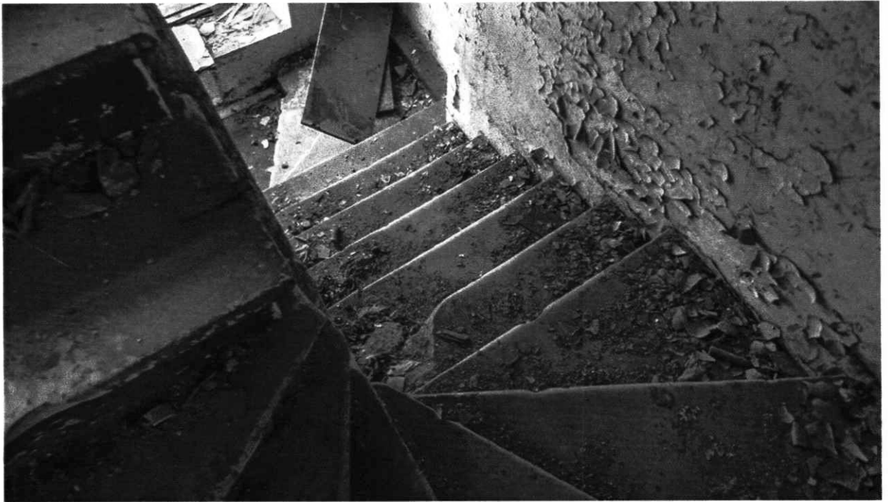
10. Входная лестница со стороны бокового западного фасада на уровне между первым и вторым этажом здания.
