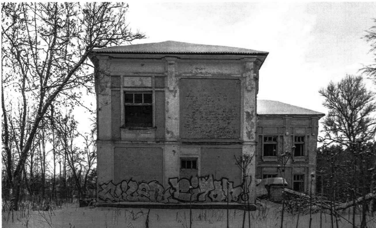
4. Общий вид на здание с востока.
