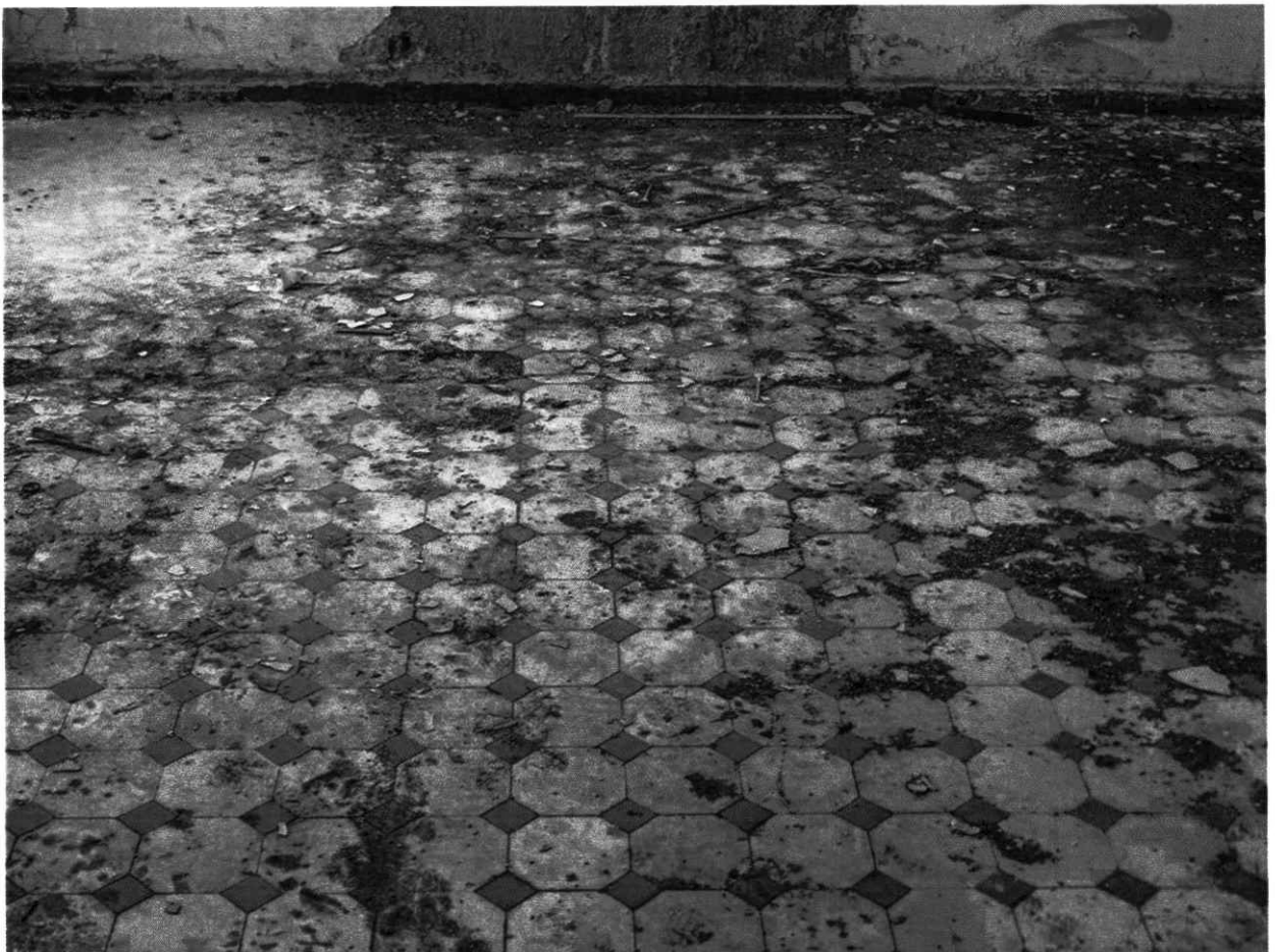
11. Напольное покрытие (метлахская плитка 1909–1914 гг.) на втором этаже основной части здания.
