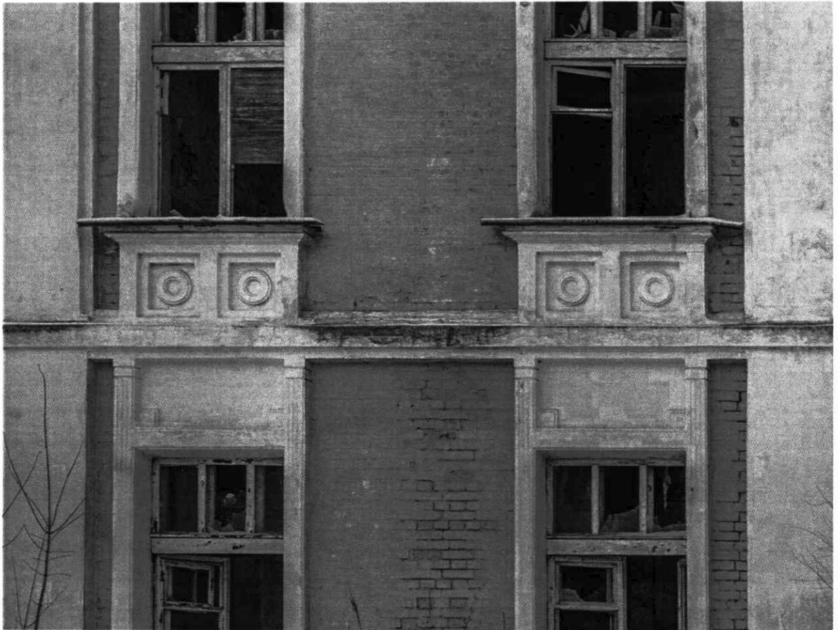
8. Вид на подоконные фартуки двух типов.
