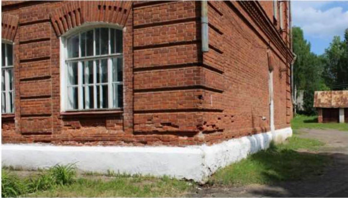
Фото 13. Венчающий многообломный карниз на трехступенчатых консолях; Рустованные лопатки в уровне 1-го и 2-го этажей, расположенные по углам здания и в простенках юго-западного фасада; Выступающий фриз с поребриком, проходящий по периметрам основного объема и юго-западного ризалита; Междуэтажный карниз с сухариками и небольшим гладким фризом; Прямоугольные подоконные ниши в ширину оконных проемов 1-го и 2-го этажей всех фасадов основного объема и юго-западного ризалита, включающие п-образную подоконную доску; Лучковые перемычки проемов с правого и левого флангов в уровне 2-го этажа юго-западного фасада; Выступающие лучковые перемычки с гребенчатым кирпичным узором и широким выделенным замковым камнем проемов в уровне 1-го этажа юго-западного фасада основного объема, в уровне 1-го и 2-го этажей юго-восточного, северо-восточного, северо-западного фасадов основного объема и северо-восточного и юго-западного ризалитов
