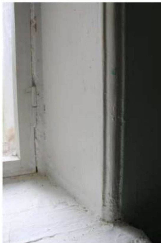
Фото 3. Тянутый профилированный наличник в оформлении оконных проемов 1-го и 2-го этажей изнутри здания.
