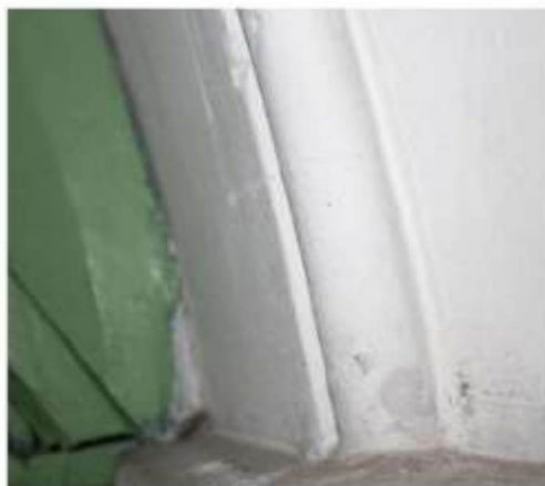
Фото 2. Оформление арочных проемов с коробовым завершением 1-го этажа.
