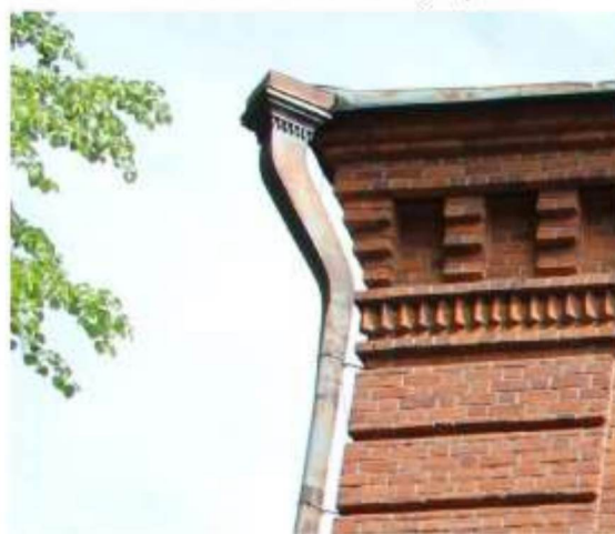
Фото 17. Металлические чаши водостока четырехгранной конфигурации, увенчанные ступенчатым поясом и полосой из сухариков.
