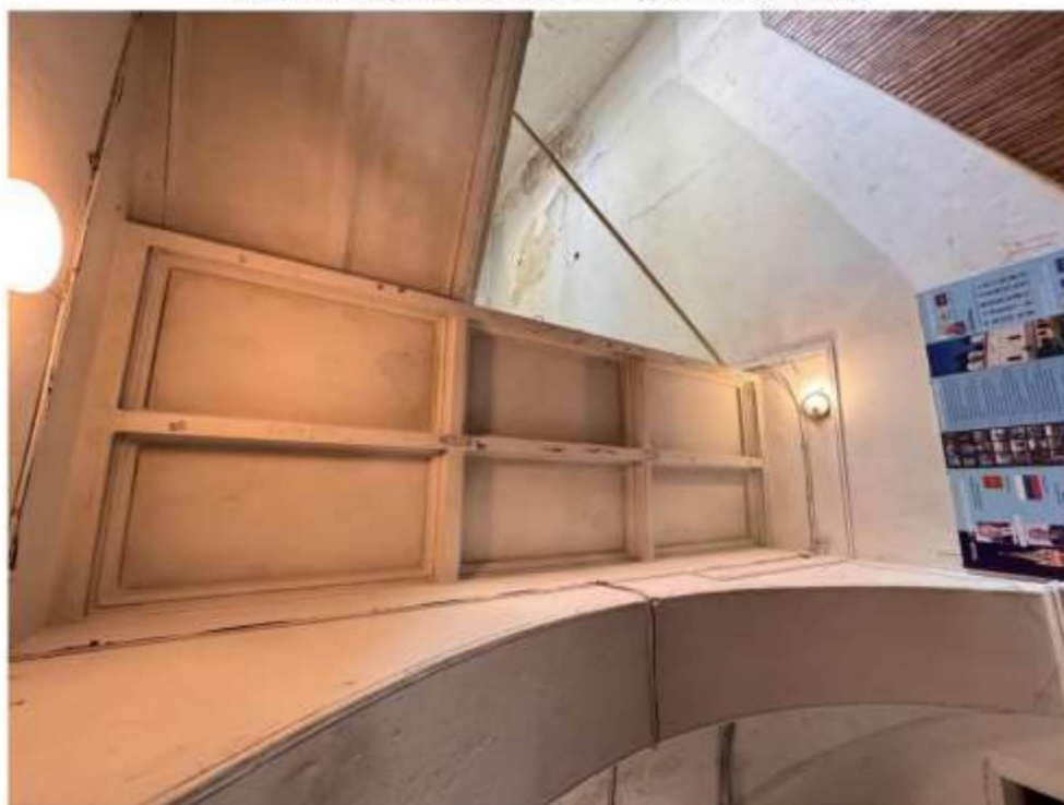
Фото 11. Тяги и рисунок в оформлении кессонированного потолка площадки парадной лестницы в уровне 2-го этажа.
