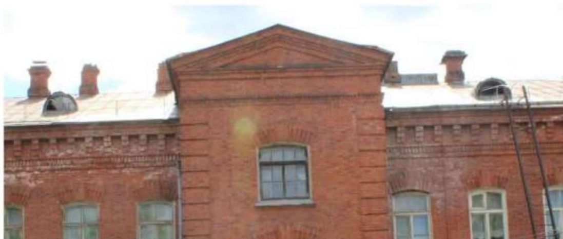
Фото 16. Венчающий карниз фронтона ризалита северо-восточного фасада; Поясок с лентой поребрика северо-восточного ризалита под венчающим карнизом.
