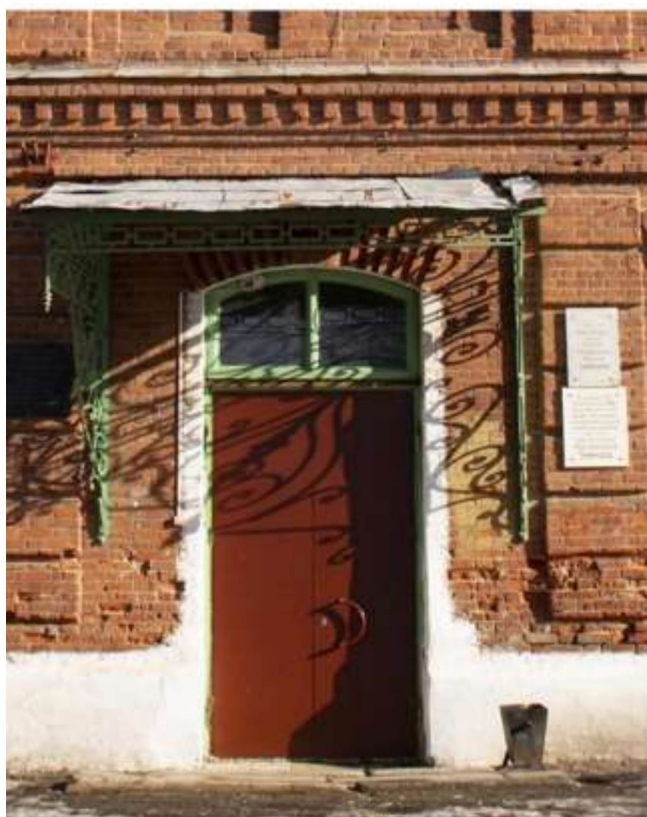
Фото 19, 20. Односкатный кованный козырек на ажурных кронштейнах.
