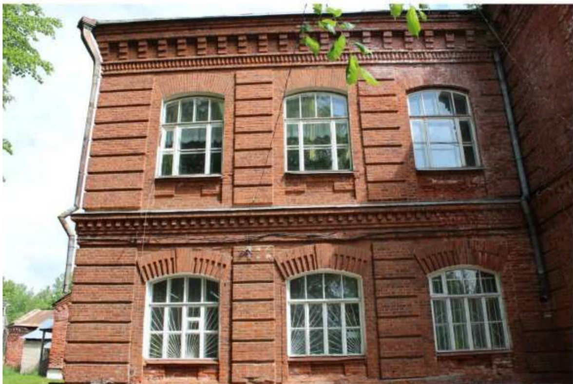
Фото 13. Венчающий многообломный карниз на трехступенчатых консолях; Рустованные лопатки в уровне 1-го и 2-го этажей, расположенные по углам здания и в простенках юго-западного фасада; Выступающий фриз с поребриком, проходящий по периметрам основного объема и юго-западного ризалита; Междуэтажный карниз с сухариками и небольшим гладким фризом; Прямоугольные подоконные ниши в ширину оконных проемов 1-го и 2-го этажей всех фасадов основного объема и юго-западного ризалита, включающие п-образную подоконную доску; Лучковые перемычки проемов с правого и левого флангов в уровне 2-го этажа юго-западного фасада; Выступающие лучковые перемычки с гребенчатым кирпичным узором и широким выделенным замковым камнем проемов в уровне 1-го этажа юго-западного фасада основного объема, в уровне 1-го и 2-го этажей юго-восточного, северо-восточного, северо-западного фасадов основного объема и северо-восточного и юго-западного ризалитов
