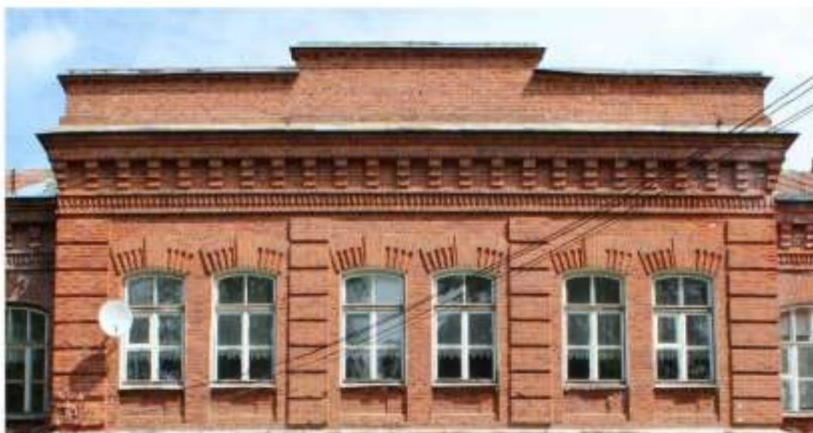
Фото 16. Венчающий карниз фронтона ризалита северо-восточного фасада; Поясок с лентой поребрика северо-восточного ризалита под венчающим карнизом.
