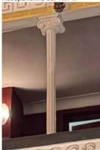
Колонны, поддерживающие ярусы зрительного зала. Изображение 33. Тип 4.
