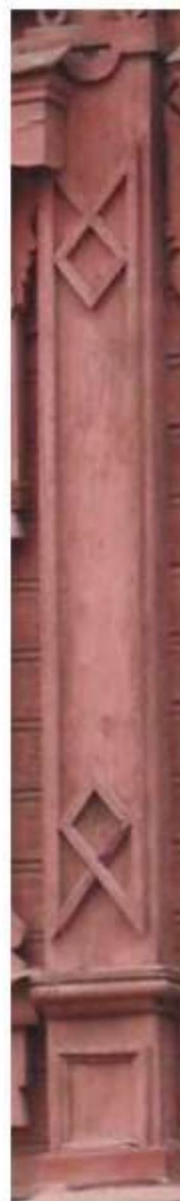
Вид зашивки и оформления переруба в уровне второго этажа
