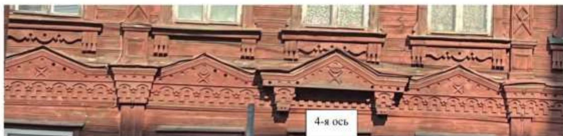
Вид междуэтажного пояса юго-западного фасада с выступающим по 4-ой оси фронтоном на резных кронштейнах относительно остальных пологих
