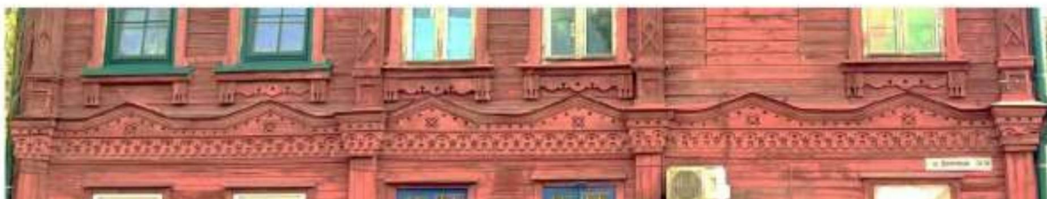
Вид междуэтажного пояса северо-западного фасада
