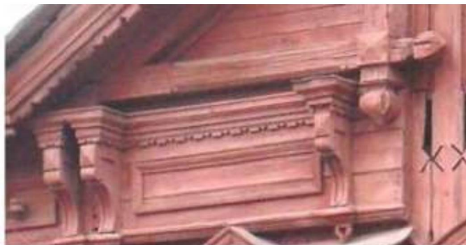
Увеличенный фрагмент деталей карнизного фриз и перекрестных элементов тимпана щипцового подвышения
