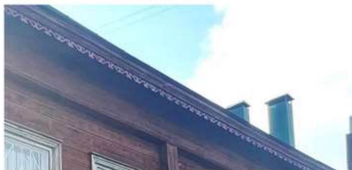
Фрагмент северо-восточного фасада с пропиленным подзором
