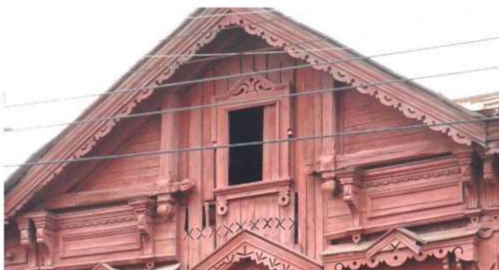
Вид оформления карнизного фриза, чердачных окошек в щипцовых подвышениях, вид оформления тимпана щипцовых подвышений.
