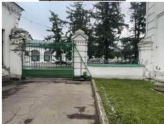
Ограда. Вид со двора
