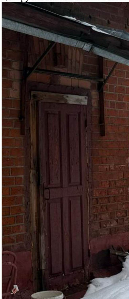
Дверной проем северо-восточного фасада
