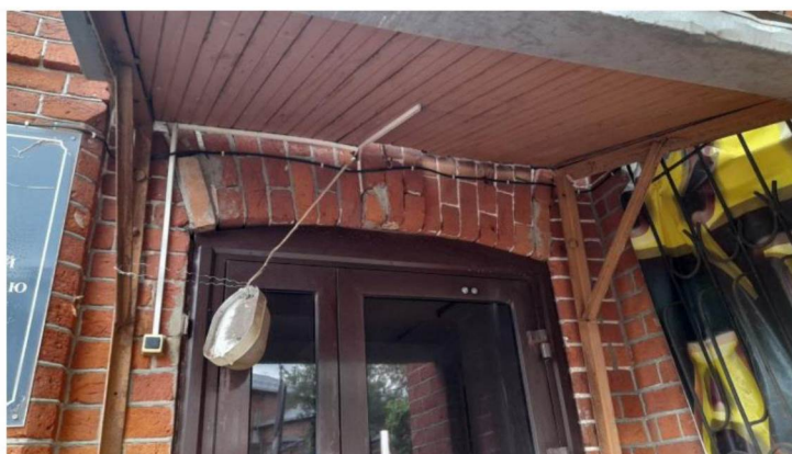
Дверной проем северо-западного фасада
