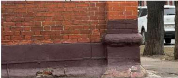
Фрагмент цоколя по северо-восточному фасаду
