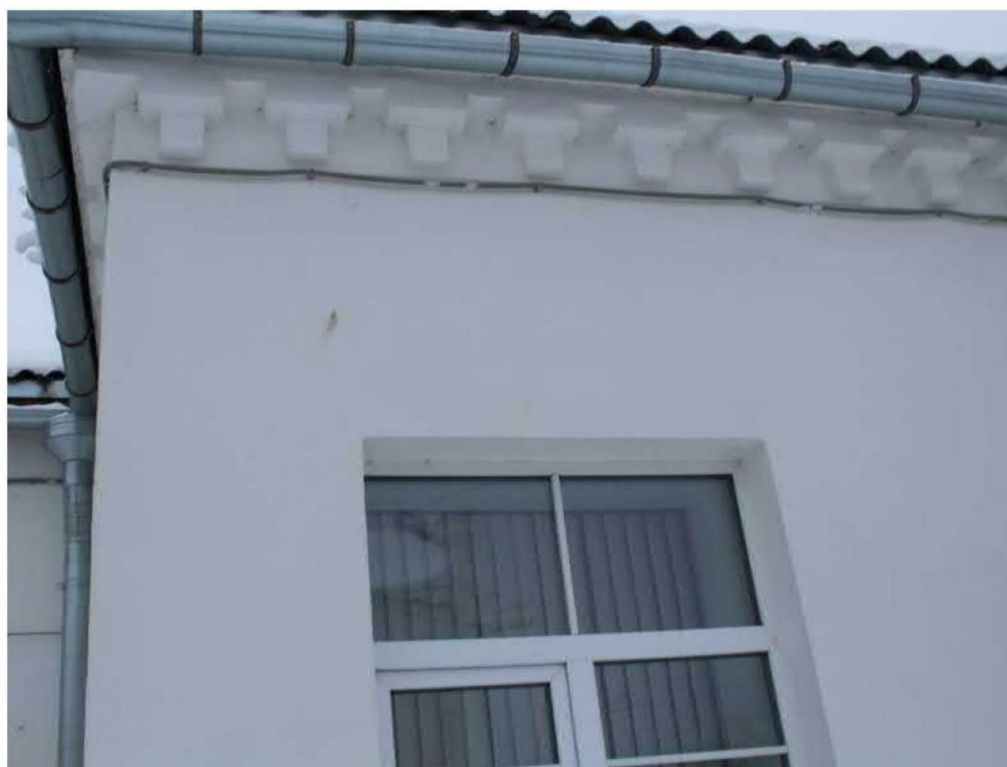
Фрагмент восточного фасада. Фото 20.01.2026 г.
