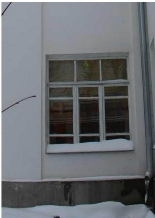
Фрагмент северного фасада. Окно первого этажа двухэтажного объема здания. Фото 20.01.2026 г.
