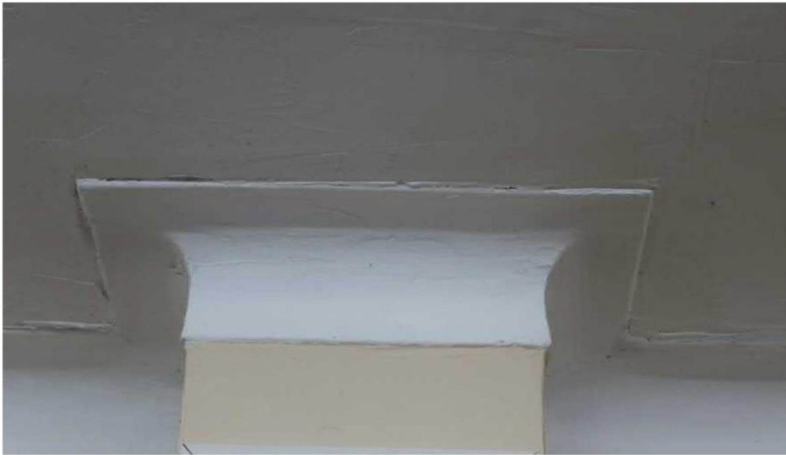
Тянутый декор интерьера помещения первого этажа двухэтажного объема здания. Фото 20.01.2026 г.
