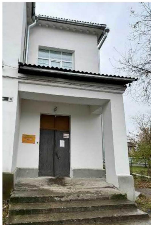
Фрагмент северного фасада. Фото 10.09.2025 г.
