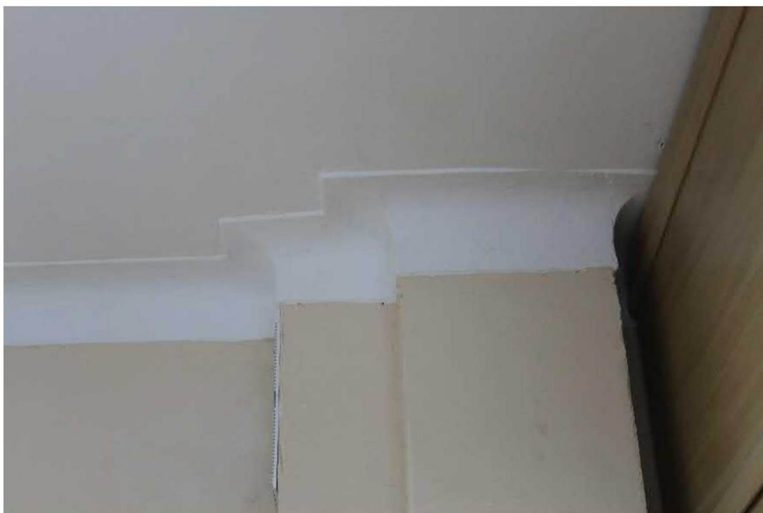
Тянутый декор интерьера помещения первого этажа двухэтажного объема здания. Фото 20.01.2026 г.
