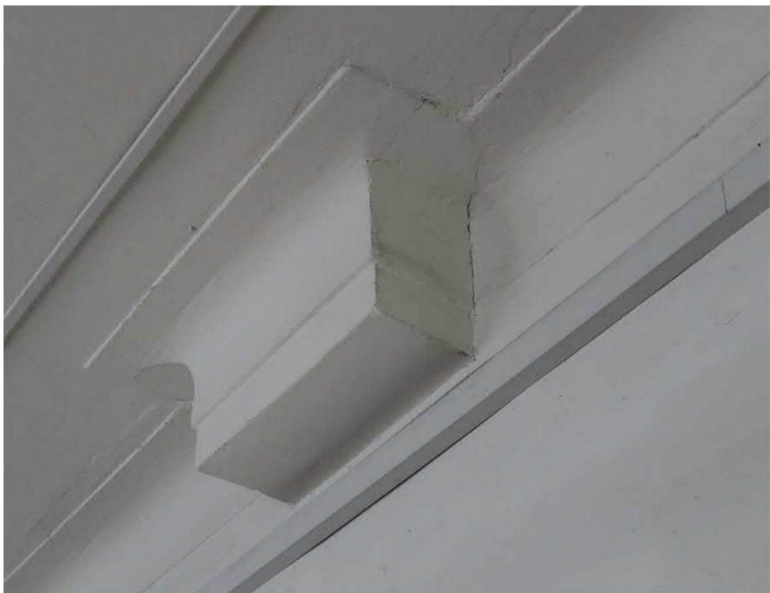
Тянутый декор интерьера помещения первого этажа двухэтажного объема здания. Фото 20.01.2026 г.
