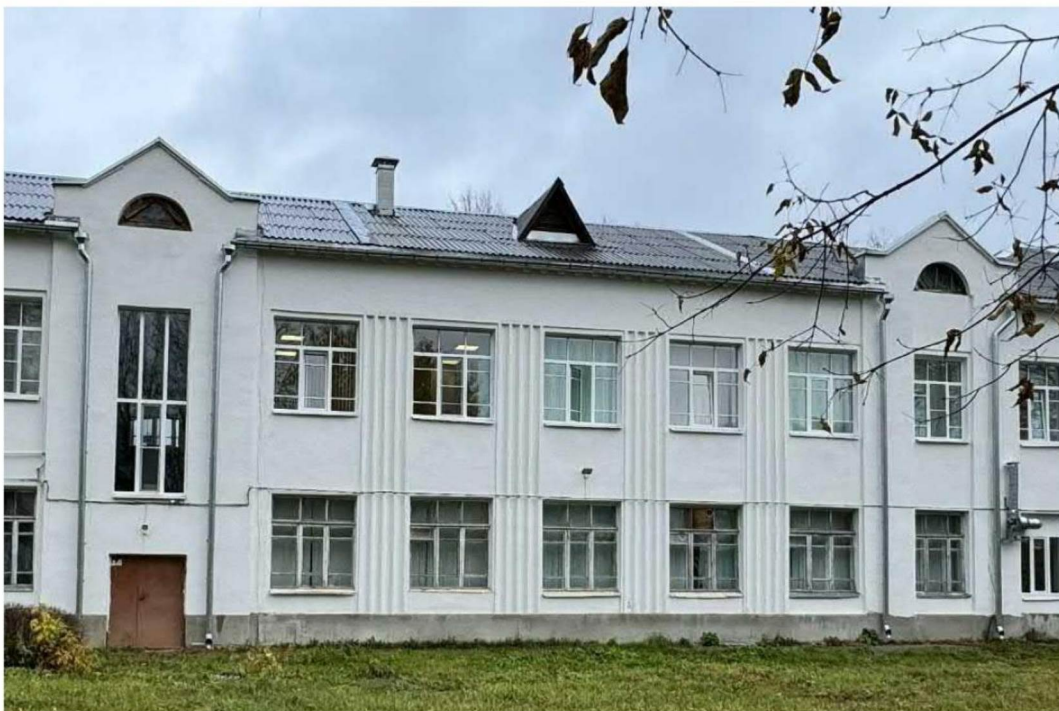
Фрагмент южного фасада. Ризалиты. Фото 10.09.2025 г.
