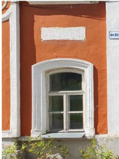
Оконный проём первого этажа северо-восточного фасада. Позиция 13.
