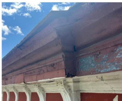
Фрагмент выноса кровли, подшит деревом, лобовая доска обита металлическим листом.
