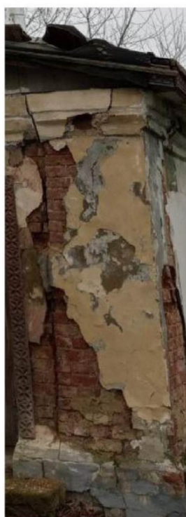
Фрагмент лопатки, выделенной кирпичной кладкой по углам пристройки (литера а1), северо-восточный фасад.
