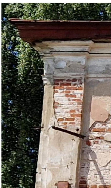
Фрагмент лопатки, выделенной кирпичной кладкой по углам объёмов объёма (литера А), трехэтажный объем, юго-западный фасад.
