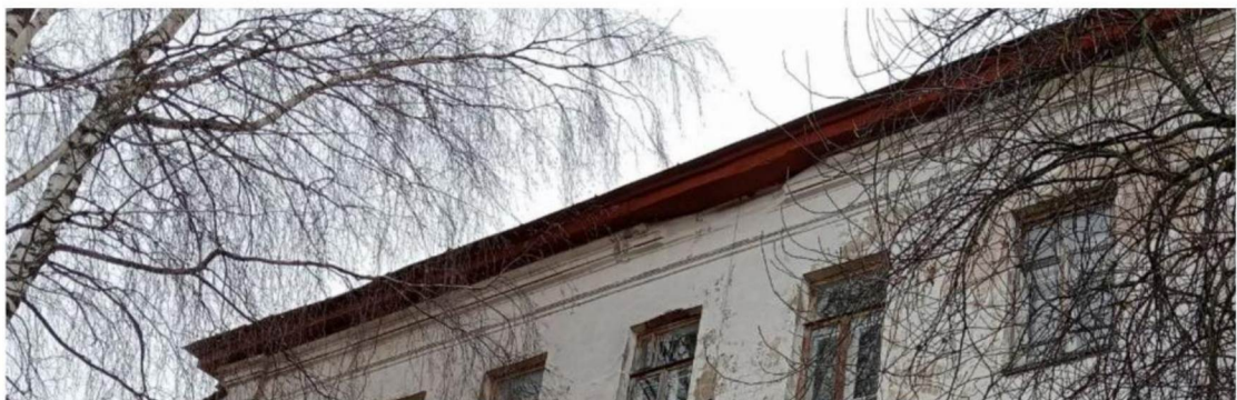
Фрагмент венчающего карниза трёхэтажного объёма юго-западного фасада.
