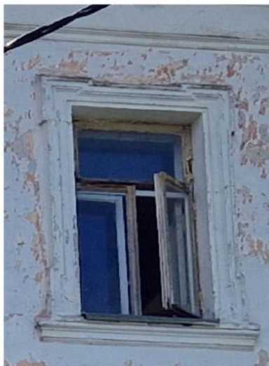
Оконный проём трёхэтажного объёма, северо-западный фасад, третий этаж, позиция 3, согласно схеме
