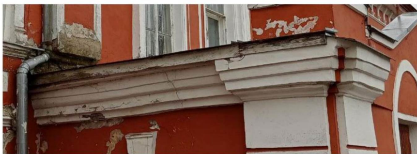
Венчающий карниз парадного входа. Юго-восточный фасад.
