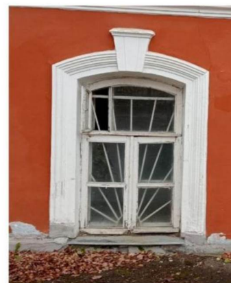
Отливы подоконных ниш - металлические.
