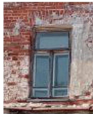
Оконный проём трёхэтажного объёма, юго-восточный фасад, третий этаж, позиция 2, согласно схеме
