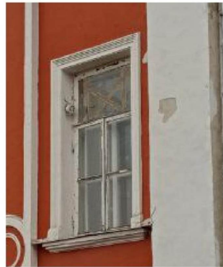
Оконный проём второго этажа северо-восточного фасада. Позиция 13.
