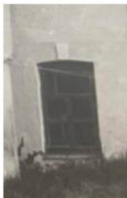
Оконный проём первого этажа, юго-восточного фасада. Позиция 1, согласно схеме
