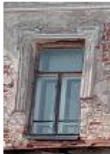
Оконный проём трёхэтажного объёма, юго-восточный фасад, третий этаж, позиция 4, согласно схеме
