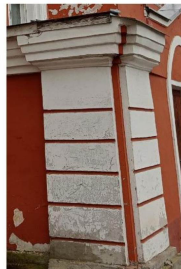
Рустованные углы, выделенные венчающим карнизом парадного входа.
