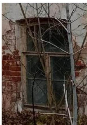
Оконный проём первого этажа, юго-восточного фасада. Позиция 1, согласно схеме
