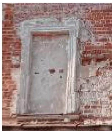
Оконный проём (ниша) трёхэтажного объёма, юго-восточный фасад, третий этаж, позиция 3, согласно схеме
