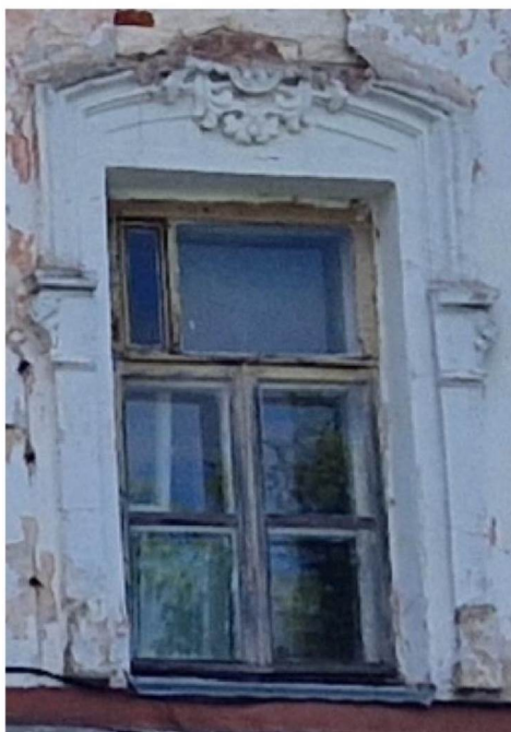
Оконный проём двухэтажного объёма, северо-западный фасад второго этажа, позиция 1, согласно схеме
