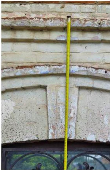
Главный южный фасад. Окно 1 этажа. Дуговые тонкие сандрики-бровки, с клинчатым замковым камнем по центру над окнами.
