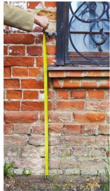
Главный южный фасад. Окно 1 этажа. Двухступенчатая полочка под окнами. Нештукатуренный цоколь, с незначительным выступом, с кромкой в виде полувалика.
