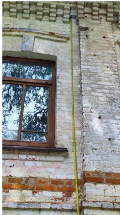
Главный южный фасад. Второй этаж. Венчающий профилированный карниз. Окно. Пилыстра, гладкая лопатка.
