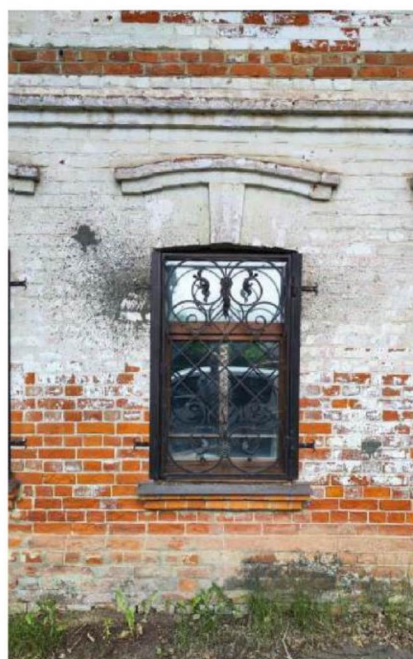
Главный южный фасад. Междуэтажный раскрепованный карниз между 1 и 2 этажами. Окно 1 этажа.
