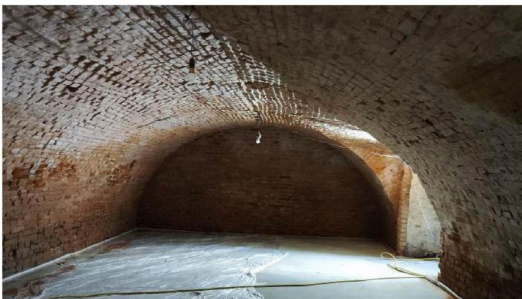
Подвал. Полулотковый свод. Распалубка над дверным проемом.
