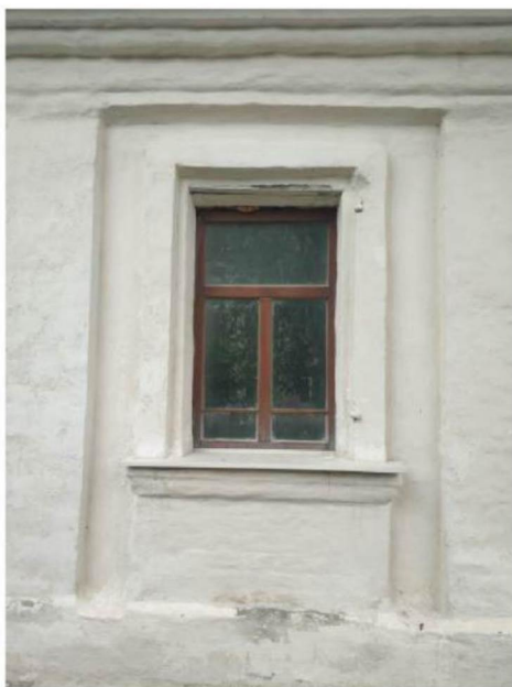
Главный южный фасад. Высокие прямоугольные ниши. Рамочные наличники по контуру с профилированными подоконниками, опирающимися на прямоугольные накладные доски оконных проемов.
