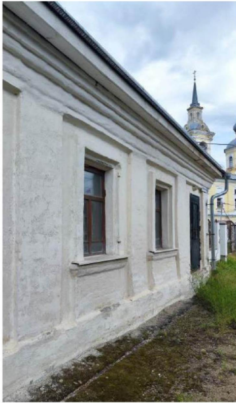
Главный южный фасад.
