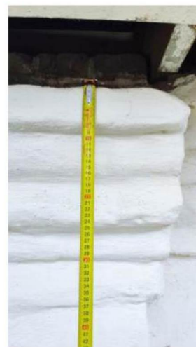
Восточный фасад. Венчающий карниз.
