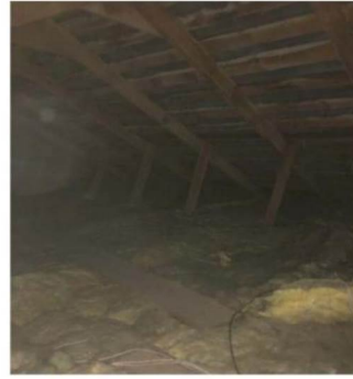
Фрагмент стропильной системы крыши.
