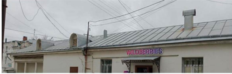
Фрагмент кровли восточного объема здания.
