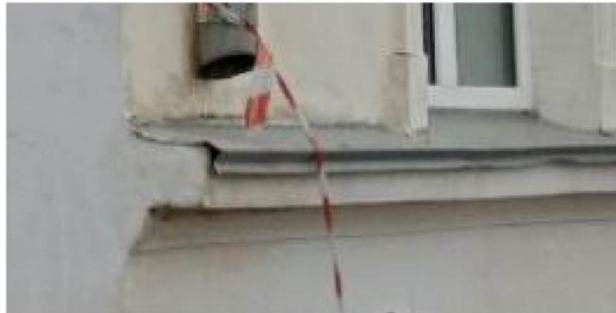
Фрагмент отлива подоконной полки южного фасада.
