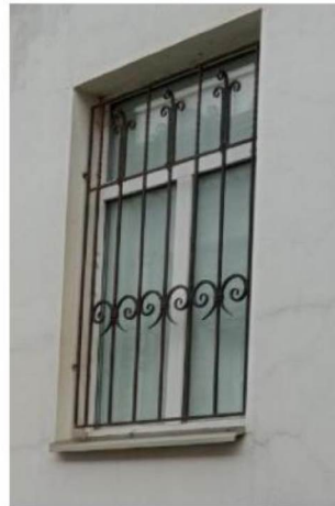
Фрагмент отлива подоконной ниши западного фасада.
