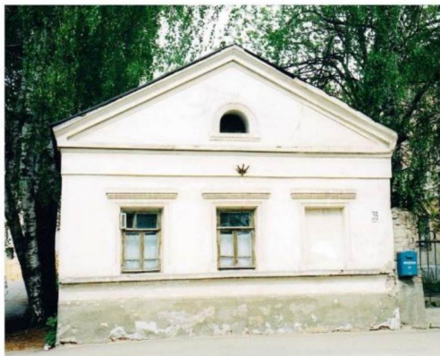
Главный (южный фасад)
