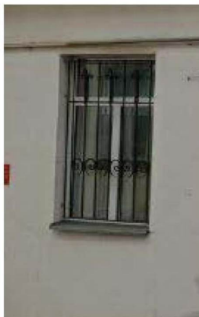
Фрагмент отлива подоконной ниши восточного фасада.
