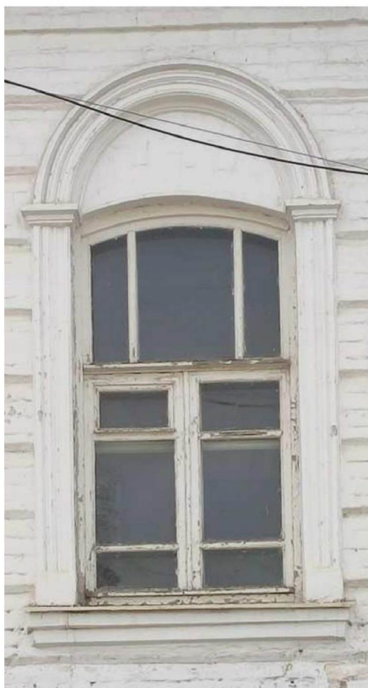
Окно второго этажа северного и восточного фасадов. Штукатурные профилированные наличники в виде канелированных пилястр с капителями по бокам с полуциркулярным андриком-архивольтом в завершении окон и двухступенчатыми полочками под окнами.
