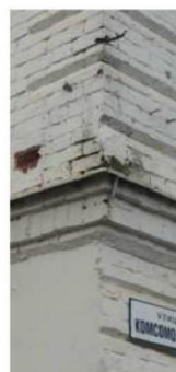
Междуэтажный раскрепованный профилированный карниз между 1-м и 2-м этажами. Главный северный фасад.
