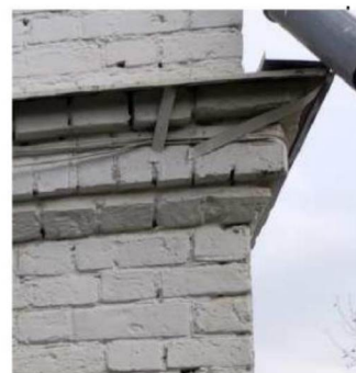
Междуэтажный раскрепованный профилированный карниз между 1-м и 2-м этажами с металлическим отливом. Дворовый южный фасад.
