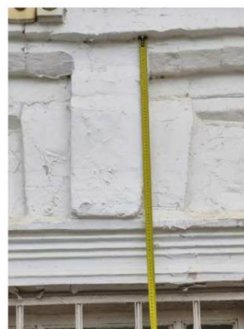
Элемент окна первого этажа главного фасада. Деталь широкого много- ступенчатого веерного клинчатого замкового камня над окном.
