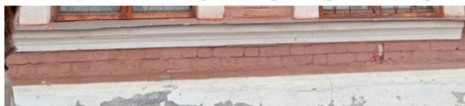
1-й этаж. Профилированный карниз над цоколем.
