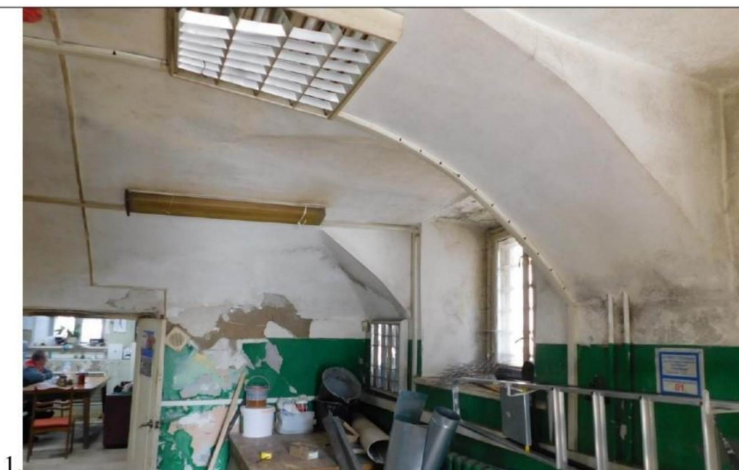
Схема расположения коробовых сводов с распалубками над проемами
