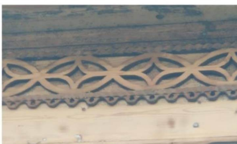
Лента накладной профилированной резьбы в завершении фриза главного фасада.
