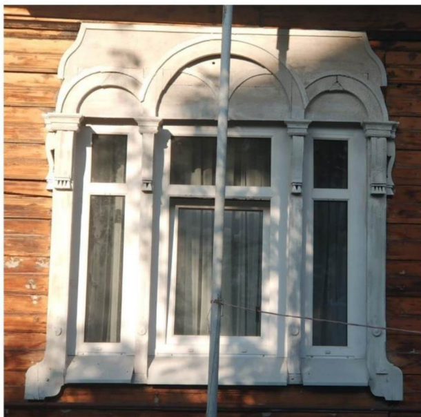
Широкое тройное окно, объединенные рамочные деревянные с фигурным тройным навершием фрамуги
